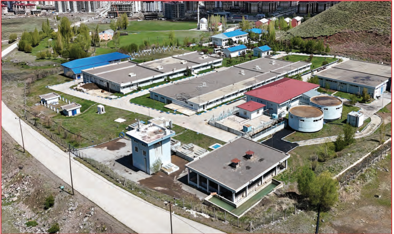
Erzurum İçme Suyu Arıtma Tesisİ Görünümü
