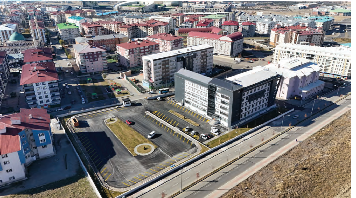
Yeni İdare Binası
