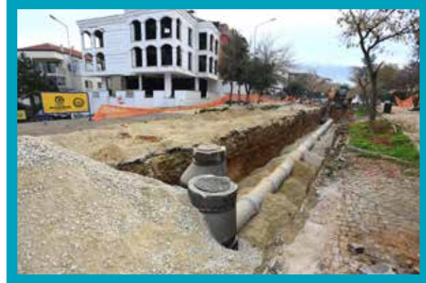
Çamlık Bulvarı Kanalizasyon ve Yağmursuyu Hattı Yapımı
