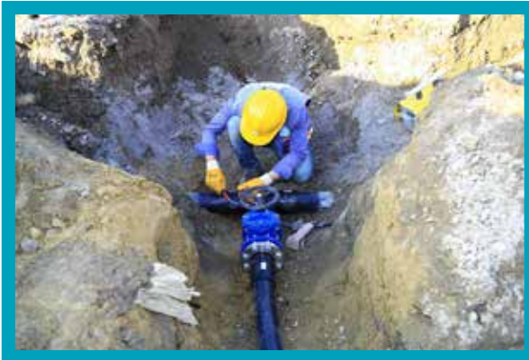
Honaz-Haydar Mahallesi İçmesuyu Hattı Yapımı
