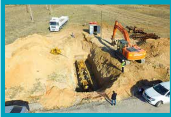
Çivril İlçesi Gürpınar Mahallesi Yatay Sondaj Çalışması
