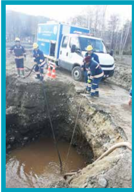
Beyağaç İlçesi Kanalizasyon Arıza Tamirâtı
