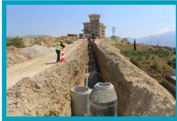
Merkezefendi İlçesi Sevindik Mahallesi Ø300 mm Kanalizasyon ve Ø600 mm Yağmursuyu Hattı İmalatı
