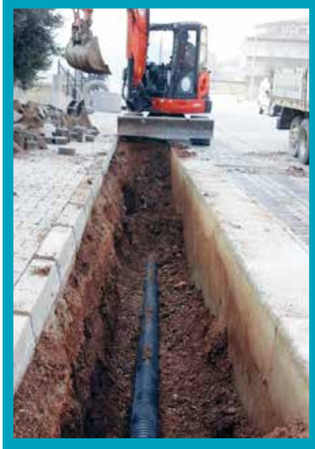
Pamukkale İlçesi Kervansaray Mahallesi Ø300 mm Kanalizasyon Hattı İmalatı
