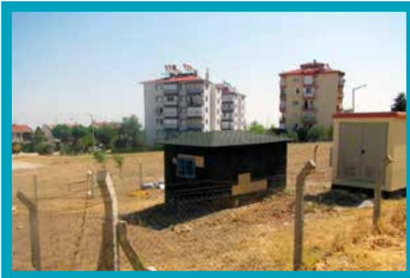
Merkezefendi İlçesi Servergazi Mahallesi-3 Derin Kuyu Eski Hali
