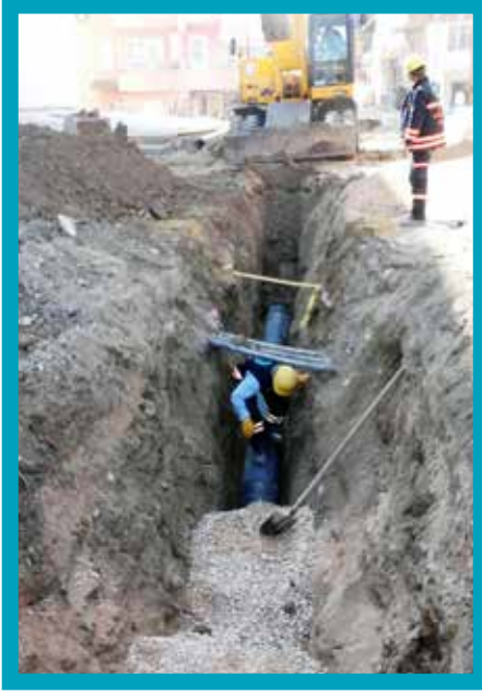
Pamukkale İlçesi İncilipınar Mahallesi Ø400 mm Yağmursuyu Hattı İmalatı
