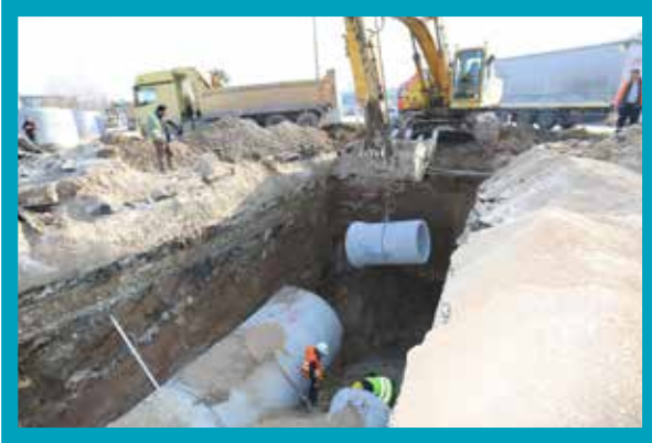
Üçgen Kavşağı Yağmursuyu ve Kanalizasyon Hattı Yapımı
