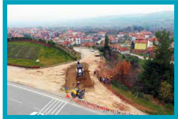
Pamukkale İlçesi Tekke Mahallesi Yatay Sondaj Çalışması
