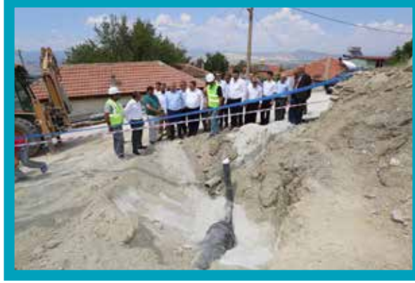
Honaz –Haydar Mahallesi Kanalizasyon Hattı Yapımı
