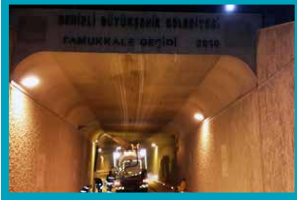
Merkezefendi İlçesi Sevindik Mahallesi Pamukkale Tüp Geçidi Kombine Temizliği
