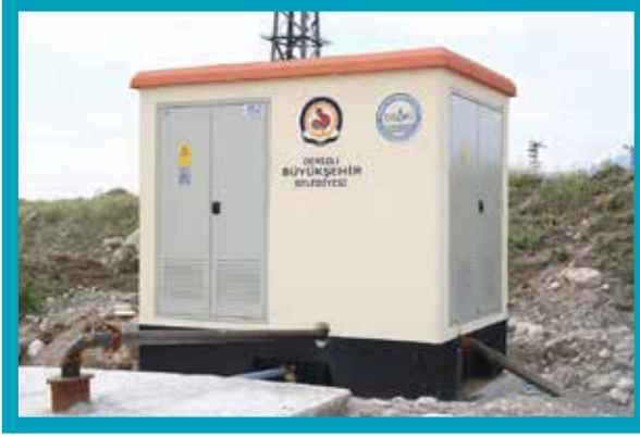
Yeni Sondaj Kuyularının ve Kabinlerinin Yenilenmesi Çalışması
