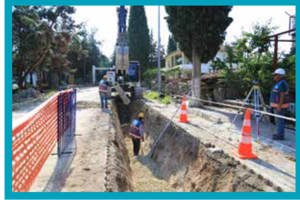
Çal Merkez Kanalizasyon Hattı Yapımı
