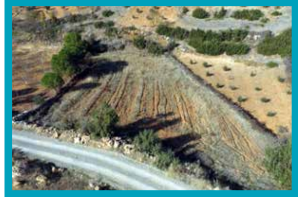
Kale Gölbaşı Paket Atıksu Arıtma Tesisi EK-6 Yerinde İnceleme
