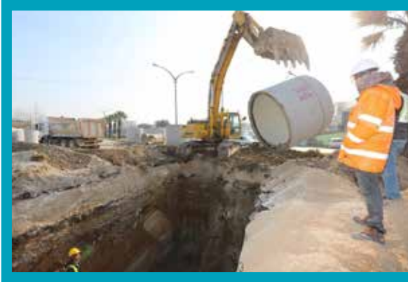
Üçgen Kavşağı Yağmursuyu ve Kanalizasyon Hattı Yapımı
