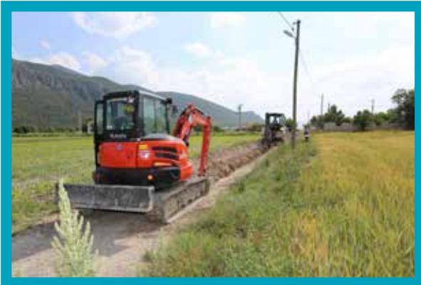
Çardak İlçesi Çaltı Mahallesi İçmesuyu Hattı İmalatı
