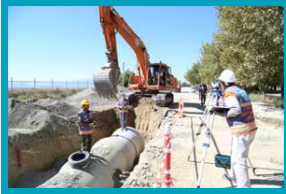
Çardak İlçesi Merkez Mahallelerinde Yağmursuyu Hattı Yapımı
