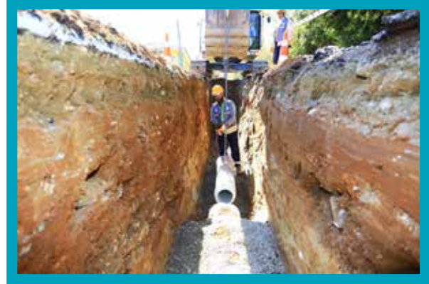
Babadağ Kelleci Kanalizasyon Hattı Yapımı
