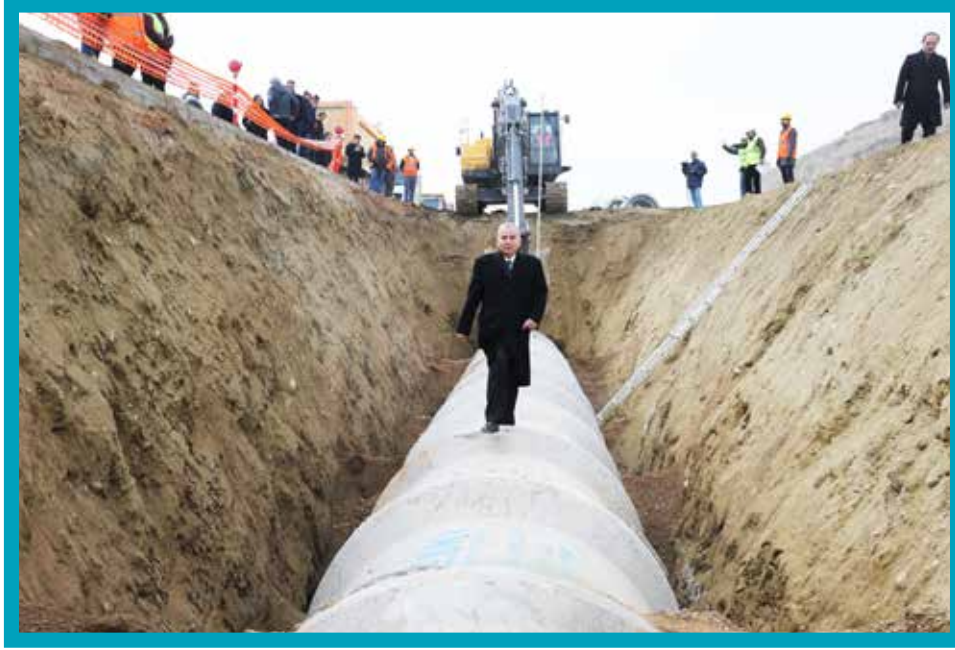
Merkezefendi Bozburun Yağmursuyu Hattı Yapımı
