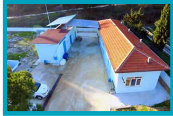
Çamlık Klor Depolama ve Dağıtım Alanı
