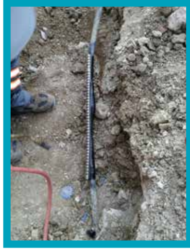
Kazı Esnasında Kopan Kablo Tamiri-Sonrası
