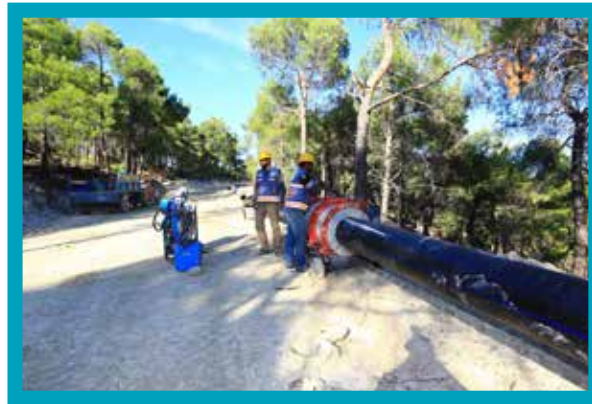
Buldan İçmesuyu İsale Hattı Yapımı
