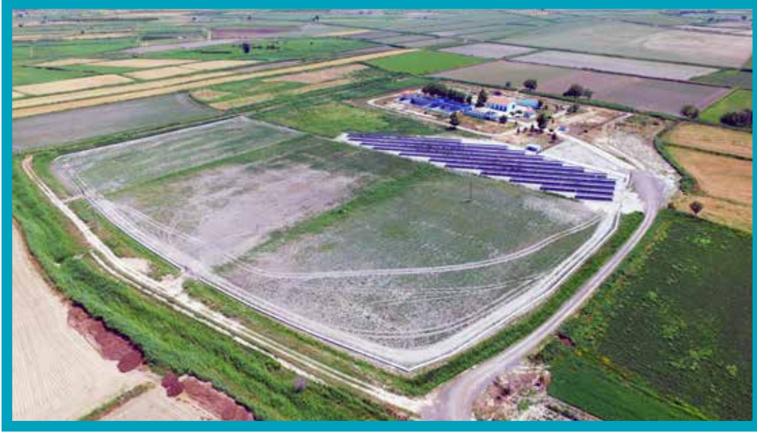
Pamukkale/Akköy Atıksu Arıtma Tesisi ve Güneş Enerji Santrali
