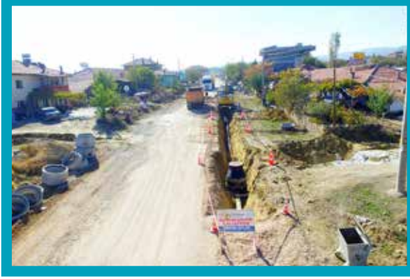
Çivril Özdemirci Kanalizasyon Hattı Yapımı
