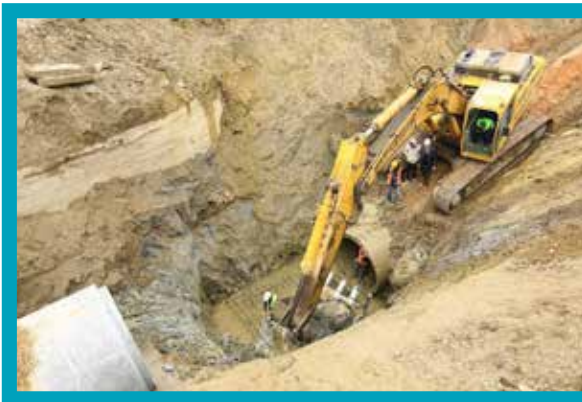
Üçgen Kavşağı Yağmursuyu ve Kanalizasyon Hattı Yapımı
