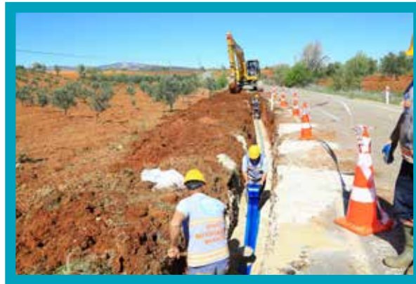
Kale İlçesi Doğanköy Mahallesi İçmesuyu Hattı İmalatı
