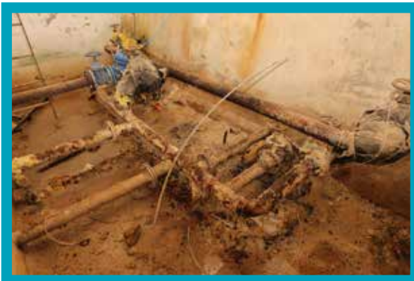
Bozkurt İncelertekkesi Mekanik Aksam Eski Hali
