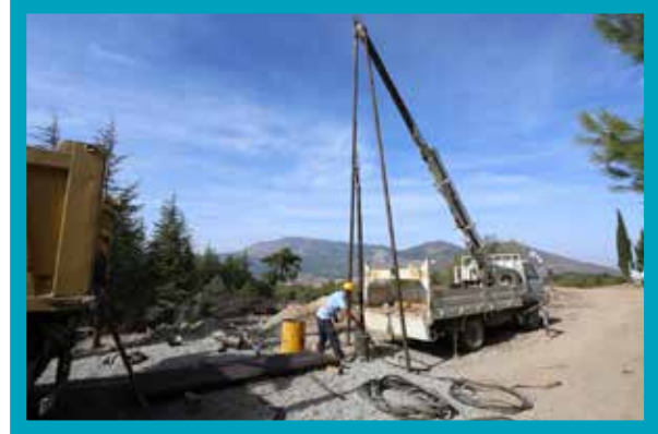
Pompa Arıza Ekibinin Sondaj Çalışması
