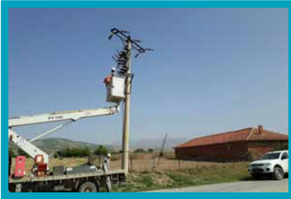
Enerji Bakım Onarım İşlemi Çalışması
