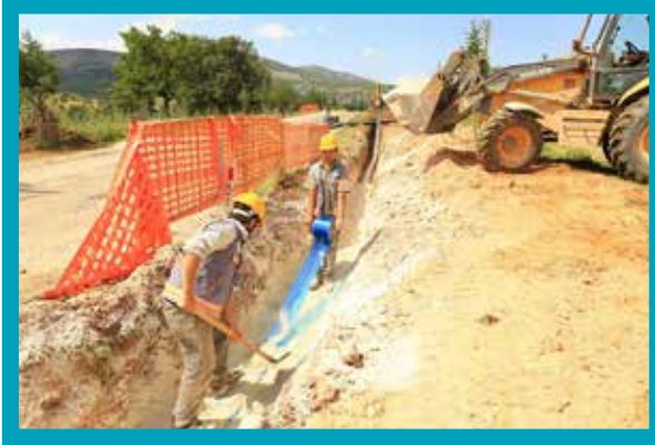
Çivril Cumalar İçmesuyu Hattı Yapımı
