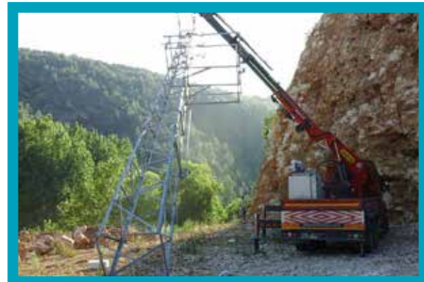
Orta Gerilim Trafo Direği Dikme Çalışması
