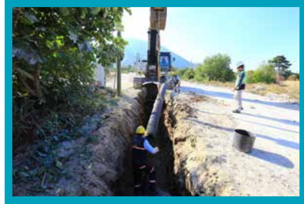
Merkezefendi İlçesi Başkarcı Mahallesi Ø300 mm Kanalizasyon Hattı Yapımı
