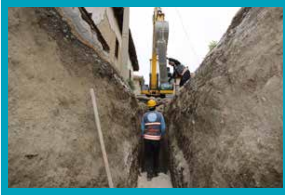
Yatağan İçmesuyu ve Kanalizasyon Hattı Yapımı
