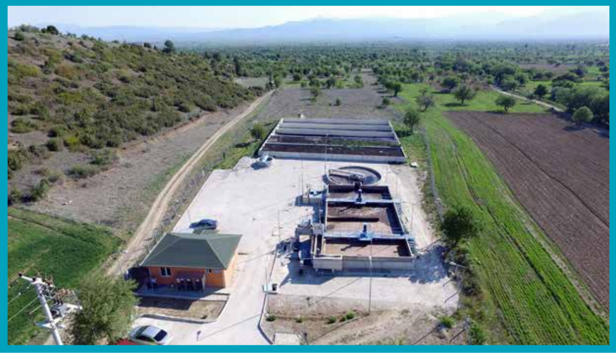
Acipayam Yeşilyuva Atıksu Arıtma Tesisi
