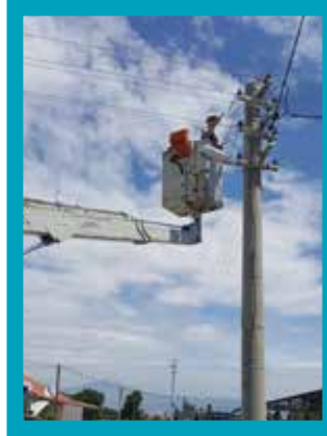
Direkten Enerji Kesme İşlemi
