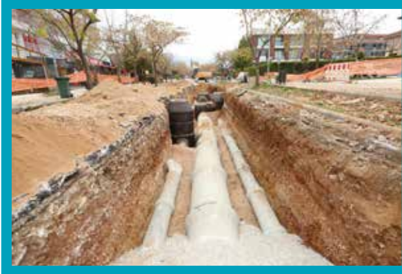
Çamlık Bulvarı Kanalizasyon Hattı Yapımı
