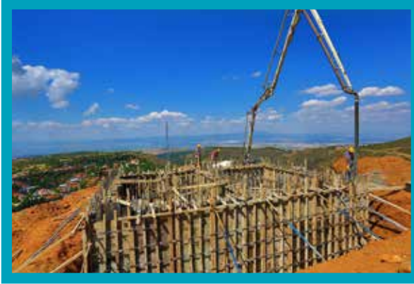
Babadağ Mollaahmet İçmesuyu Deposu Yapımı
