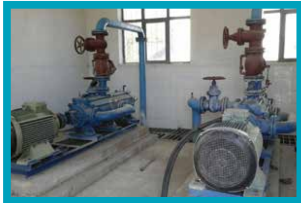
Pompa Bakım Onarım Çalışması
