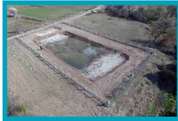
Tavas – Pınarlık Doğal Atıksu Arıtma Tesisi Yenileme Sonrası Hali
