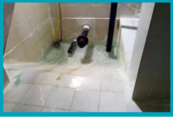
Acıpayam İlçesi Dedebağ Mahallesi İçmesuyu Deposu (Temizlikten sonra)
