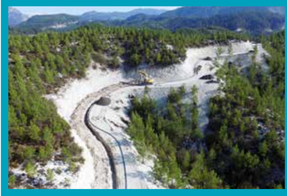
Acipayam Suçatı İçmesuyu Hattı Yapımı
