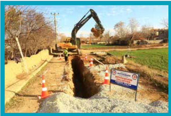
Çivril Irgılı Kanalizasyon Hattı Yapımı
