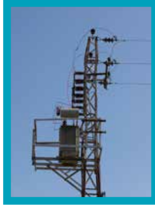
Ayırıcı Kolu İndirilerek Direkten Enerjinin Kesilmesi-Öncesi
