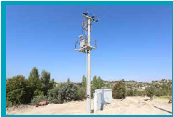
Yeni Açılan Sondaj Kuyusu için Enerji Nakil Hattı Çekilmesi
