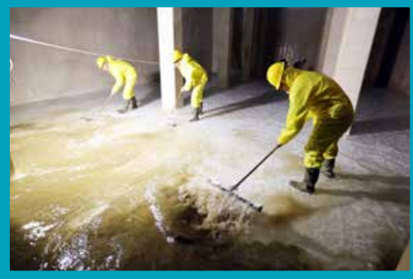
Merkezefendi İlçesi Çakmak İçmesuyu Deposu Temizleme Çalışmaları
