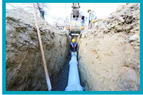
Bozkurt Muhtelif Mahallelerinde Kanalizasyon Hattı Yapımı
