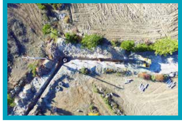
Çameli Yaylapınar Kanalizasyon Hattı Yapımı
