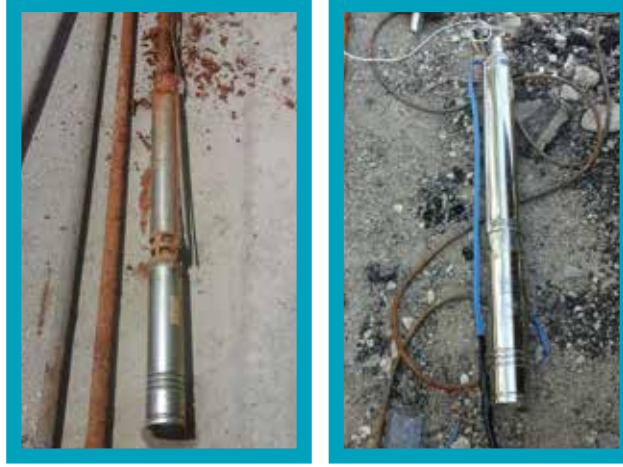
Dalgıç Pompa Değişim İşlemi-Eski Pompa Dalgıç Pompa Değişim İşlemi-Yeni Pompa
