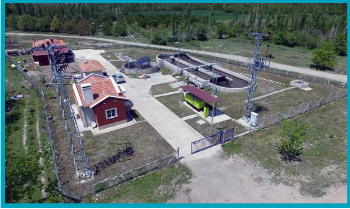
Çivril Gümüşsu Atıksu Arıtma Tesisi
