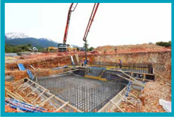
Tavas Balkıca İçmesuyu Deposu Yapımı
