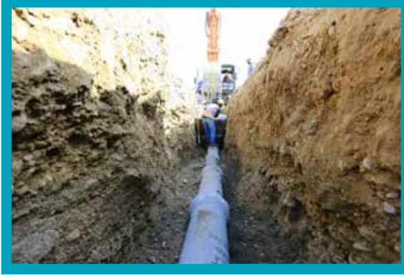
Bozkurt Muhtelif Mahallelerinde Kanalizasyon Hattı Yapımı
