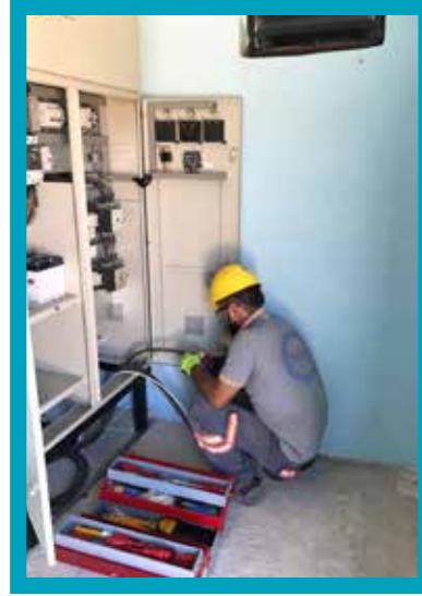
Elektrik Pano Arızasının Giderilme Çalışması
