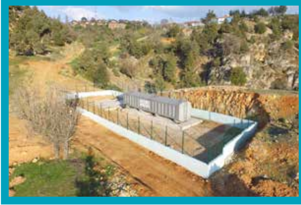
Acıpayam - Eskiköy Paket Atıksu Arıtma Tesisi
