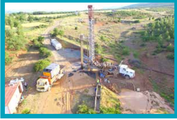
Acıpayam İlçesi Akalan Sondaj Çalışması
