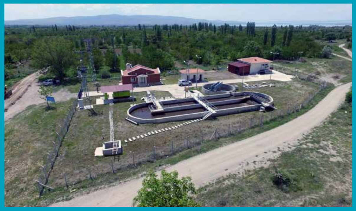
Çivril Gümüşsu Atıksu Arıtma Tesisi
