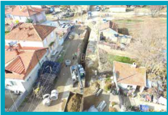
Çivril Haydan Kanalizasyon Hattı Yapımı
