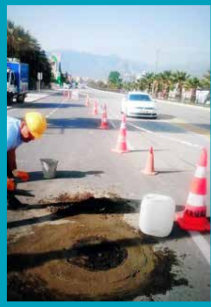
Pamukkale İlçesi Dokuzkavaklar Mahallesi Rögar Kapağı Tamirâtı
