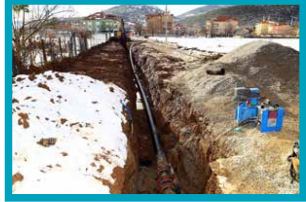
Beyağaç İlçesi Eşenler Mahallesi İçmesuyu Hattı İmalatı
