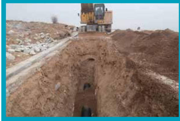
Pamukkale İlçesi Karahayıt Mahallesi TOKİ Binaları Karşısı Ø300 mm Kanalizasyon Hattı İmalatı
