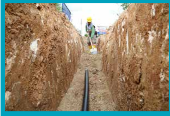
Bekilli Üçkuyu İçmesuyu Hattı Yapımı
