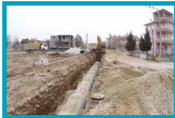
Çivril İlçesi Yağmursuyu Hattı Yapımı
