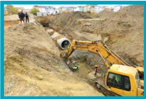
Üçgen Kavşağı Yağmursuyu ve Kanalizasyon Hattı Yapımı
