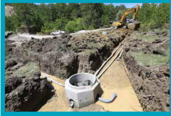
Acıpayam İlçesi Dedebağı Mahallesi İçmesuyu Hattı İmalatı
