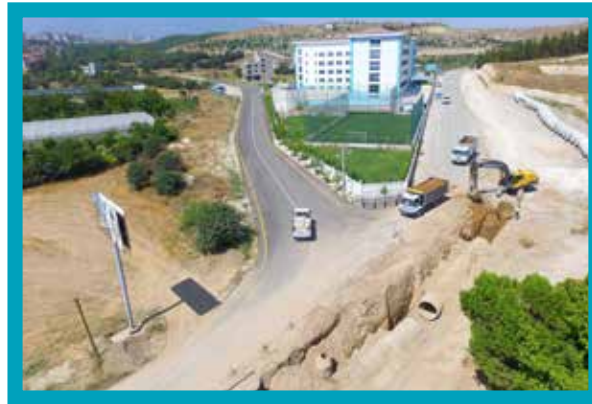
Merkezeferendi Karahasanlı Yağmursuyu Hattı Yapımı
