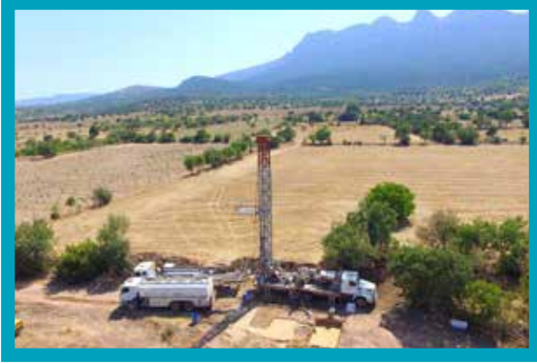
Baklan İlçesi Merkez- 2 Sondaj Çalışması
