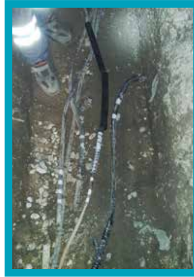
Kazı Esnasında Kopan Kablo Tamiri-Öncesi Kazı Esnasında Kopan Kablo Tamiri-Sonrası
