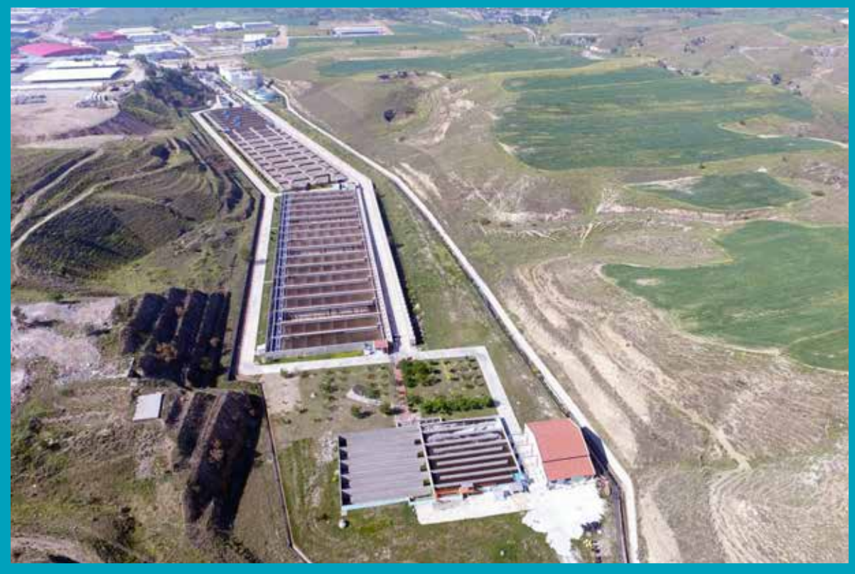
Merkez Atıksu Arıtma Tesisi
