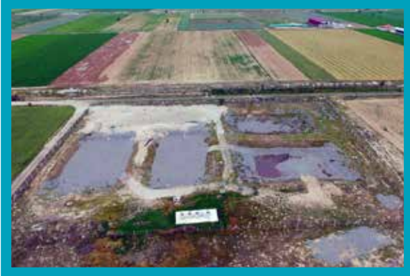
Acipayam – Yumrutaş Doğal Atıksu Arıtma Tesisi Yenileme Sonrası Hali
