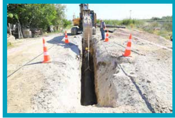
Honaz İlçesi Kocabaş Mahallesi Ø300 mm Kanalizasyon Hattı İmalatı
