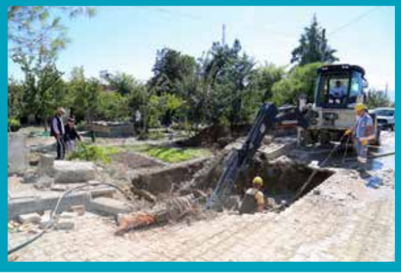
Çardak İlçesi İçmesuyu Ana Şebeke Arızası Tamirâtı
