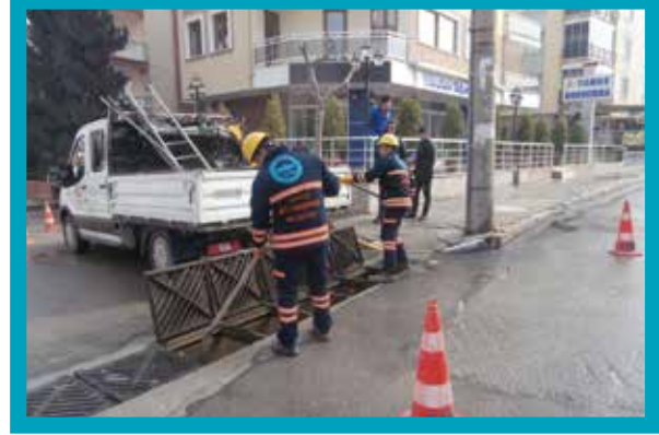
Pamukkale İlçesi Fatih Mahallesi Izgara Temizliği
