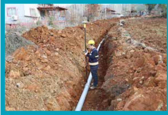
Beyağaç İlçesi Eşenler Mahallesi İçmesuyu Hattı İmalatı
