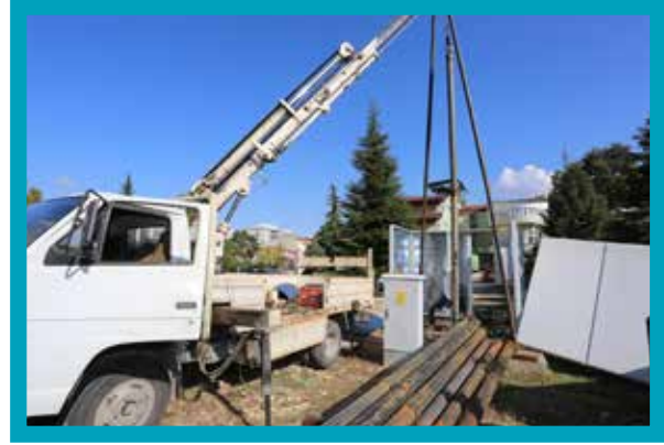
Pompa Değişirme İşlemi
