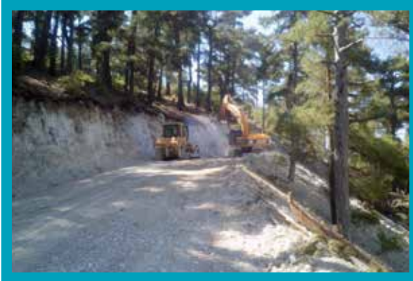
Dozer ile Ekskavatör İş Makinelerinin Yol Çalışması İşlemi
