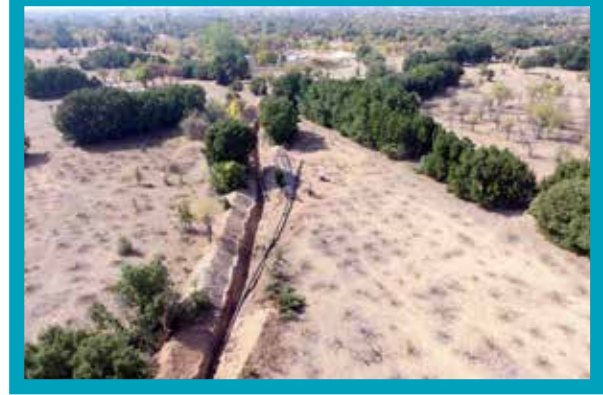
Karahisar İçmesuyu Hattı Yapımı
