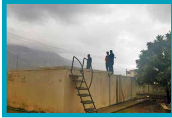
Antalya ASAT Gazipaşa Atıksu Arıtma Tesisi
