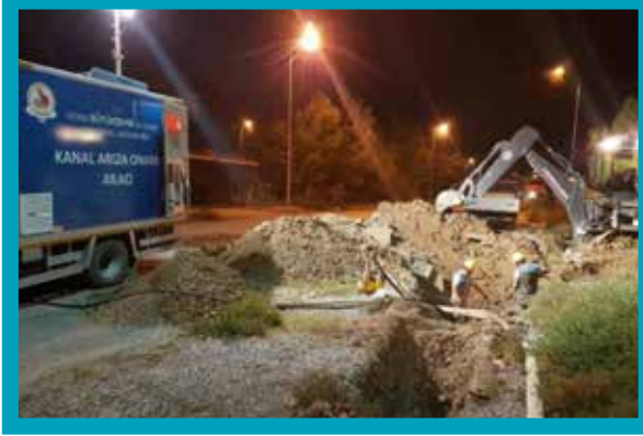
Çardak İlçesi Cumhuriyet Mahallesi Ana Boru Arızası Tamirâtı
