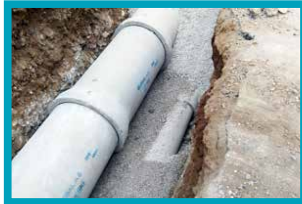
Merkezefendi Bahçelievler Kanalizasyon Hattı Yapımı
