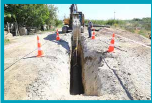
Çardak İlçesi Merkez Mahallelerinde Kanalizasyon Hattı Yapımı
