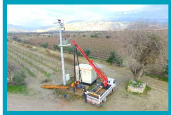
Pompa İndirme Çalışması
