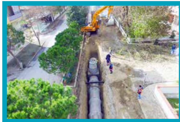
Çardak Merkez Yağmursuyu Hattı Yapımı
