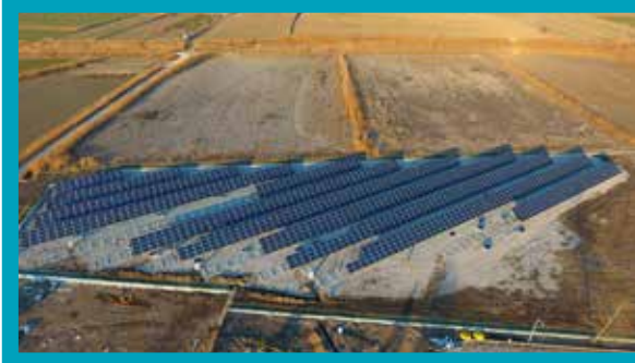
Güneş Enerji Santrali – 1 Projesi Montaj İşlemi
