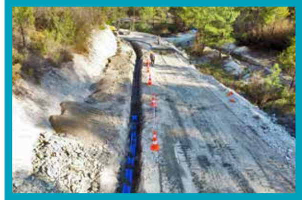
Acıpayam Suçatı İçmesuyu Hattı Yapımı
