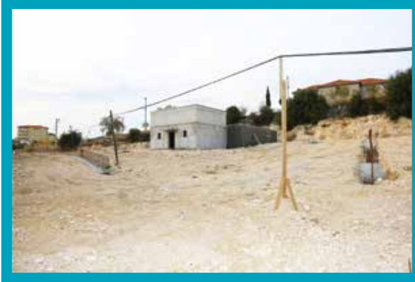
Güney İçmesuyu Deposu (400 m 3 ) Yapımı
