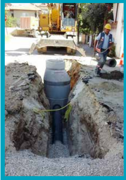
Merkezefendi İlçesi Merkezefendi Mahallesi Ø300 mm Kanalizasyon Hattı İmalatı
