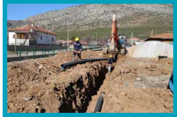
Tavas İlçesi Pınarlar Mahallesi Kanalizasyon Hattı İmalatı
