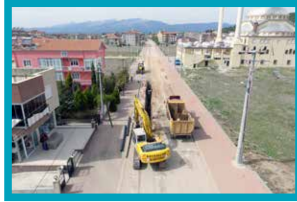
Tavas Merkez Kanalizasyon Hattı Yapımı
