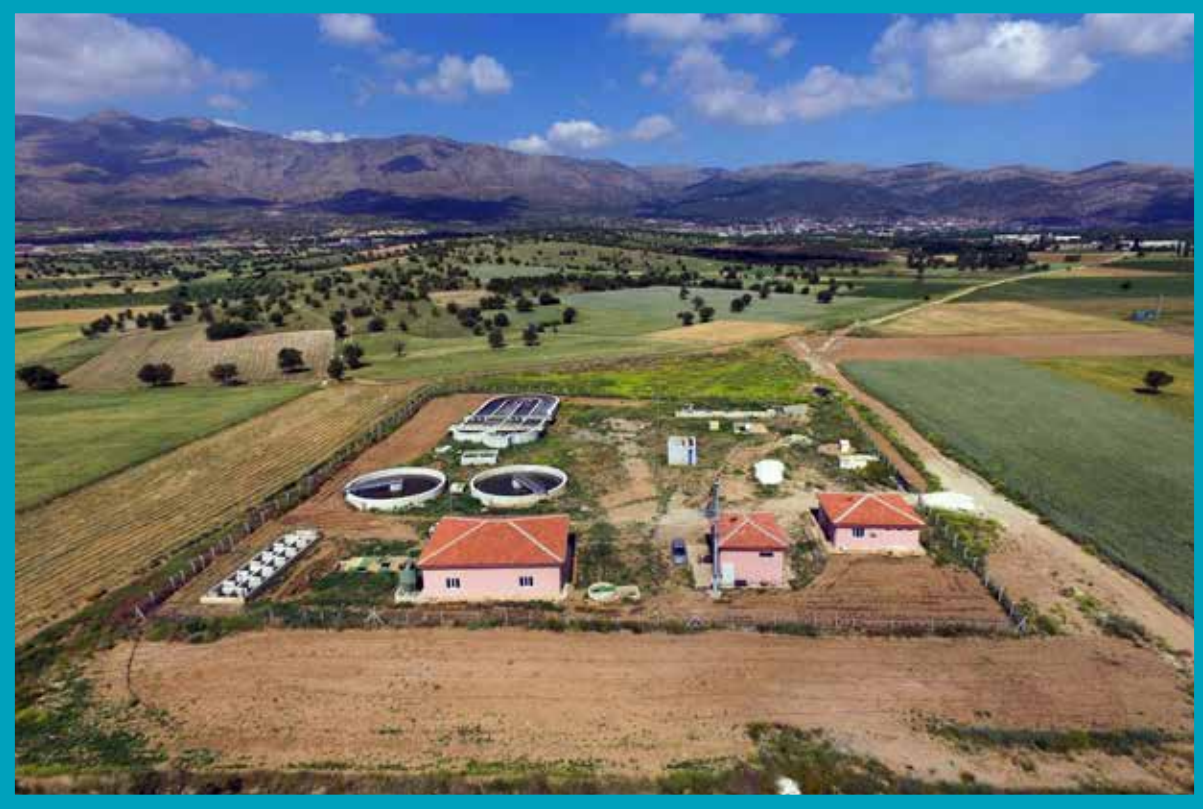
Serinhisar Atıksu Arıtma Tesisi
