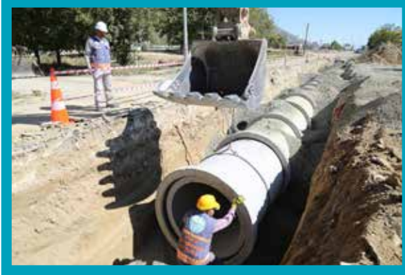
Çardak İlçesi Merkez Mahallelerinde Yağmursuyu Hattı Yapımı
