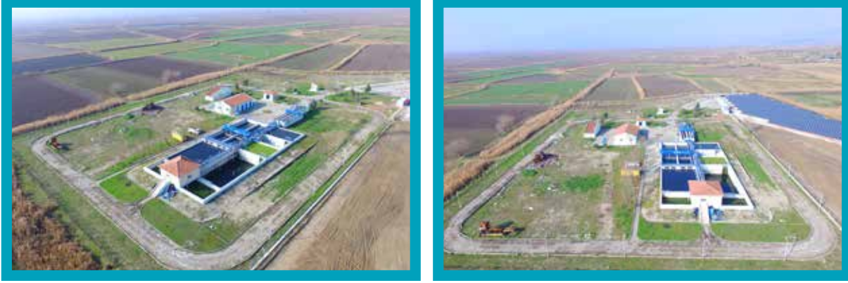
Akköy Atıksu Arıtma Tesisi Genel Görünüm
