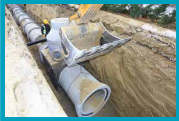
Çardak İlçesi Merkez Mahallelerinde Yağmursuyu Hattı Yapımı
