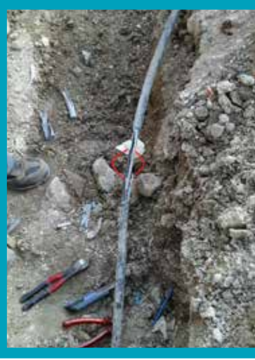
Kazı Esnasında Kopan Kablo Tamiri-Öncesi
