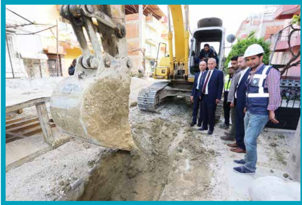
Sarayköy Kanalizasyon Hattı Yapımı
