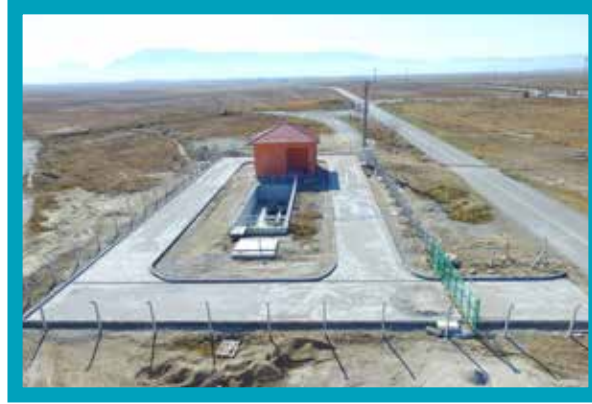
Çardak Atıksu Arıtma Tesisi Yapımı
