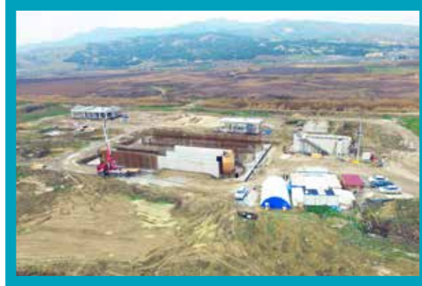
Sarayköy Atıksu Arıtma Tesisi Yapımı
