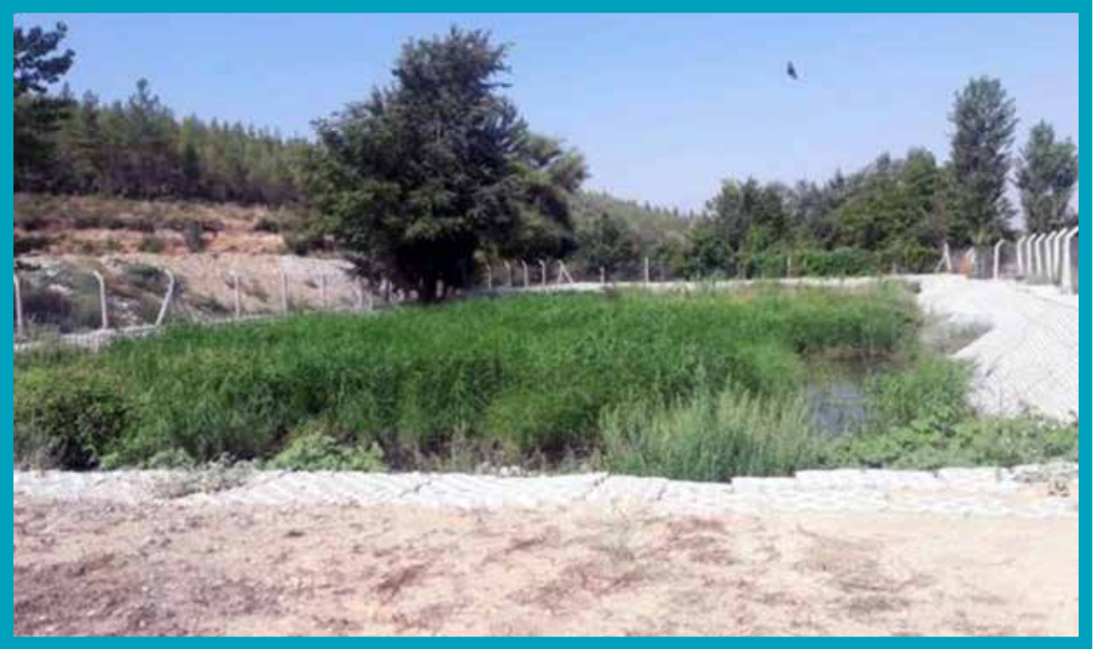
Bozkurt Alikurt Doğal Atıksu Arıtma Tesisi
