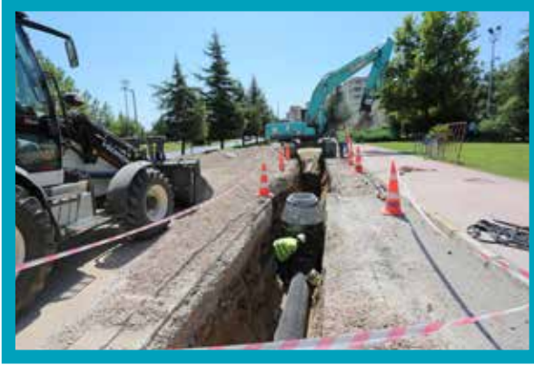
Merkezefendi İlçesi Servergazi Mahallesi Ø400 mm Kanalizasyon İmalatı
