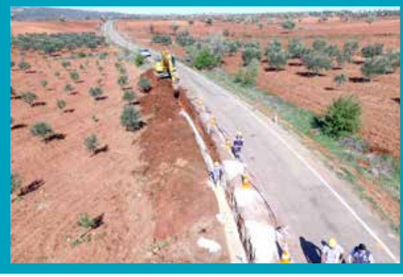
Kale İlçesi Doğanköy Mahallesi İçmesuyu Hattı İmalatı
