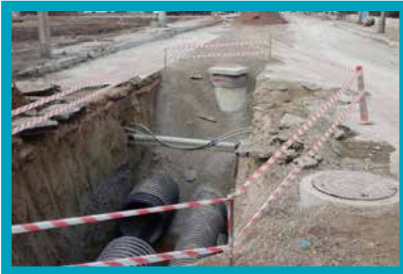
Pamukkale İlçesi Dokuzkavaklar Mahallesi Ø300 mm Kanalizasyon Hattı ve Ø600 mm Yağmursuyu Hattı İmalatı
