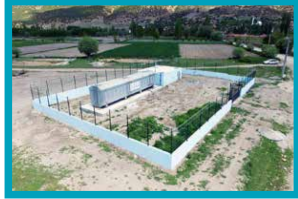
Çivril - Beydilli Paket Atıksu Arıtma Tesisi
