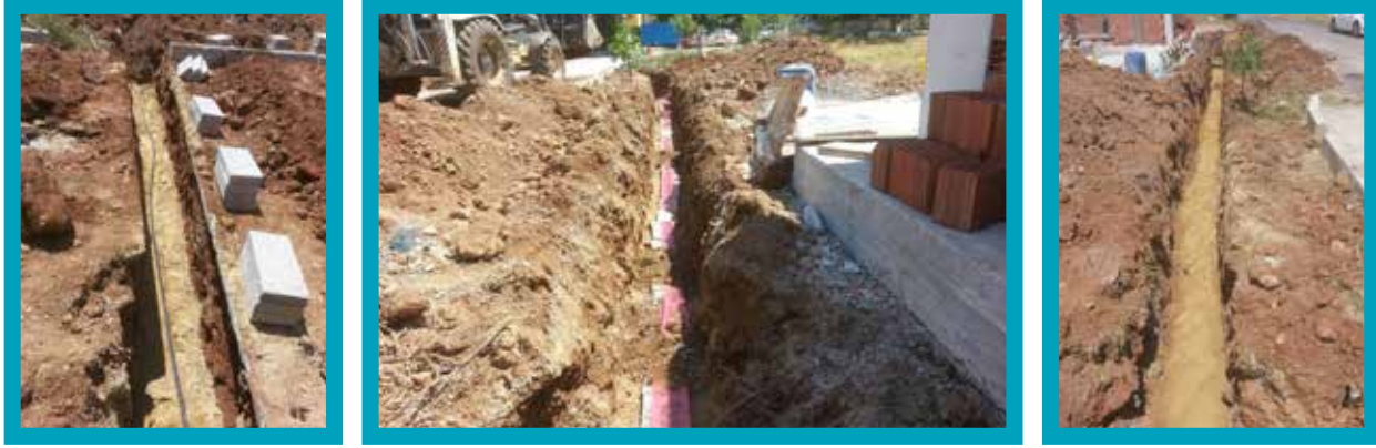
Elektrik Besleme Hattı Çekilmesi Çalışması
