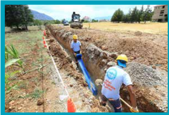
Acıpayam İlçesi Yazır Mahallesi İçmesuyu Hattı İmalatı
