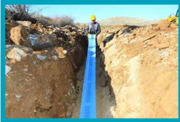
Bekilli Poyrazlı İçmesuyu Hattı Yapımı
