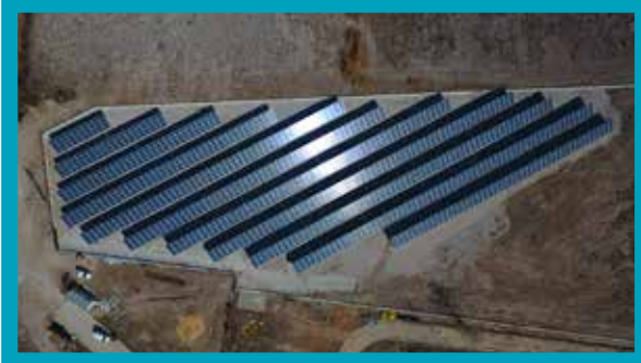
Güneş Enerji Santrali – 1 Projesi Uygulama İşlemi
