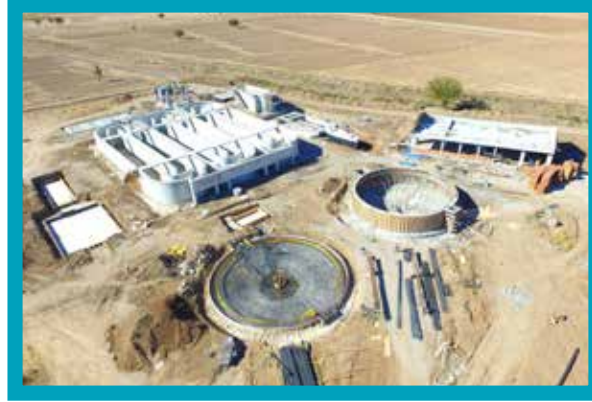
Tavas Atıksu Arıtma Tesisi Yapımı
