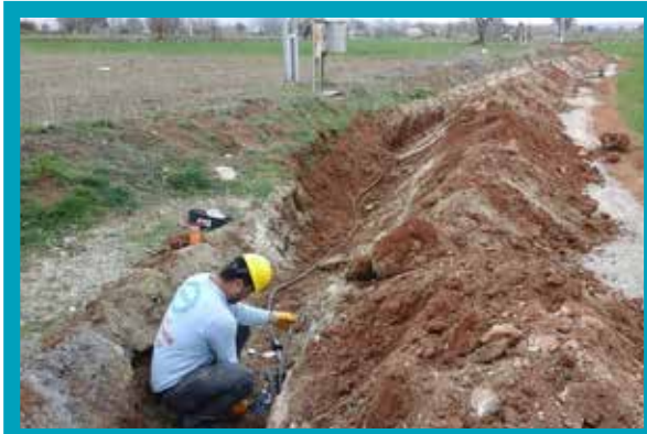
Kazı Esnasında Kopan Kablo Tamiri İşlemi
