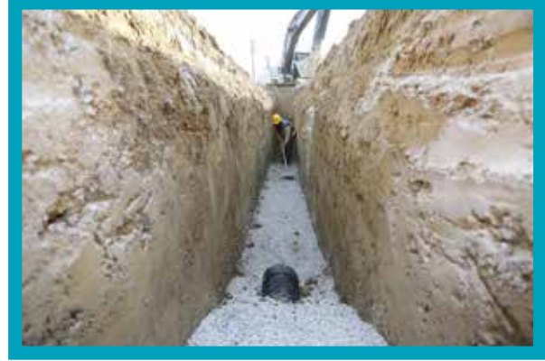
Çardak Gemiş Kanalizasyon Hattı Yapımı
