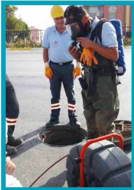
Pamukkale İlçesi İncilipınar Mahallesi Rögar Temizliği
