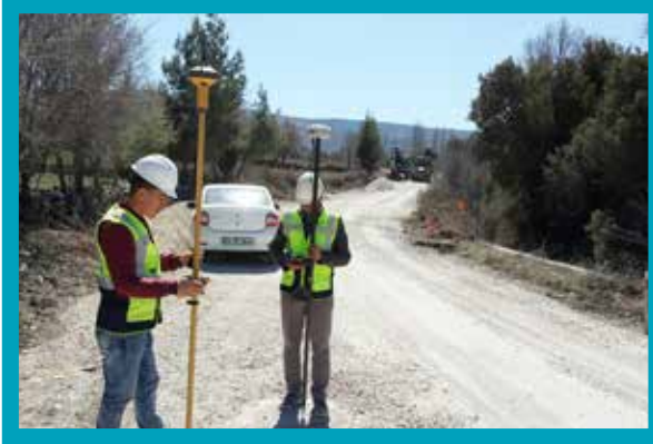
3. Bölge Kelekçi Muhtelif Kanalizasyon, İçmesuyu Kontrol Ölçümü
