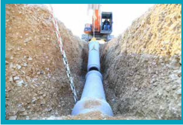
Çardak Kanalizasyon Hattı Yapımı
