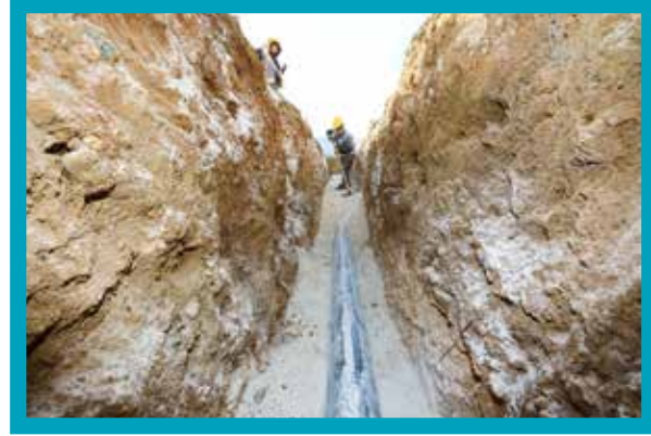
Bozkurt İçmesuyu Hattı Yapımı
