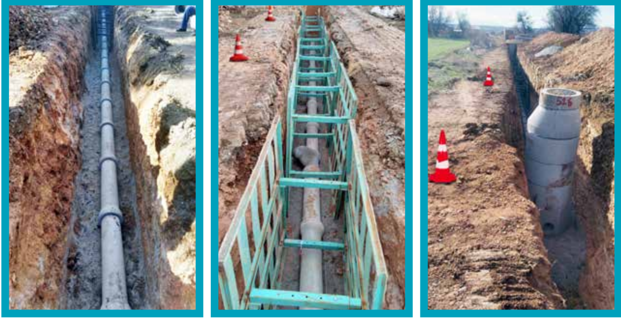
Baklan Kanalizasyon Hattı Yapımı
