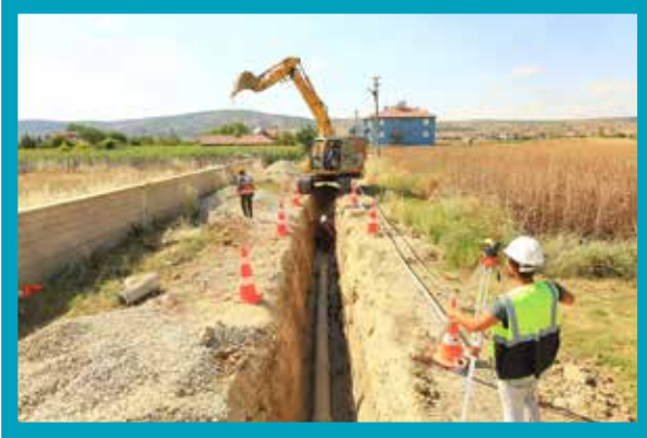
Çivril Akpınar Kanalizasyon Hattı Yapımı
