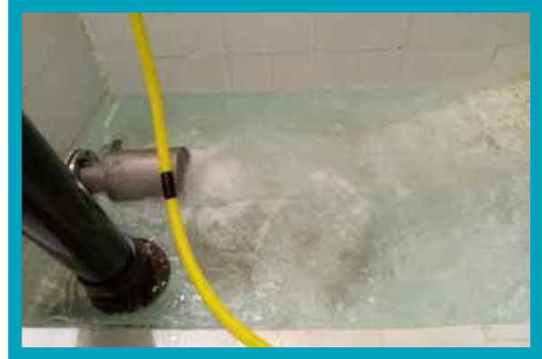
Acıpayam İlçesi Aliveren Mahallesi İçmesuyu Deposu (Temizlikten sonra)
