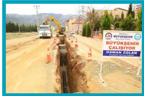
Tavas Merkez Kanalizasyon Hattı Yapımı
