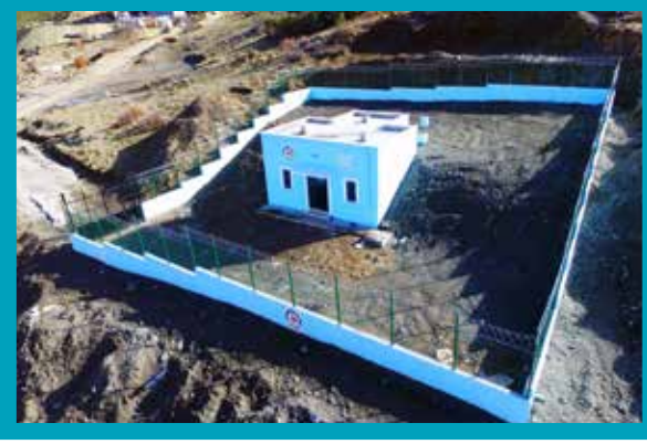
Tavas Bahçeköy İçmesuyu Deposu Yapımı
