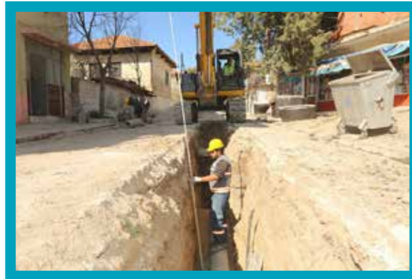
Yatağan İçmesuyu ve Kanalizasyon Hattı Yapımı
