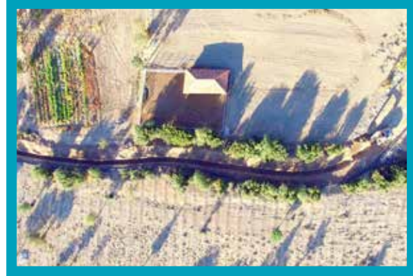
Acipayam Yazır İçmesuyu Hattı Yapımı
