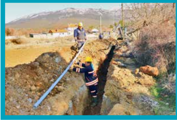
Tavas İlçesi Bahçeköy Mahallesi İçmesuyu Hattı İmalatı
