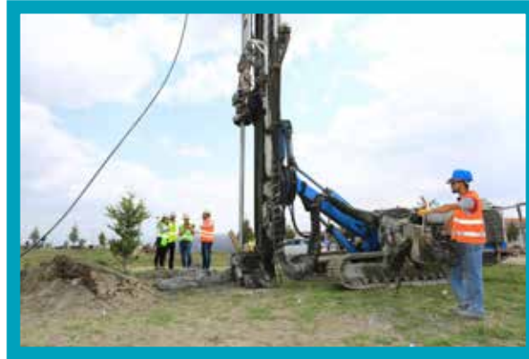
Acıpayam Atıksu Arıtma Tesisi Jet Grout Çalışması
