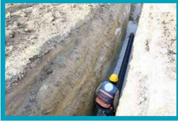
Çardak Gemiş İçmesuyu Hattı Yapımı
