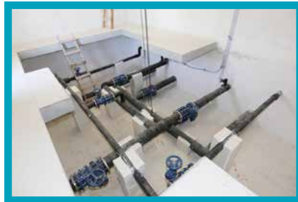
Tavas Balkıca İçmesuyu Deposu Yapımı
