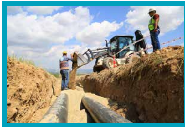
Çal Söller Mahallesi İçmesuyu İsale Hattı Yapımı
