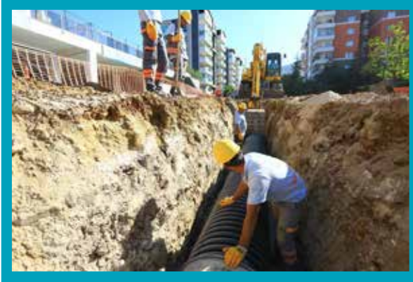
Merkezefendi İlçesi Servergazi Mahallesi Ø600 mm Yağmursuyu Hattı İmalatı
