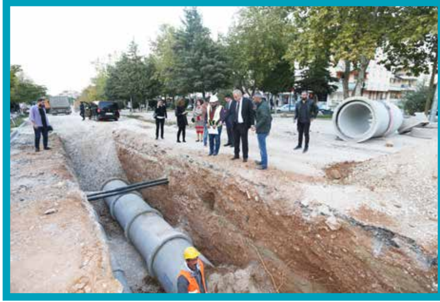
Çamlık Bulvarı Kanalizasyon Hattı Yapımı
