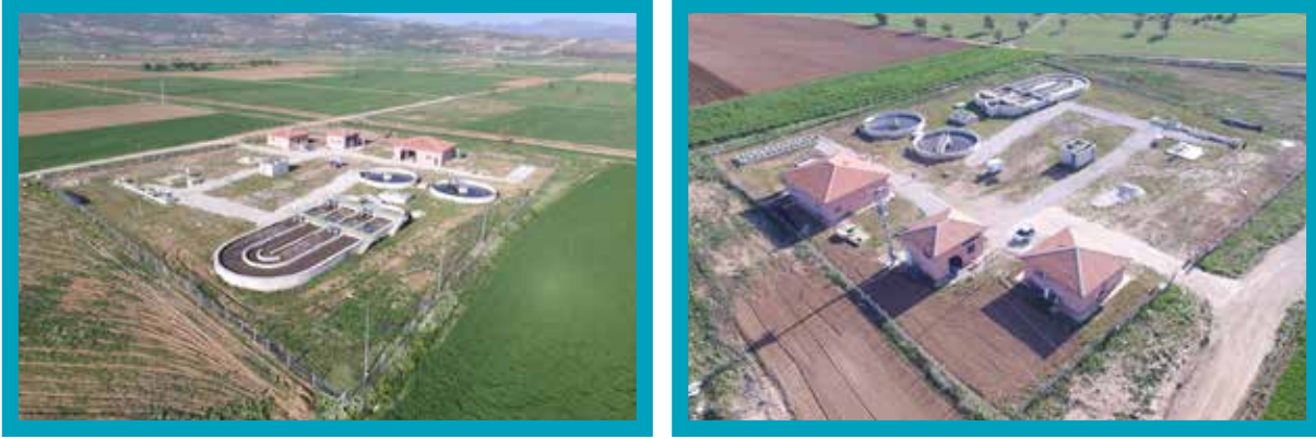
Serinhisar Atıksu Arıtma Tesisi Genel Görünüm
