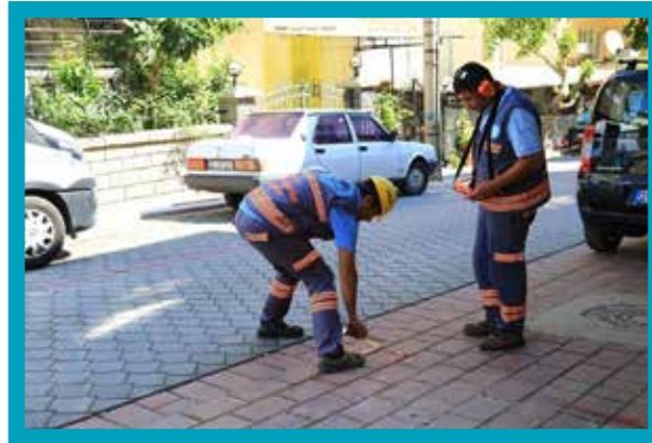
Pamukkale İlçesi İncilipınar Mahallesi Abone Şube Yolu Tamirâtı
