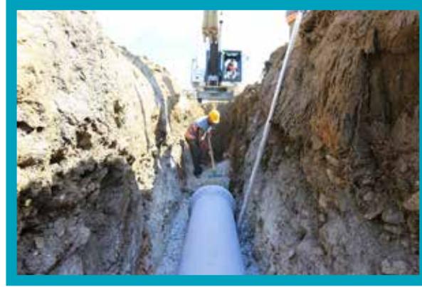
Tavas Baharlar Mahallesi Kanalizasyon Hattı Yapımı
