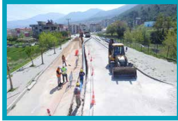
Pamukkale İlçesi Zeytinköy Mahallesi İletim Hattı İmalatı
