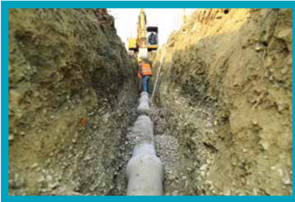
Honaz Kanalizasyon Hattı Yapımı
