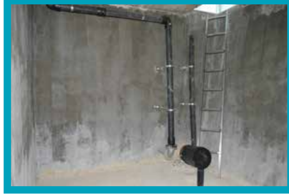
Tavas İlçesi İçmesuyu Deposu İzolasyon Çalışmaları
