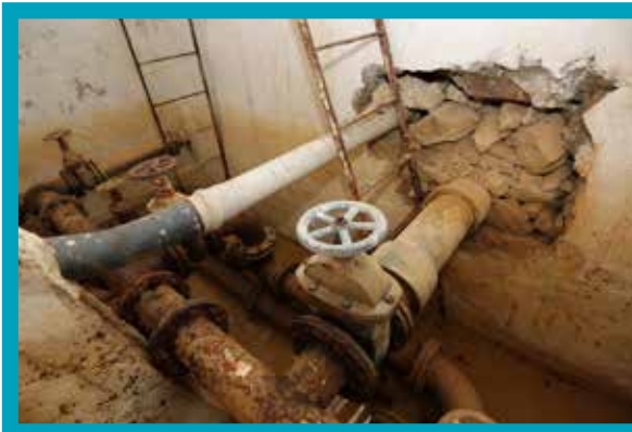
Beyağaç Yeniköy Depo Eski Hali
