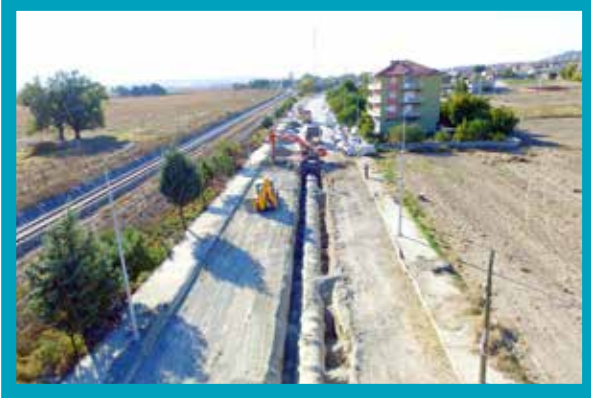
Çardak İlçesi Merkez Mahallelerinde Yağmursuyu Hattı Yapımı
