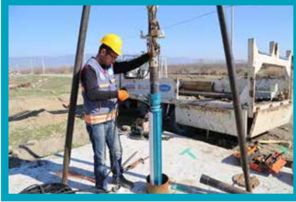
Pompa İndirme Çalışması
