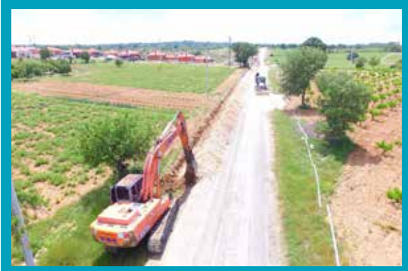
Çal İlçesi Dağmarmara Mahallesi İçmesuyu Hattı İmalatı
