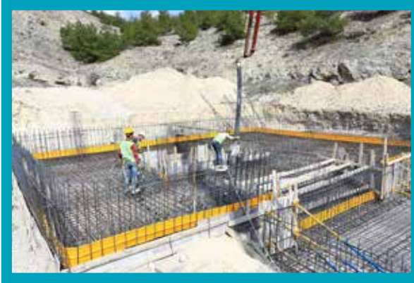
Pamukkale Mahallesi İçmesuyu Deposu Yapımı
