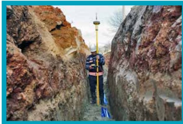
Tavas - Kızılca Mahallesi İçmesuyu Hattı Yapımı
