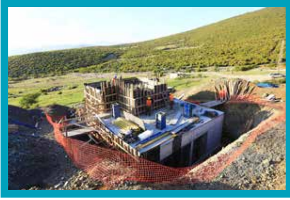
Tavas Bahçeköy İçmesuyu Deposu Yapımı
