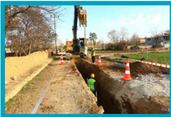
Çivril Irgılı Kanalizasyon Hattı Yapımı
