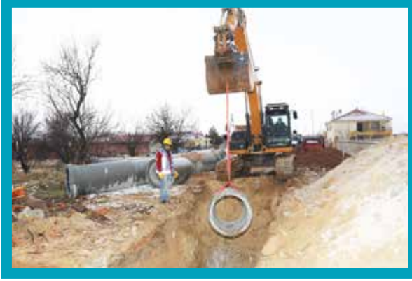
Çivril Çıtak Kanalizasyon Hattı Yapımı
