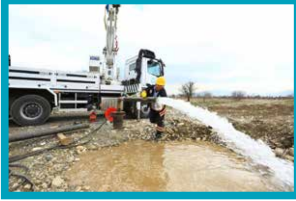
Acipayam İlçesi Yazır Mahallesi Sondaj Kuyusu Numune Alımı
