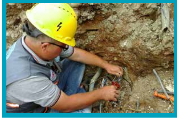
Kazı Esnasında Kopan Kablo Tamiri Çalışması
