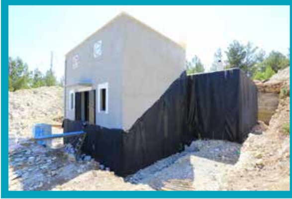
Acipayam İçmesuyu (600 m 3 ) Deposu Yapımı
