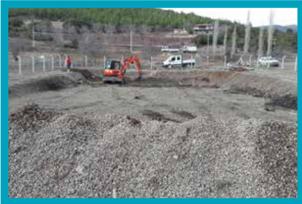
Tavas – Pınarlık Doğal Atıksu Arıtma Tesisi Yenileme Çalışmaları
