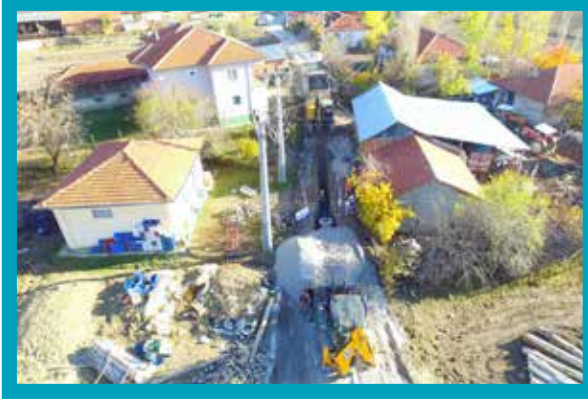
Çameli Kalinkoz Kanalizasyon Hattı Yapımı
