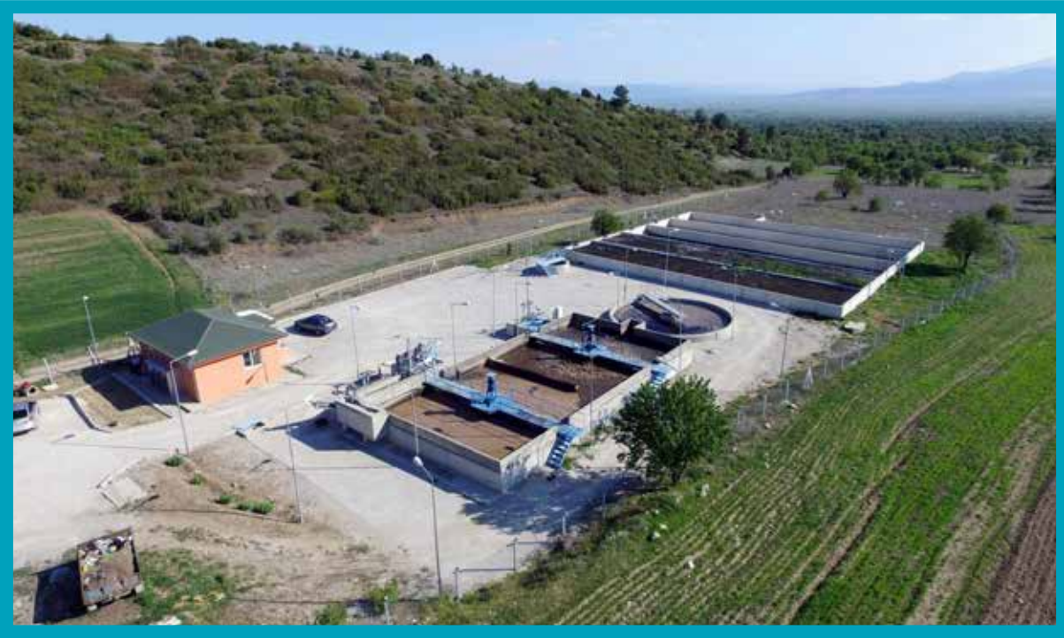
Acıpayam Yeşilyuva Atıksu Arıtma Tesisi
