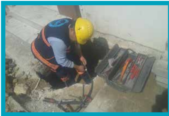
Kazı Esnasında Kopan Kablo Tamiri
