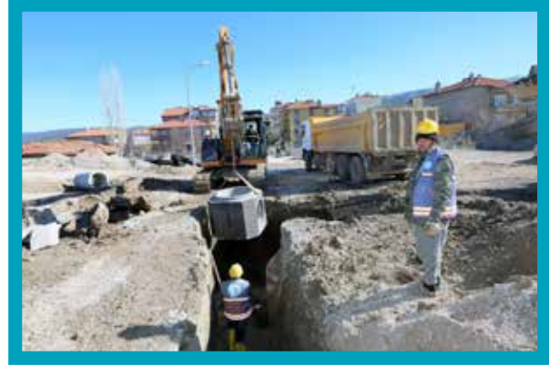
Kale İlçesi Yağmursuyu Hattı İmalatı
