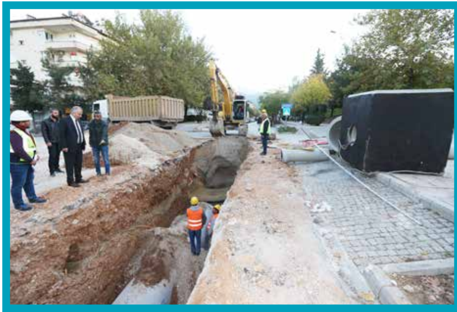
Pamukkale İlçesi Çamlık Bulvarı Kanalizasyon Hattı Yapımı
