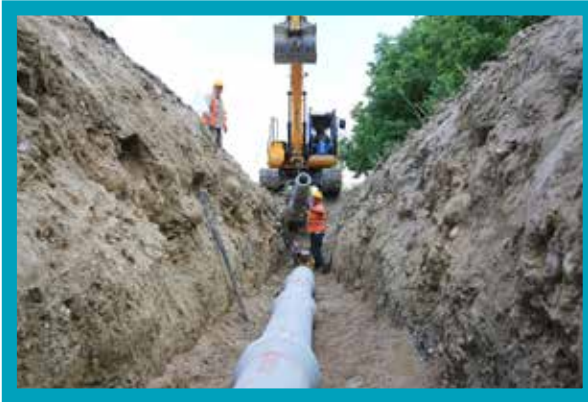
Acıpayam Kelekçi Kanalizasyon Hattı Yapımı
