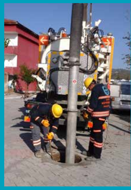
Pamukkale İlçesi Karahayit Mahallesi Kombine Temizliğı
