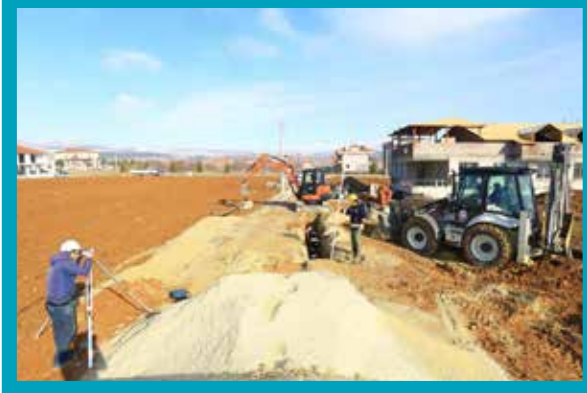
Çivril İlçesi Şehitler Mahallesi Koruge Atıksu Hat İmalatı
