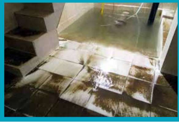
Acıpayam İlçesi Dedebağ Mahallesi İçmesuyu Deposu (Temizlikten önce)
