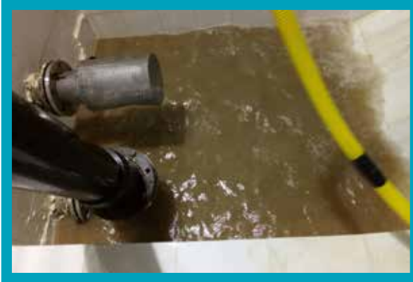
Acıpayam İlçesi Aliveren Mahallesi İçmesuyu Deposu (Temizlikten önce)
