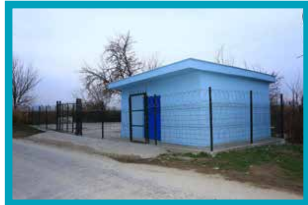
Pamukkale Küçükdere Terfi İstasyonu Yeni Hali
