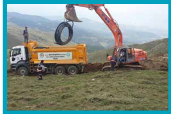
İş Makineleri ile Malzeme İndirme İşlemi
