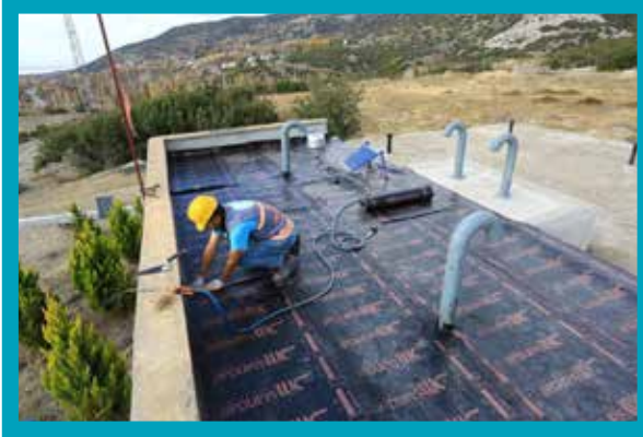
Çal Hançalar Depo Yalıtım Aşaması
