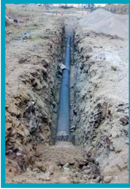
Merkezefendi İlçesi Hallaçlar Mahallesi Ø300 mm Kanalizasyon Hattı İmalatı
