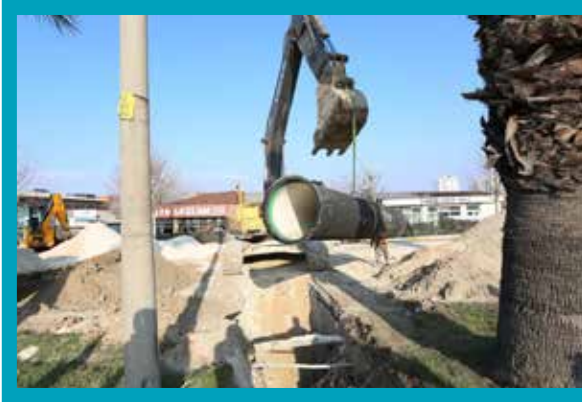
Üçgen Kavşağı İçmesuyu Hattı Yapımı
