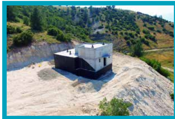
Sarayköy Tekke Mahallesi İçmesuyu Deposu Yapımı
