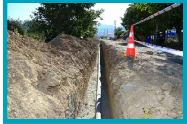
Bozkurt Muhtelif Mahallelerinde İçmesuyu Hattı Yapımı
