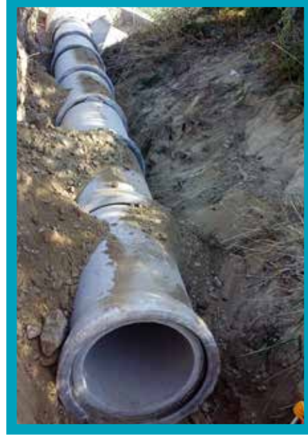
Merkezefendi İlçesi Eskihişar Mahallesi Ø600 mm Yağmursuyu Hattı İmalatı
