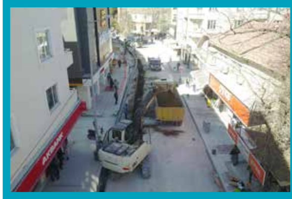
Çivril Muhtelif Mahallelerde İçmesuyu İsale Hattı Yapımı
