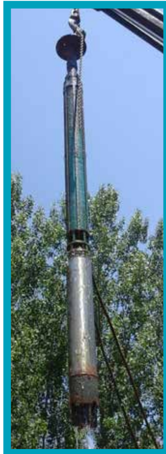
Dalgıç Pompa Değişim İşlemi-Eski Pompa Dalgıç Pompa Değişim İşlemi-Yeni Pompa
