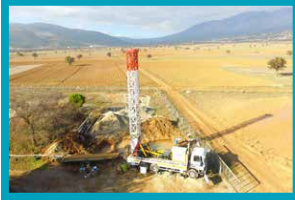
Serinhisar İlçesi Merkez Sondaj Çalışması
