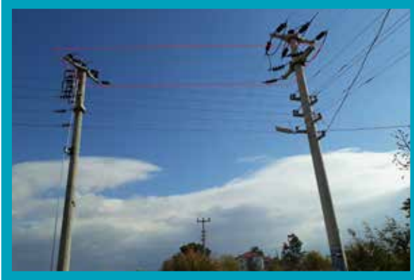
Elektrik Direği Bağlantı Çalışması
