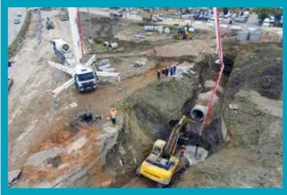
Üçgen Kavşağı Yağmursuyu ve Kanalizasyon Hattı Yapımı
