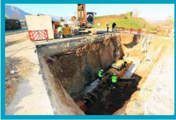
Pamukkale İlçesi Tekke Mahallesi Yatay Sondaj Çalışması
