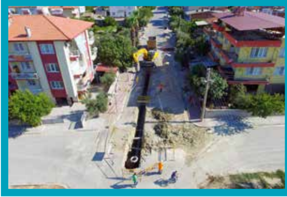
Sarayköy Kanalizasyon Hattı Yapımı
