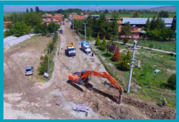
Acıpayam İlçesi Ucarı Mahallesi İçmesuyu Hattı İmalatı
