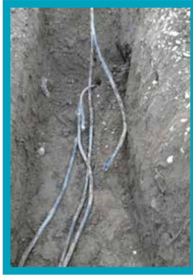
Kazı Esnasında Kopan Kablo Tamiri-Öncesi Kazı Esnasında Kopan Kablo Tamiri-Sonrası
