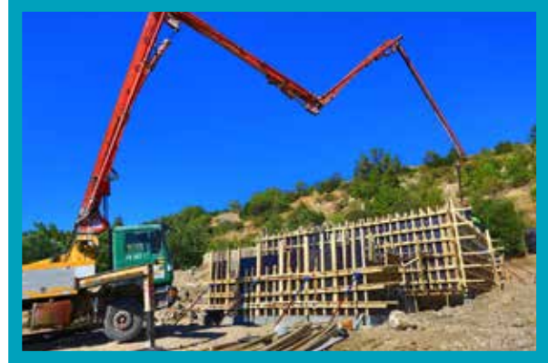
Güney İçmesuyu Deposu (300 m 3 ) Yapımı
