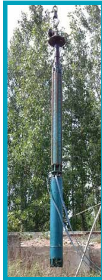
Dalgıç Pompa Değişim İşlemi-Eski Pompa Dalgıç Pompa Değişim İşlemi-Yeni Pompa
