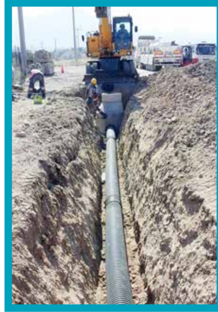
Merkezefendi İlçesi Hacıyüplü Mahallesi Ø300 mm Kanalizasyon Hattı İmalatı
