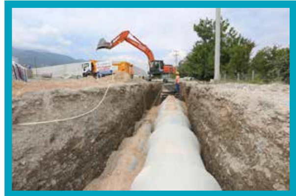
Honaz-Haydar Mahallesi Kanalizasyon Hattı Yapımı
