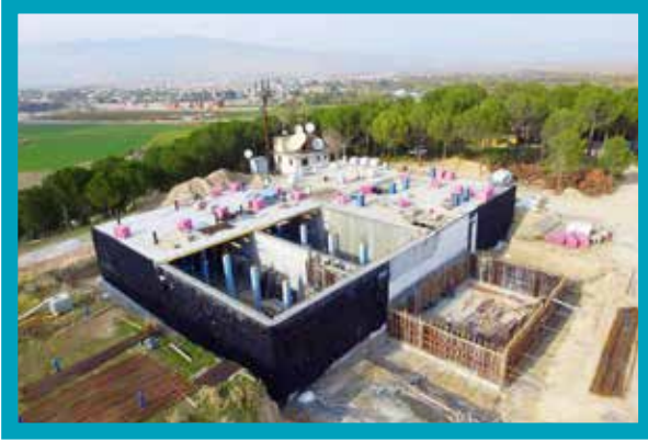
Sarayköy İçmesuyu Deposu Yapımı (4.000 m³)
