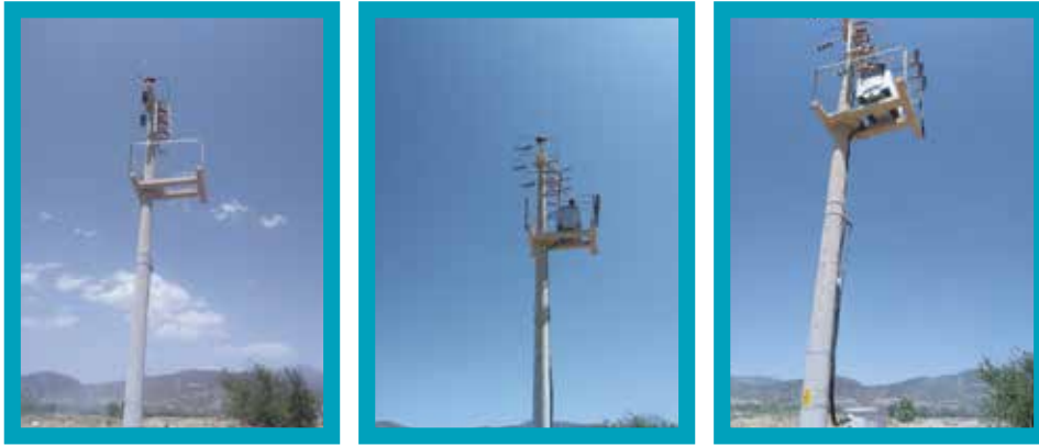
Trafo Direği Dikme – Trafo Koyma – Pano Bağlama İşlemi
