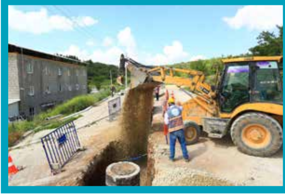
Bekilli Kanalizasyon Hattı Yapımı
