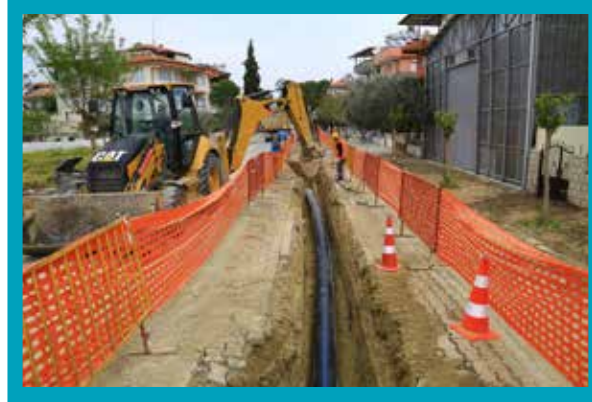
Sarayköy İçmesuyu ve Kanalizasyon Hattı Yapımı
