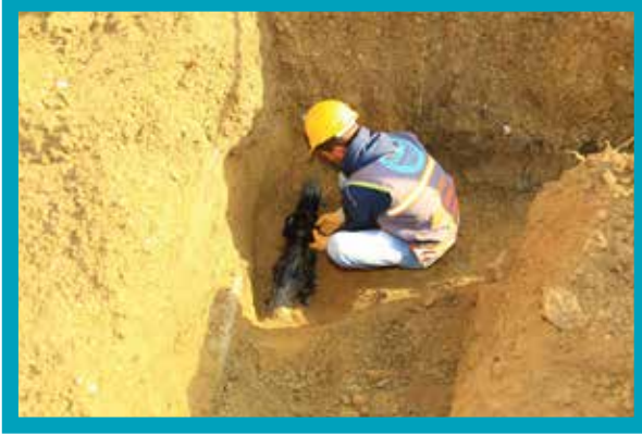
Aşağışamlı İçmesuyu Hattı Yapımı
