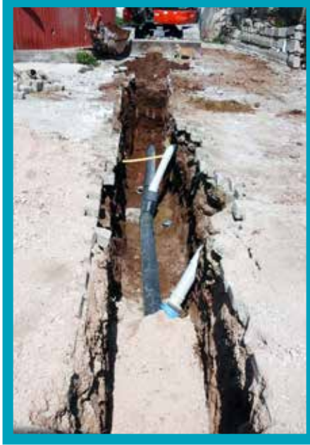
Merkezefendi İlçesi Başkarcı Mahallesi Ø300 mm Kanalizasyon Hattı İmalatı
