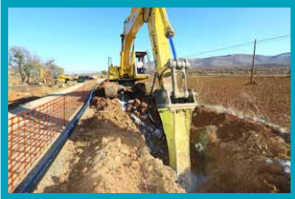
Bekilli Poyrazlı İçmesuyu Hattı Yapımı
