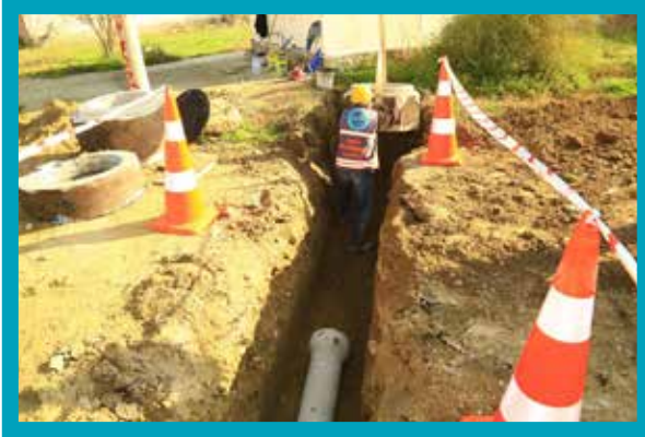
Aşağışamlı Kanalizasyon Hattı Yapımı
