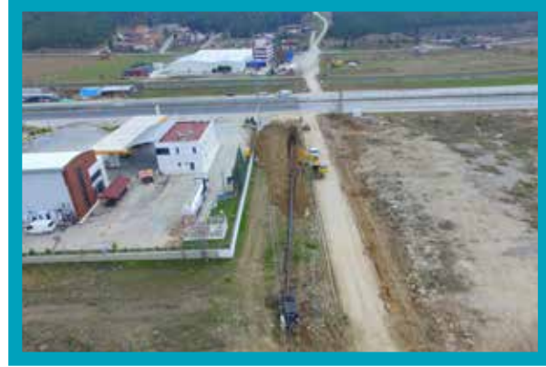
Honaz İlçesi Kaklık Mahallesi Yatay Sondaj Çalışması
