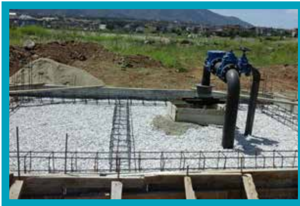
Yeni Derinkuyuların İnşaat Çalışması
