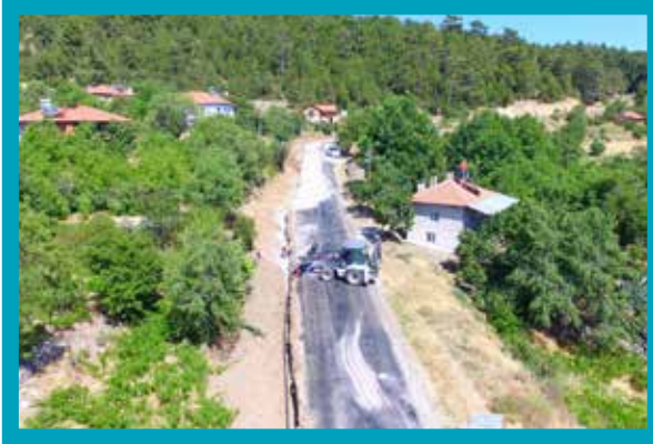
Çameli Kocaova İçmesuyu Hattı Yapımı
