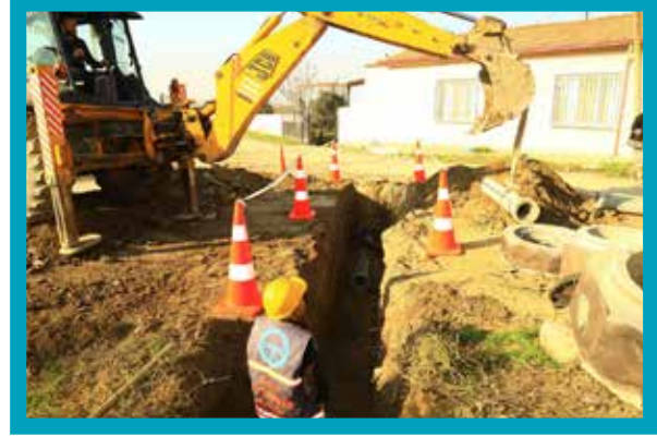
Aşağışamlı Kanalizasyon Hattı Yapımı
