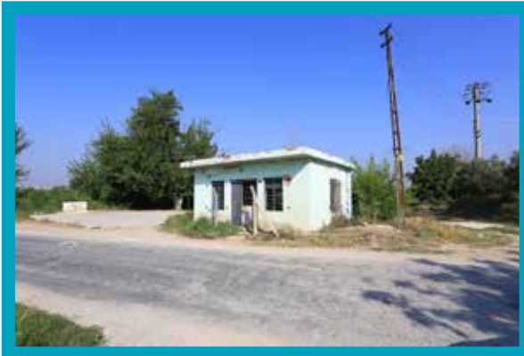
Pamukkale Küçükdere Terfi İstasyonu Eski Hali
