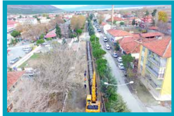
Çardak Merkez Yağmursuyu Hattı Yapımı
