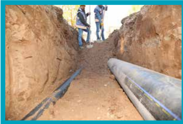
Tavas Kızılcabölük İçmesuyu Hattı Yapımı
