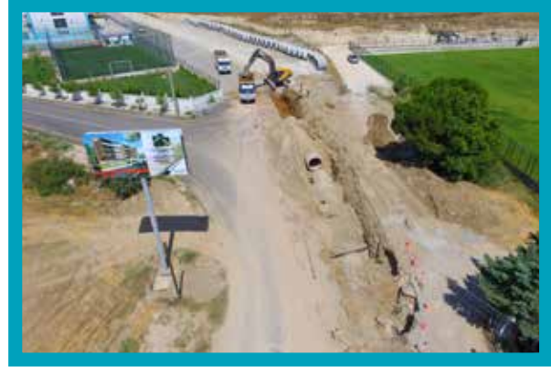
Merkezeferendi Karahasanlı Yağmursuyu Hattı Yapımı
