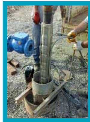
Pompa İndirme İşlemi
