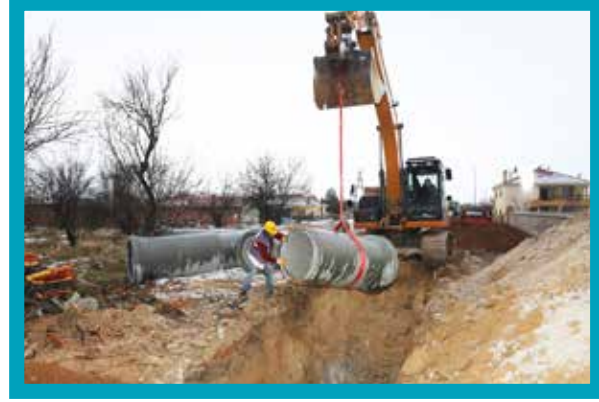
Çivril Çıtak Kanalizasyon Hattı Yapımı
