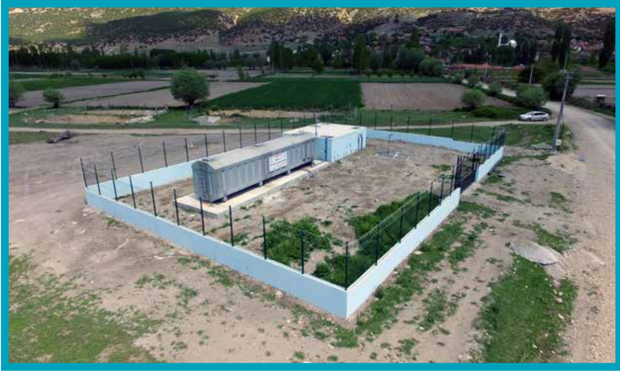
Çivril Beydilli Paket Atıksu Arıtma Tesisi
