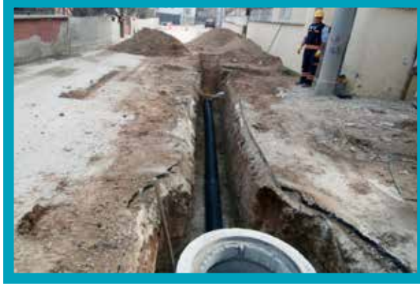
Merkezefendi İlçesi Merkezefendi Mahallesi Ø300 mm Kanalizasyon Hattı İmalatı
