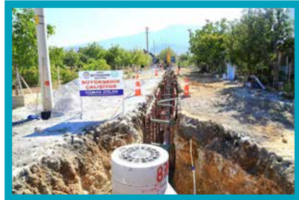
Baklan Kanalizasyon Hattı Yapımı
