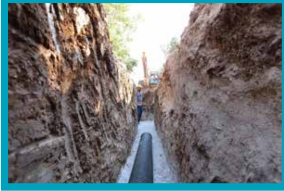
Karahisar Kanalizasyon Hattı Yapımı
