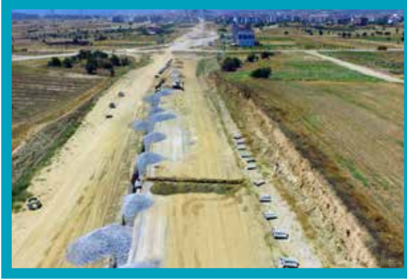
Merkezeferendi Karahasanlı Kanalizasyon Hattı Yapımı
