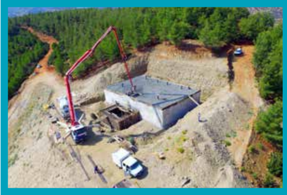
Merkezefendi Yeşilyayla Mahallesi İçmesuyu Deposu Yapımı
