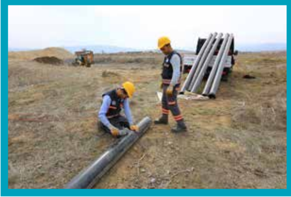
Acipayam – Yumrutaş Doğal Atıksu Arıtma Tesisi Yenileme Çalışmaları
