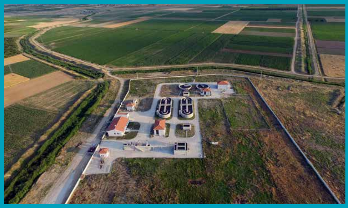
Çivril Atıksu Arıtma Tesisi
