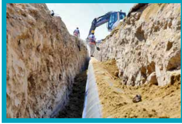
Sarayköy 500'lük İçmesuyu Hattı Yapımı
