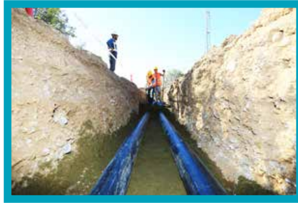
Acipayam Yazır İçmesuyu Hattı Yapımı
