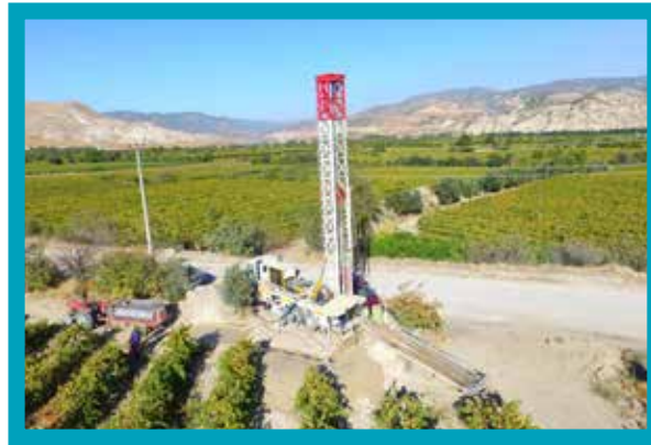
Buldan İlçesi Yenicekent Sondaj Çalışması
