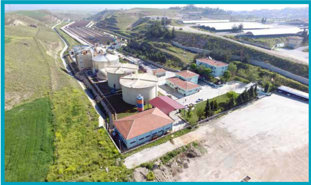
Merkez Atıksu Arıtma Tesis
