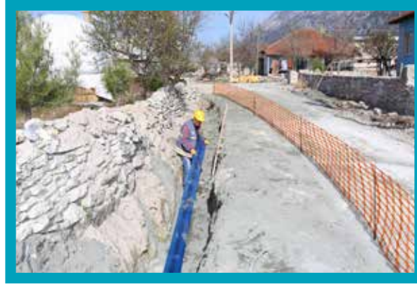
Çardak Gemiş İçmesuyu Hattı Yapımı
