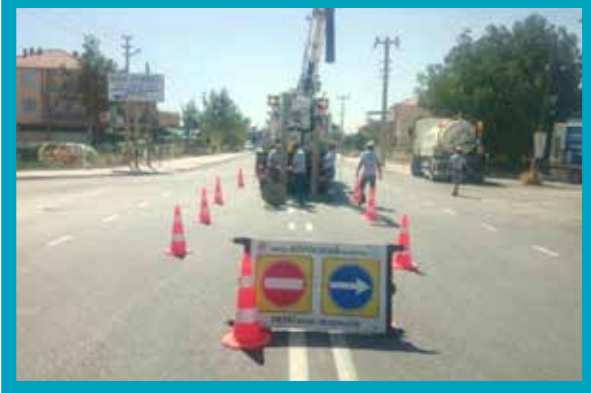
Çivril İlçesi Merkez Mahallede Kanalizasyon Ana Hatlarda Kombine Aracı ile Temizlenmesi
