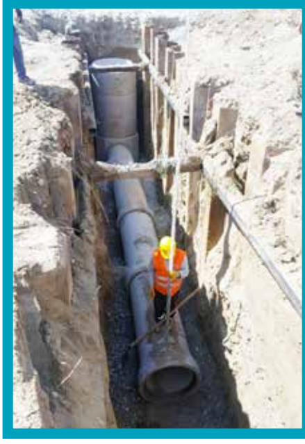
5.Bölge Sarayköy Kanalizasyon Hattı Kontrol Ölçümü
