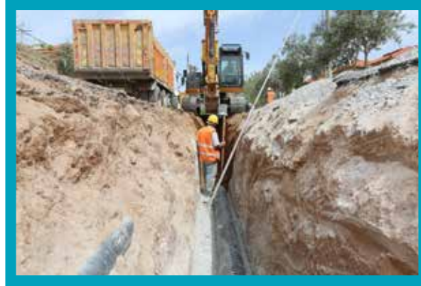
Karahisar Kanalizasyon Hattı Yapımı
