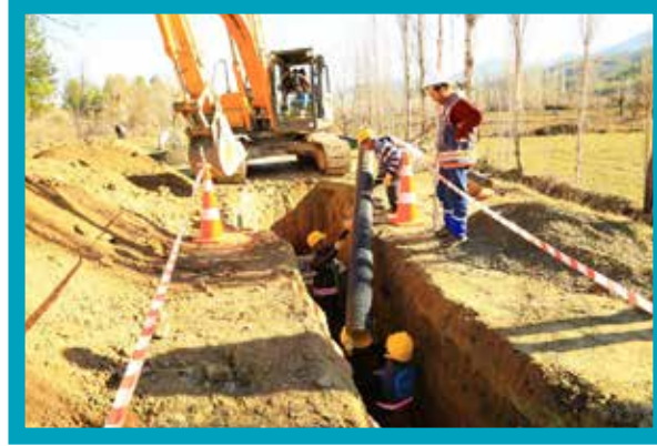
Beyağaç Merkez Kanalizasyon Hattı Yapımı
