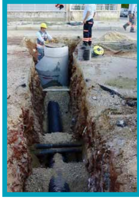
Merkezefendi İlçesi Selçukbey Mahallesi Ø300 mm Kanalizasyon Hattı İmalatı
