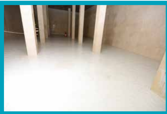
Merkezefendi İlçesi Çakmak İçmesuyu Deposu (Temizlikten sonra)
