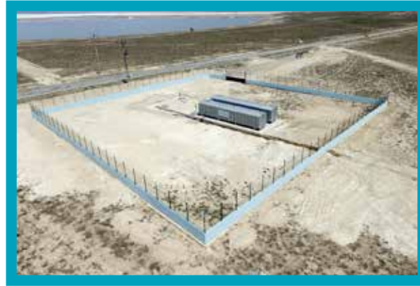
Çardak - Gemiş Paket Atıksu Arıtma Tesisi
