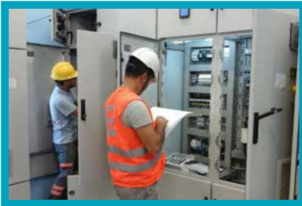
Elektrik Pano Yenileme Çalışması
