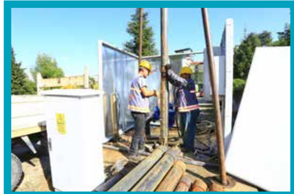
Pompa Değişim İşlemi
