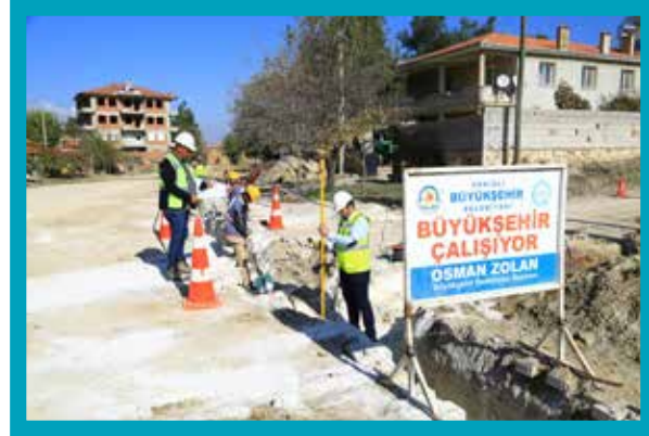
1. Bölge Çıtak Kanalizasyon, İçmesuyu Kontrol Ölçümü
