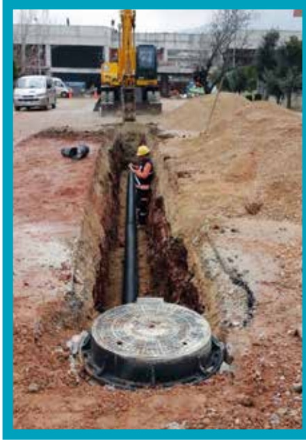
Merkezefendi İlçesi Bereketli (Bereketler) Mahallesi Ø300 mm Kanalizasyon Hattı Yapımı
