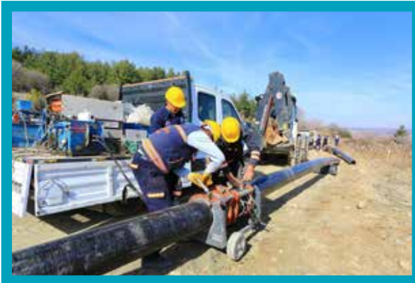
Çal İlçesi Akkent Mahallesi İçmesuyu Hattı İmalatı
