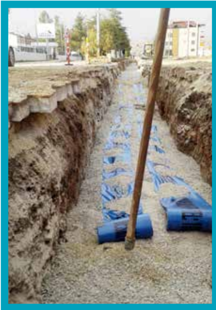
Çivril Muhtelif Mahallelerde İçmesuyu İsale Hattı Yapımı
