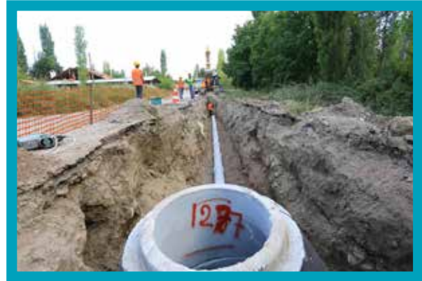
Acıpayam Muhtelif Kanalizasyon Hattı Yapımı
