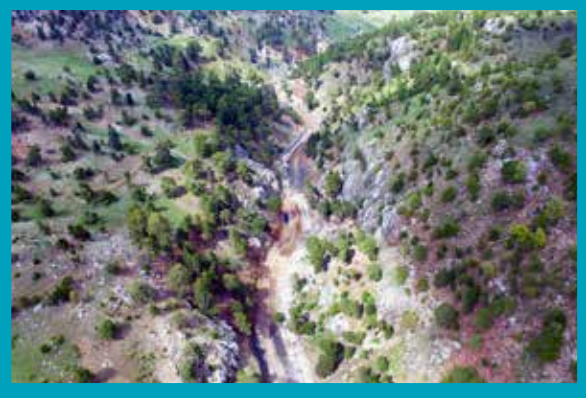
Acıpayam İlçesi Eşeler Yaylası Yol Geniştirme ve İçmesuyu İsale Hattı İmalatı
