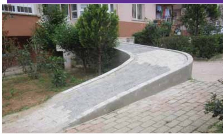
Uğur Mumcu Mahallesi Mazi Sokak Engelli Rampası Yapımı
