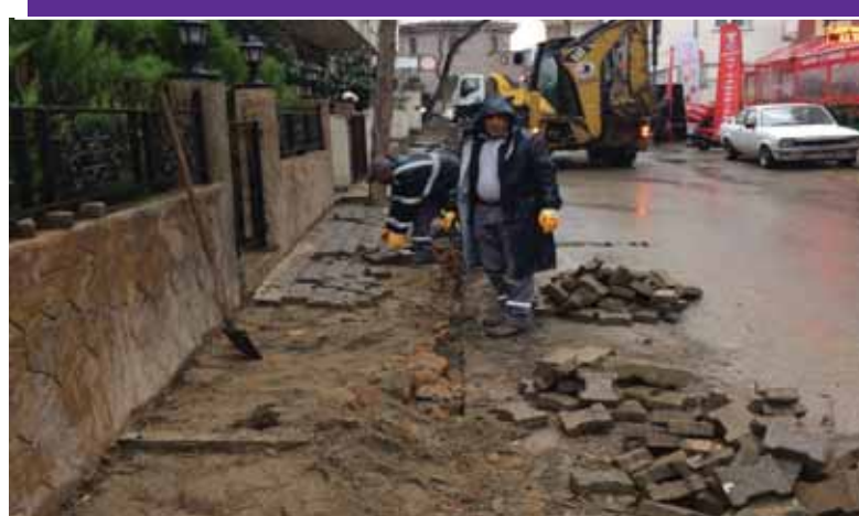
Orhantepe Mahallesi İtir Sokak Kilittaşı Yapımı
