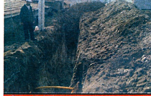
GÖLHİSAR MAH. KANALİZASYON ÇALIŞMASI
