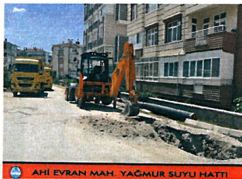
AHI EVRAN MAH. YAĞMUR SUYU HATTI
