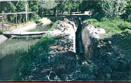
GÜZLER SULAMA KANALİZASYON ÇALIŞMASI
