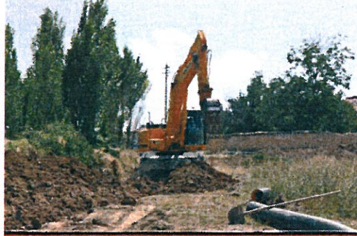
HIZIRAGA MAH. KANALİZASYON ÇALIŞMASI
