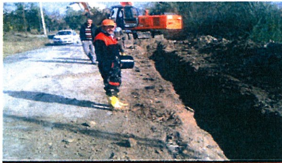
ÜÇGÖZ MEVKİ KANALİZASYON ÇALIŞMASI
