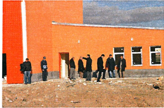
Hal Binası İncelemeleri
