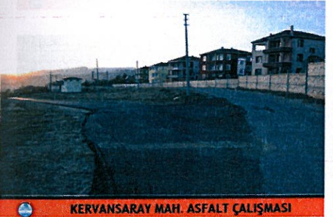
KERVANSARAY MAH. ASFALT ÇALIŞMASI
