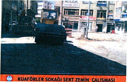
KUAFÖRLER SOKAĞI SERT ZEMİN ÇALIŞMASI
