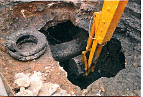
MAŞADERESİ KANALİZASYON TEMİZLEME ÇALIŞMASI
