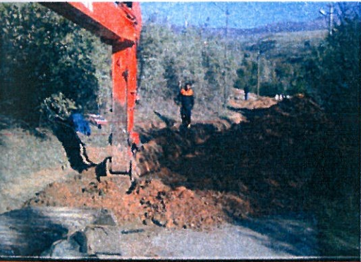
ÖKSE MAH. KANALİZASYON ÇALIŞMASI
