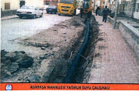
AŞIKPAŞA MAHALLESİ YAĞMUR SUYU ÇALIŞMASI
