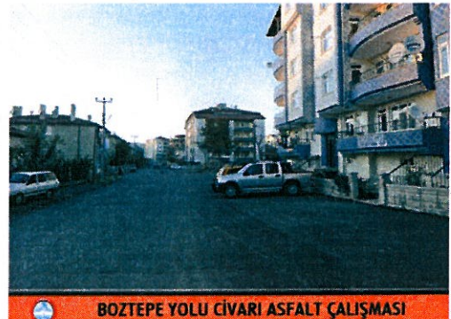
BOZTEPE YOLU CİVARI ASFALT ÇALIŞMASI
