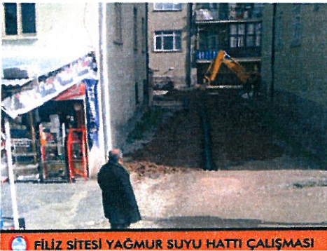
FİLİZ SİTESİ YAĞMUR SUYU HATTI ÇALIŞMASI
