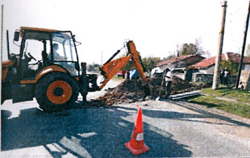
KANALİZASYON BAĞLANTI ÇALIŞMASI
