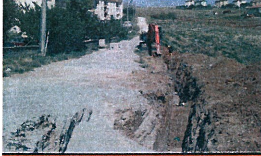
KERVANSARAY MAH. KANALİZASYON ÇALIŞMASI
