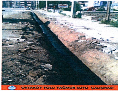
ORTAKÖY YOLU YAĞMUR SUYU ÇALIŞMASI
