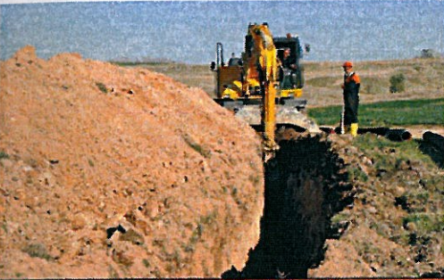
GÜNEYKENT ALTYAPI ÇALIŞMASI
