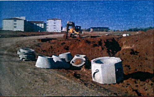
AHI EVRAN ÜNİVERSİTESİ KANAL HATTI ÇALIŞMASI
