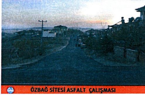
ÖZBAĞ SİTESİ ASFALT ÇALIŞMASI
