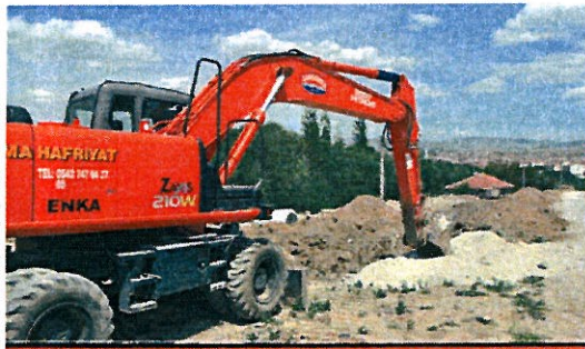
MAKISSOS OTEL KANALİZASYON ÇALIŞMASI
