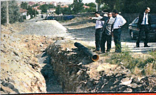
NASUHDEDE MAH. KANALİZASYON ÇALIŞMASI
