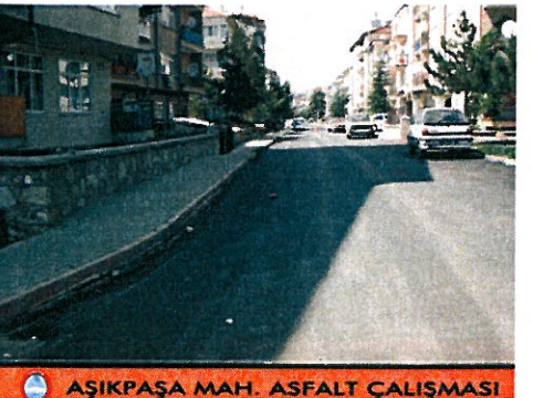
AŞIKPAŞA MAH. ASFALT ÇALIŞMASI
