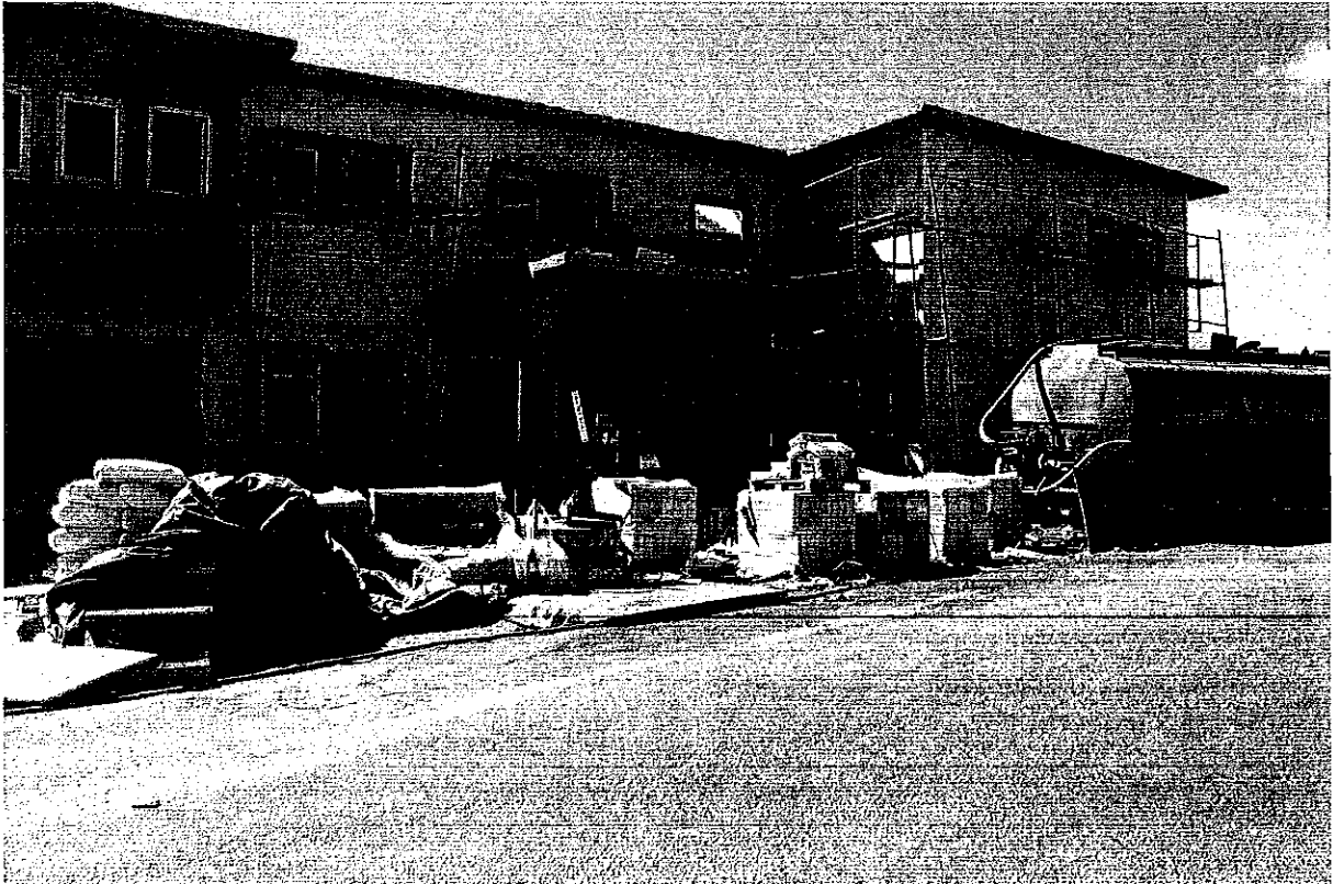
Engelsiz Yaşam Merkezi İnşaatı
