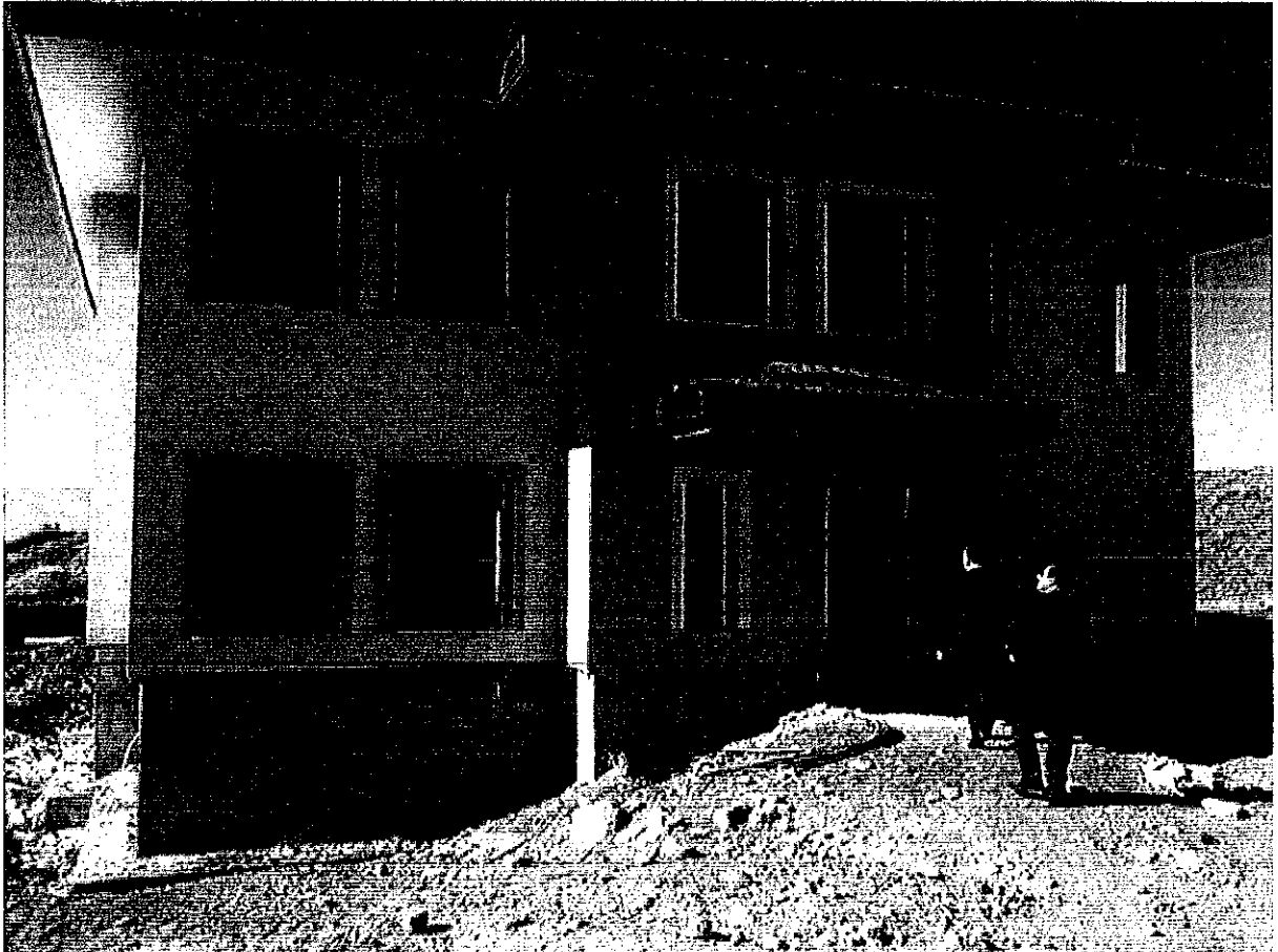
Sevgi Evleri İnşaatı
