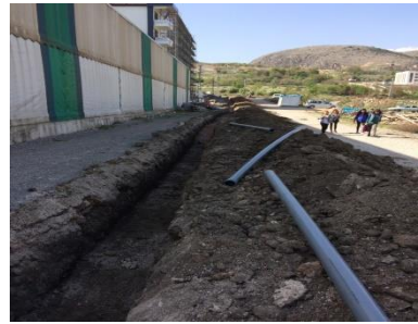
Şeyhcuı Mah. İçmesuyu Hat Çalışması
