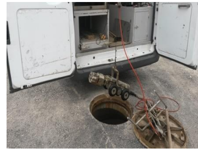
Kanalizasyon Hatlarının Kamera ile Kontrolü
