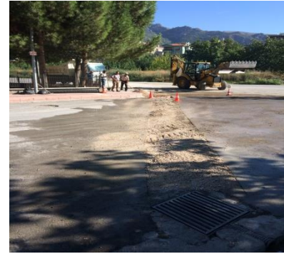
Yağmursuyu Hat ve Izgara Tamirati
