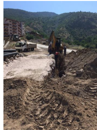
Kirazlıdere Mah. Kanalizasyon Hat Çalışması
