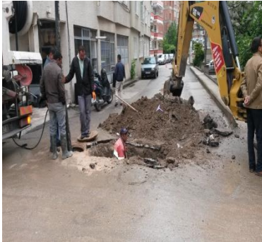
Vidanjörle kanalizasyon hattı ve baca temizliği
