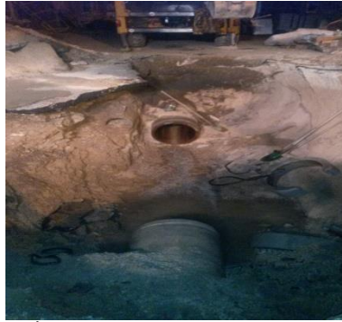
İçmesuyu Asbest Boru Tamirati
