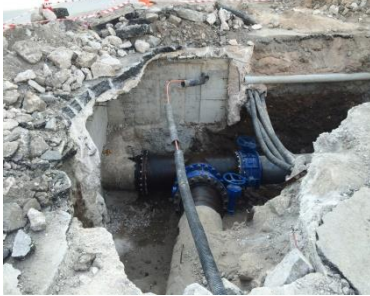
İçmesuyu Hat Tamirati
