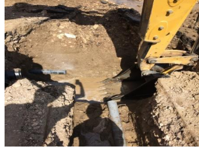
Hacılar Meydanı Mah. İçmesuyu Hat Çalışması
