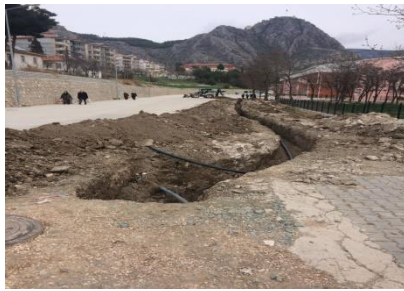
Hızırpaşa Mah. İçmesuyu Hat Çalışması
