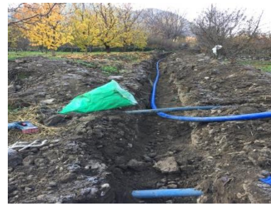
Yeşilyenice Mah. İçmesuyu Hat Çalışması
