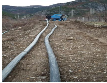
Filingirler Mah. İçmesuyu Hat Çalışması
