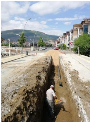
Hızırpaşa Mah. Kanalizasyon Hat Çalışması
