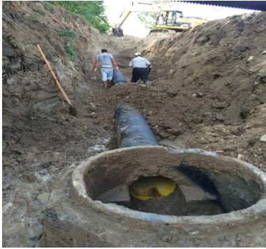
Kanalizasyon Hat ve Baca Tamirati
