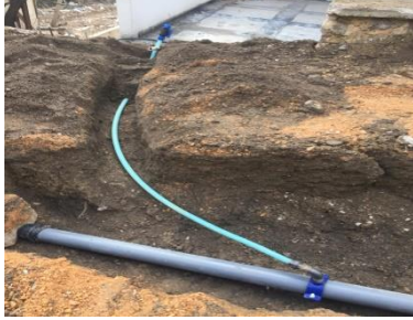
Akbilek Mah. İçmesuyu Hat Çalışması
