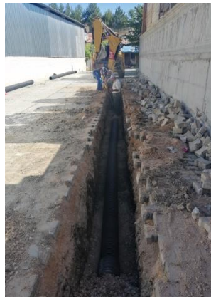
Koza Mah. Kanalizasyon Hat Çalışması
