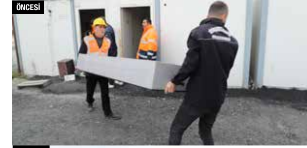
KARAAĞAÇ ASFALT PLENTİ YIKIM
