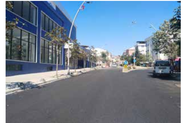
Fotoğraf 1: Asfalt Yol Yapım Çalışması – Ulus Mahallesi – Çiğdem Caddesi
