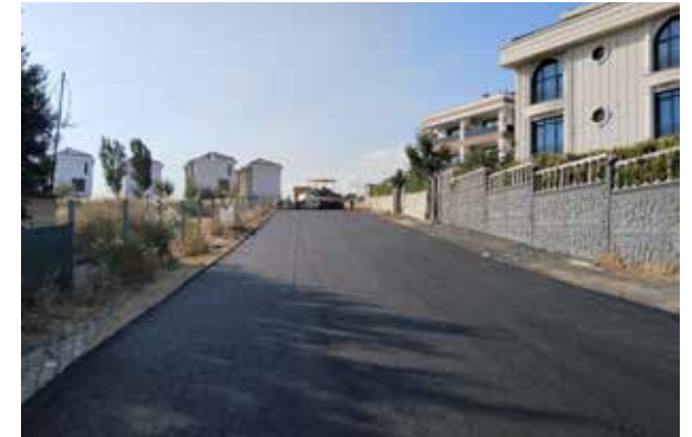
Fotoğraf 2: Asfalt Yol Yapım Çalışması -Muratçesme Mahallesi Ömer Seyfettin Sokak
