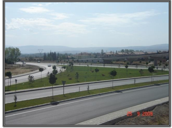
Konya Yolu Kavşağı Sonrası
