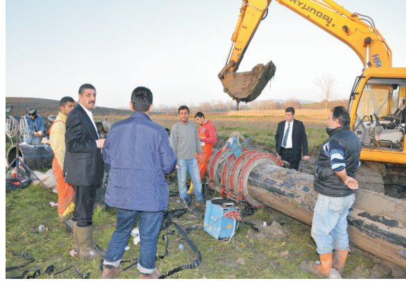
ŞEHİR İÇİ İÇMESUYU HATLARININ ESKİYEN BÖLÜMLERİNİN DEĞİŞTİRİLMESİ
