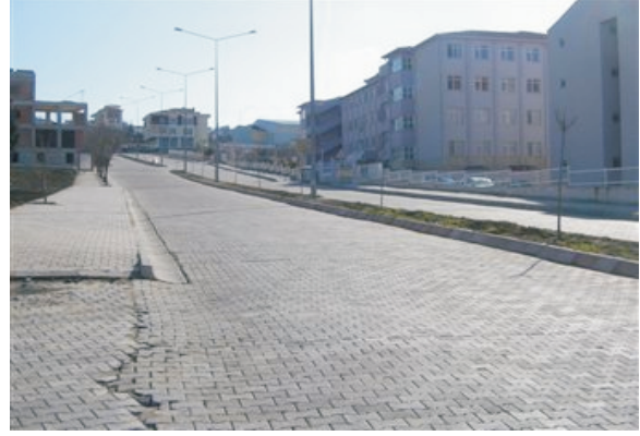
HÜRRİYET MAHALLESİ ÖĞRETMENLER CADDESİ PARKE TAŞ
