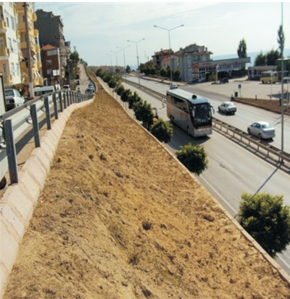
HÜRRİYET MAHALLESİ ŞEV ÇALIŞMASI
