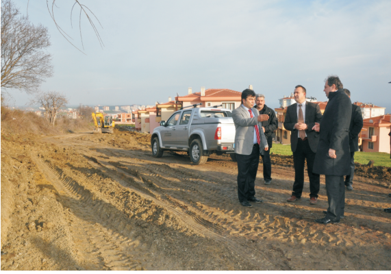
RÜŞTÜ ÖKELER SOKAK YOL YAPIM ÇALIŞMASI
