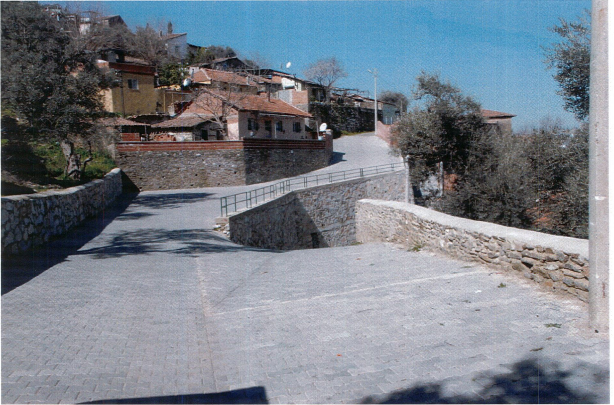
Atlanbaç üst sokak - Alt-üst yapı çalışmaları-kilit taş ve örme duvar çalışması
