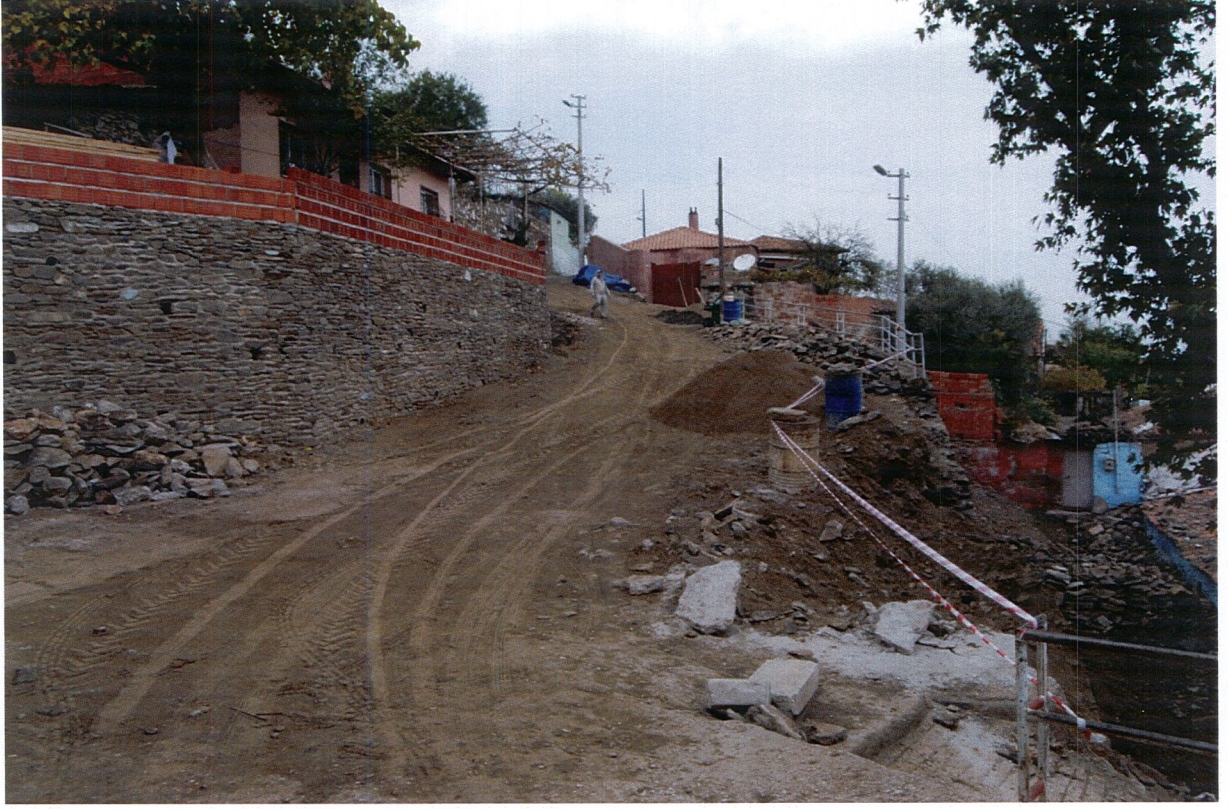
Atlanbaç üst sokak - Alt-üst yapı çalışmaları-kilit taş ve örme duvar çalışması
