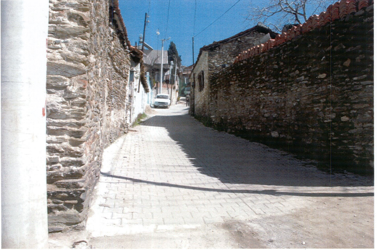
KATIRCILAR SOKAK ALT YAPI-KANALİZASYON-ÜST YAPI ÇALIŞMALARI
