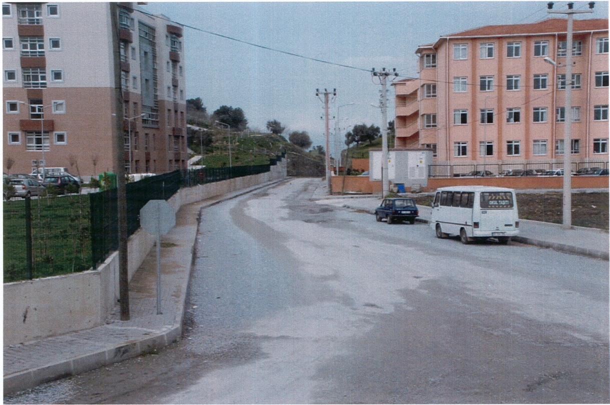
YOL GENİŞLETME-ALT YAPI-ÜST YAPI ÇALIŞMASI
