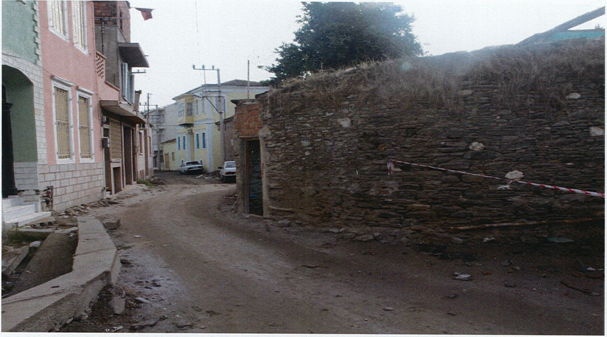
YALNIAYAK SOKAK EV YIKIM YOL GENİŞLETME ÇALIŞMASI
