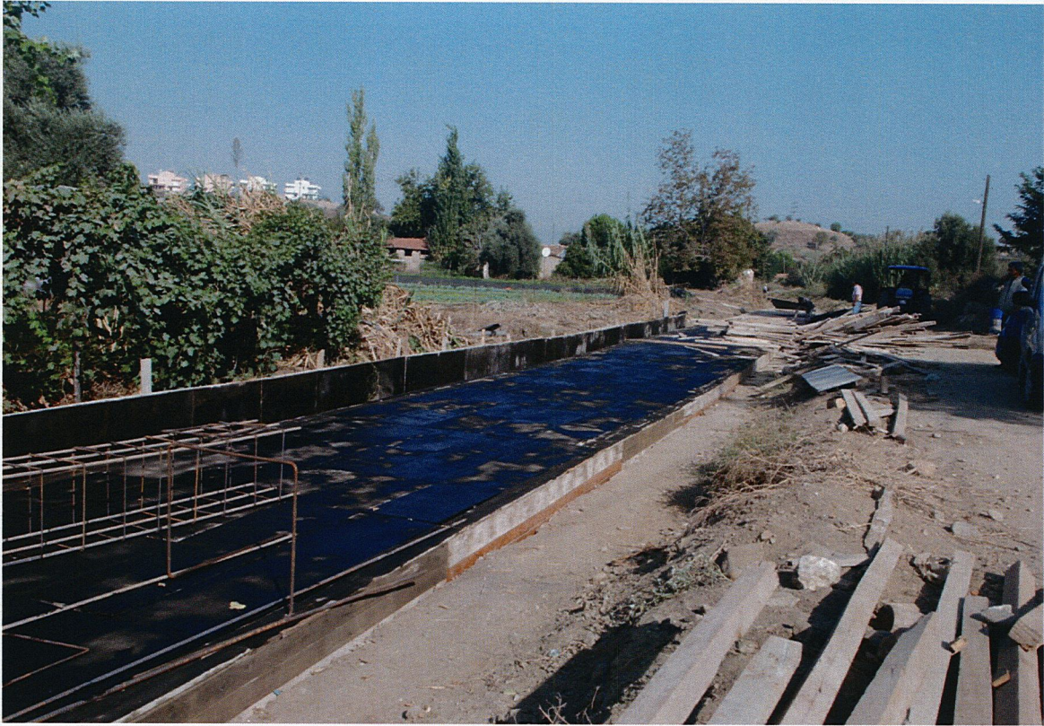
Tirede Konut alanı içerisinde açık dere kalmadı.Tüm dereler kapatıldı.
