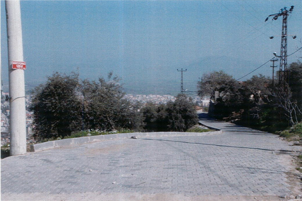
Börekçi Bağı Parke ve Yol Çalışması
