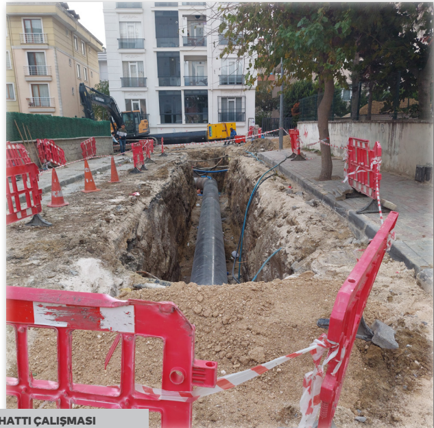
İÇME SUYU ŞEBEKE HATTI ÇALIŞMASI
