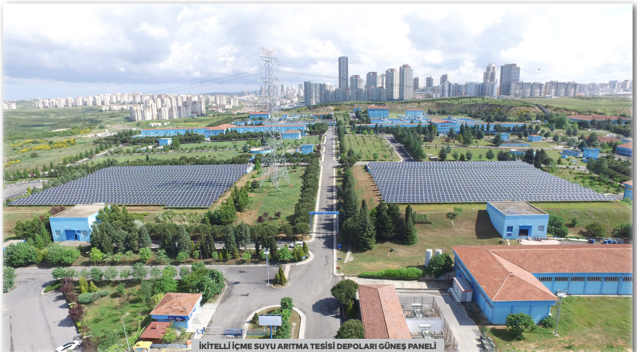
İKİTELLİ İÇME SUYU ARITMA TESİSİ DEPOLARI GÜNEŞ PANELİ
