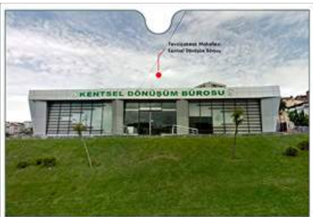
• Fevziçakmak Mahallesi Kentsel Dönüşüm Ofisi
