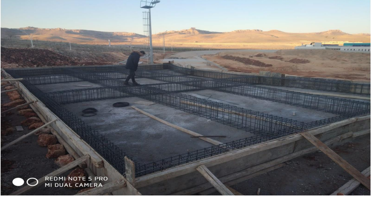
Mardin ili Artuklu ilçesi veledrom yapım işi.
