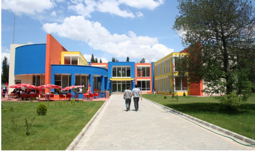
Çayırova Yerleşkesi Ana Kantin Binası
