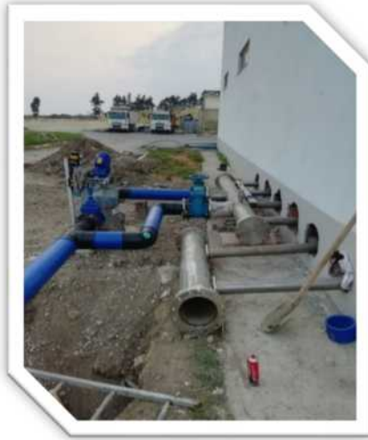
Karaduvar Atıksu Arıtma Tesisi Çamur Susuzlaştırma hattı revizyonu
