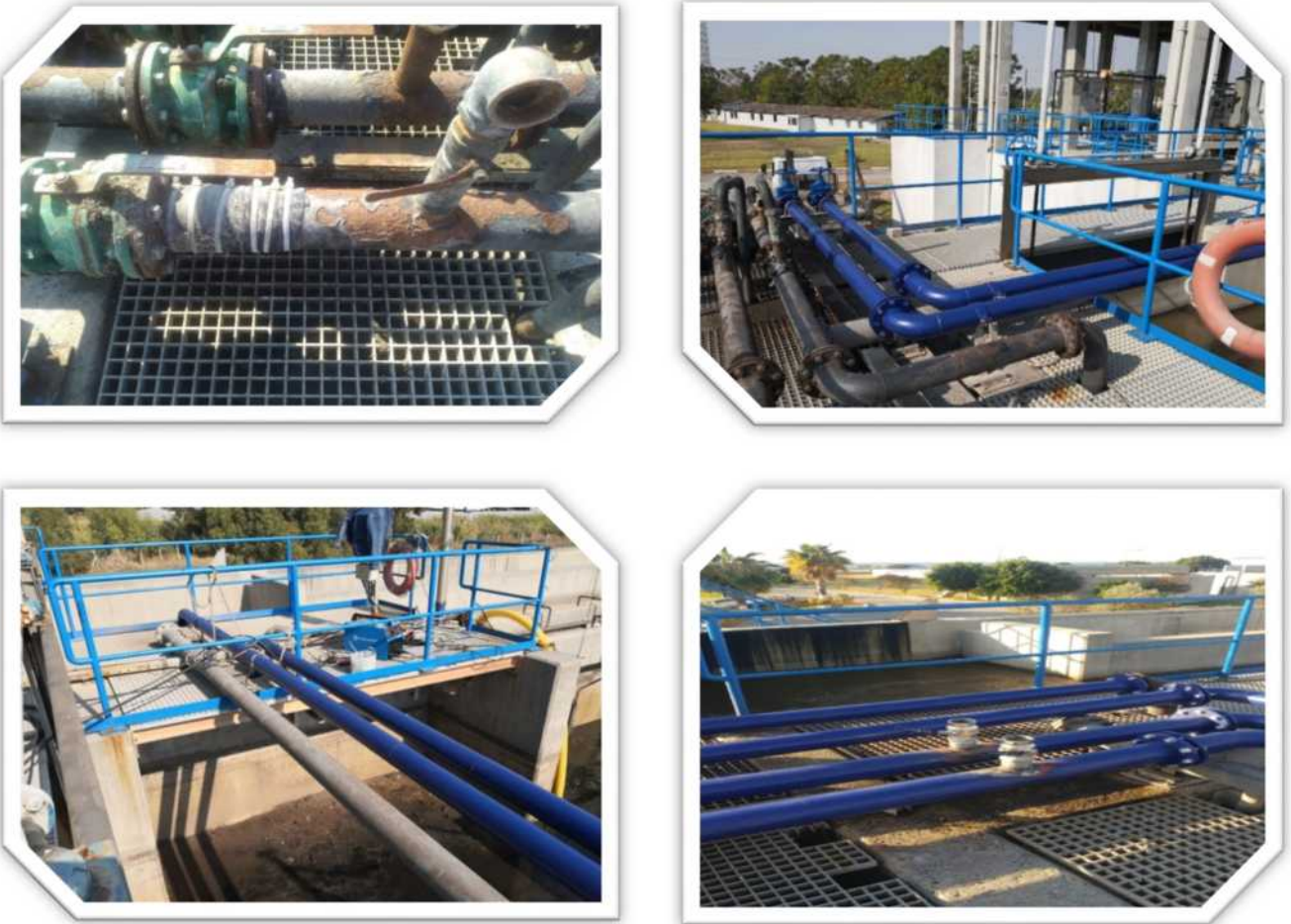
Karaduvar Atıksu Arıtma Tesisi Kum Hattı Revizyonu
