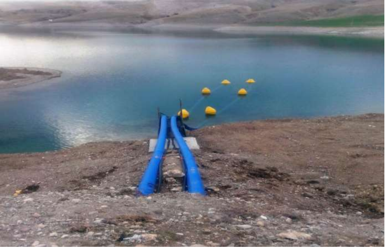
Kahta Oluklu İçme Suyu çalışmaları
