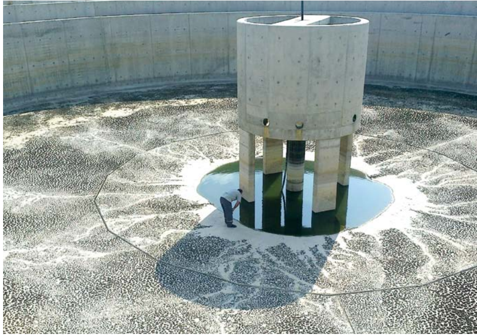
Arıtma tesisinde sivrisinek üremesine uygun bir alanda larvasid ilaç uygulaması
