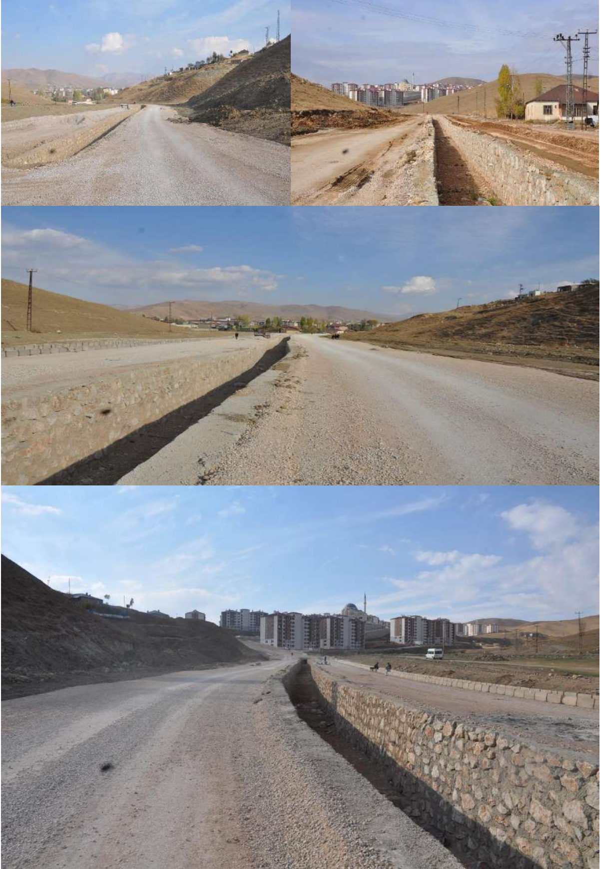
TOKİ YOLU ASFALT YAIMI
