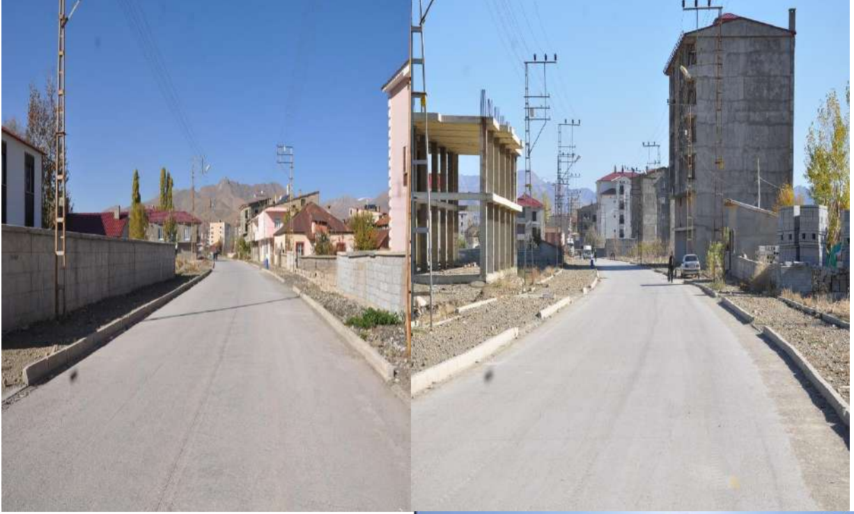
Asfalt Yol Yapımları G ng r Mahallesi(23 nisan cadesi)/ 2020-2021
