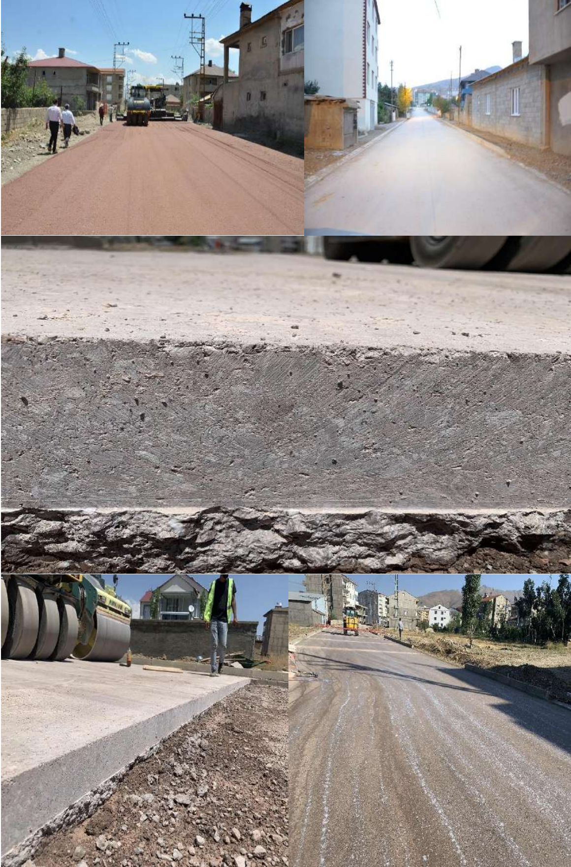
Asfalt Yol Yapımları G ng r Mahallesi/ 2020-2021
