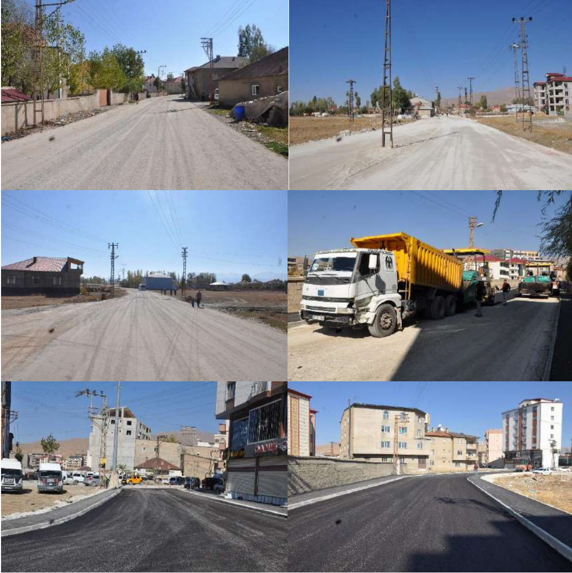
Asfalt yol yapımları
