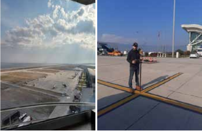
(Hatay Havalimanı Depremden Sonra Yerinde İnceleme ve Ölçümler)
