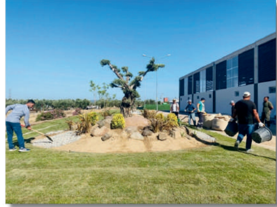
Türkelli Kapalı Pazar Yeri ve Park Yapımı Çalışmaları
