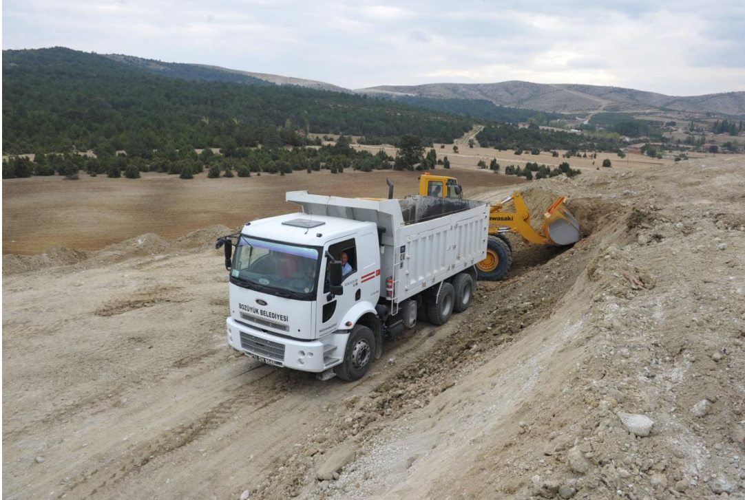
Yeni Yol Açma Çalışmaları
