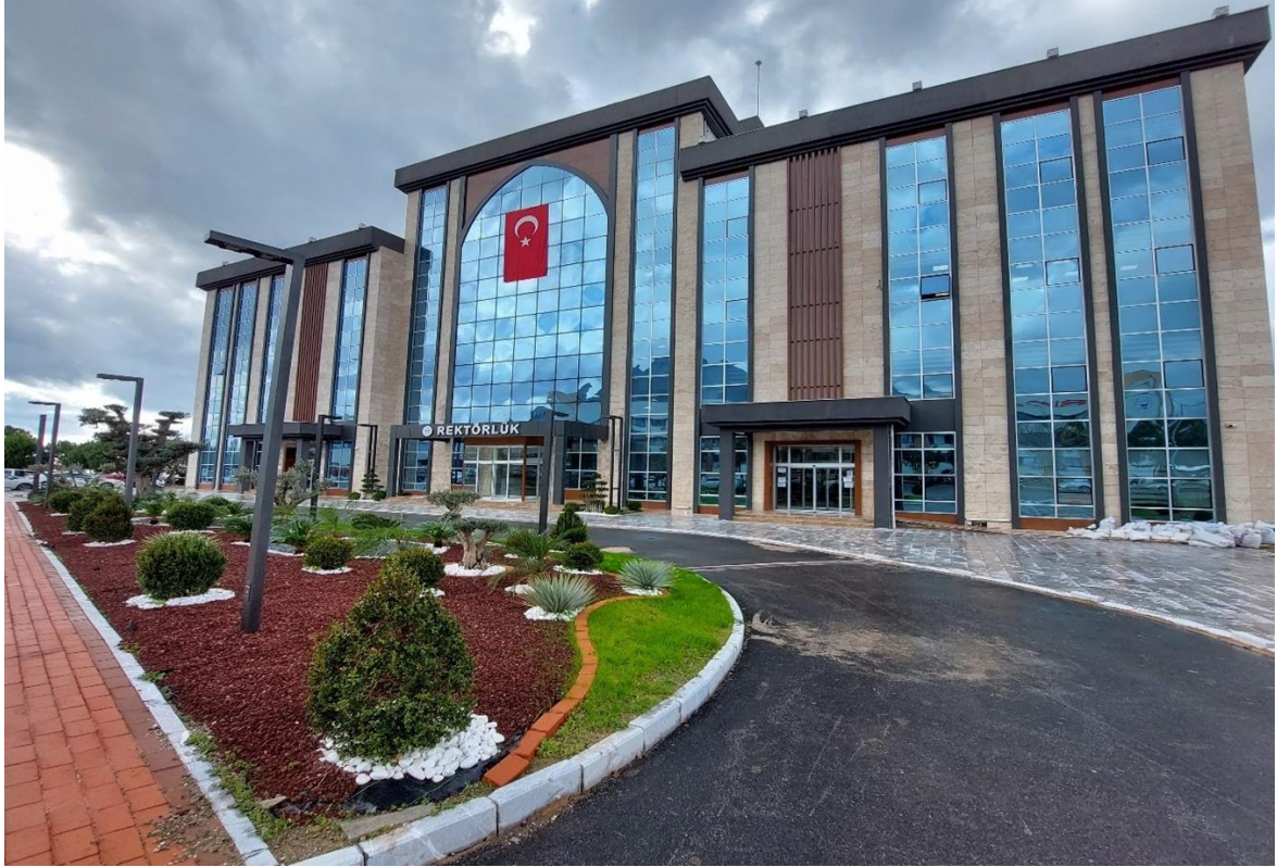
Yeni Rektörlük ve Merkezi Derslikler Binası
