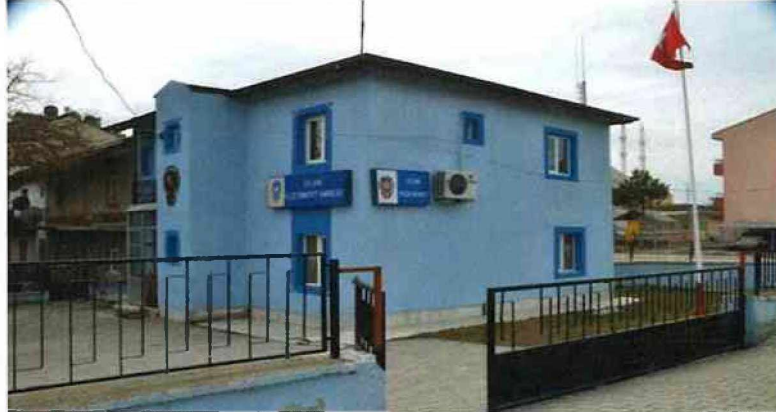
Eski Hizmet Binası
