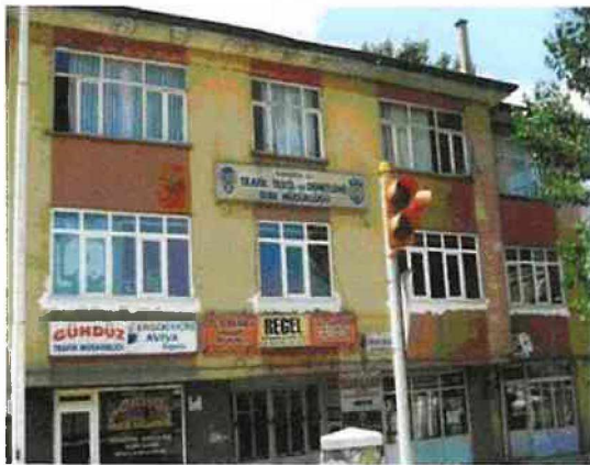
İl Özel İdare Arşiv Binası
