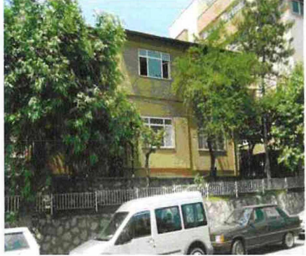
Eski Hizmet Binası
