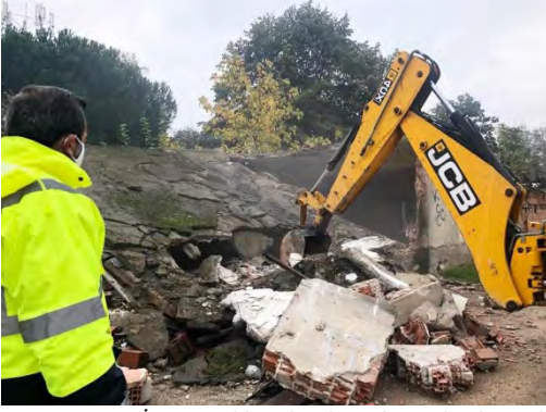
UYGULAMA: İş Güvenlik önlemleri alınarak yıkım işlemi gerçekleştirilmiş olup temizlik işlemi yapılmıştır.
