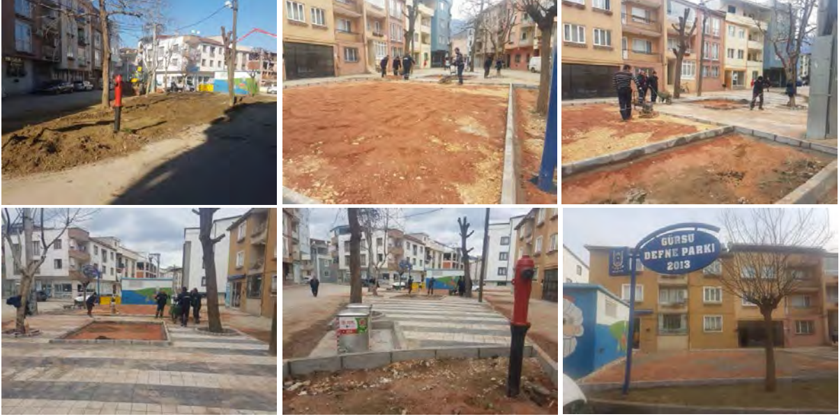
Kurtuluş Mahallesi Defne Parkı yeniden trotuar bordür ve parke çalışması yapıldı.
