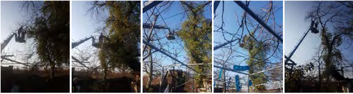
Kazıklı Mahallesi eve zarar veren meşe ağacı vinç yardımıyla kesildi.
