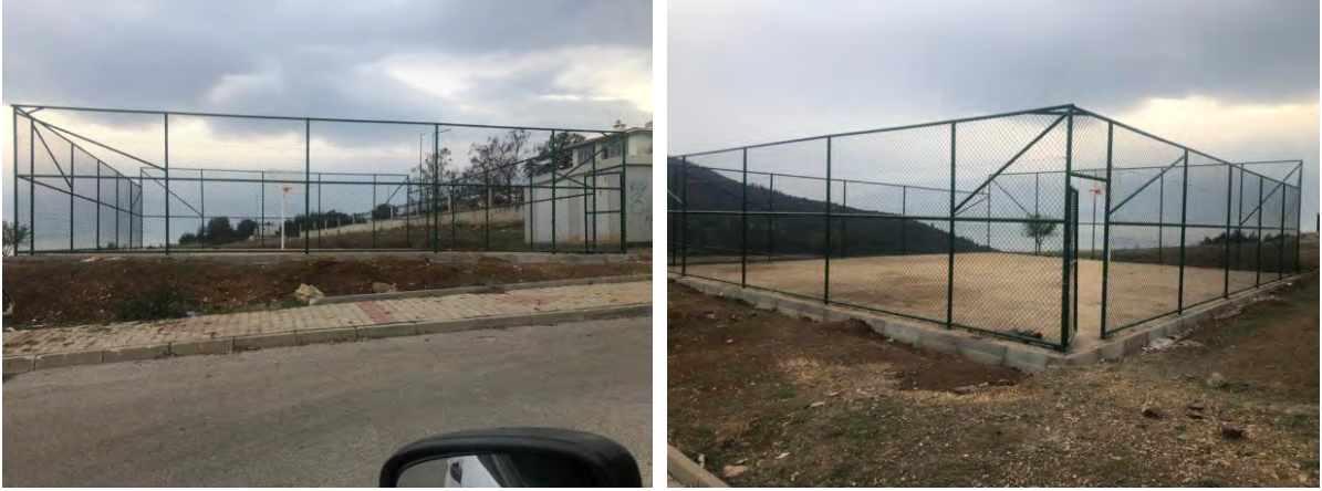
TOKİ Basketbol sahası yapımı
