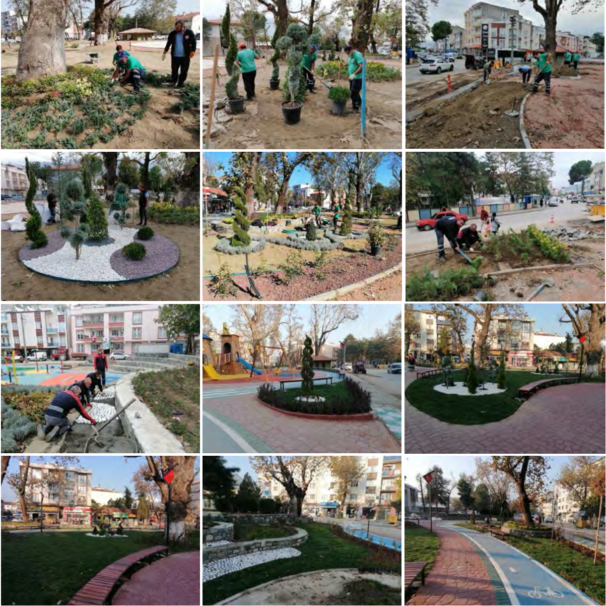
Celalbey Millet Bahçesi peyzaj düzenlemesi çalışmalarından
