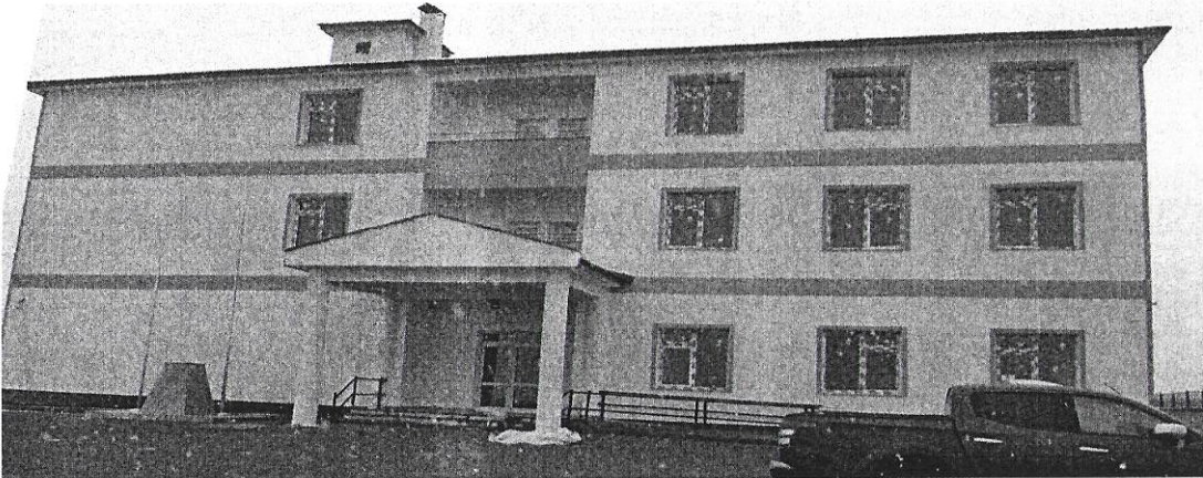
Kars Merkez Verimli Köyü 8 Derslikli Okul Yapım İşi
