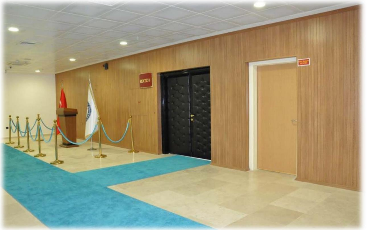
Şekil 15 : Rektörlük Makam Kapısı Yalıtım Çalışması
