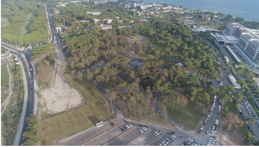
Belek İleribaşı Konaklamasız Orman Parkı / Belek Park Orman projesi yapım çalışmaları gerçekleştirilmiştir.
