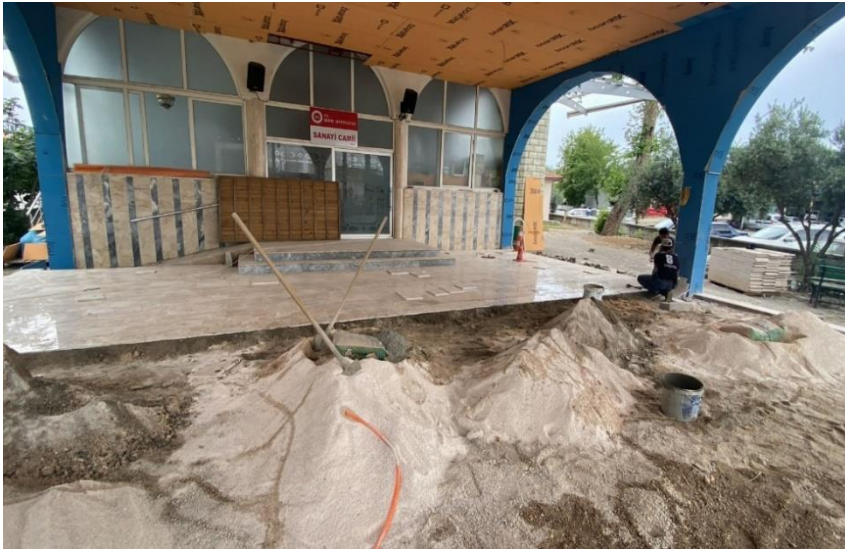
Sanayi Cami önüne mermer döşemesi yapılmıştır.
