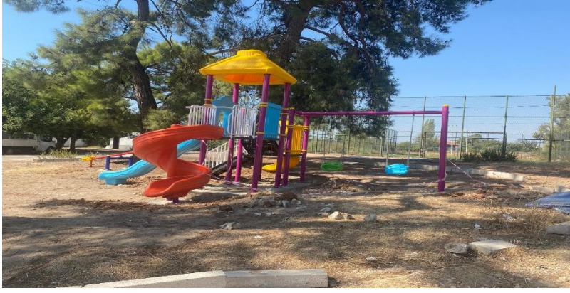
Töngüşlü Mahallesi Okul Yanı Parkta Oyun Grubu Montajı Yapılmıştır.
