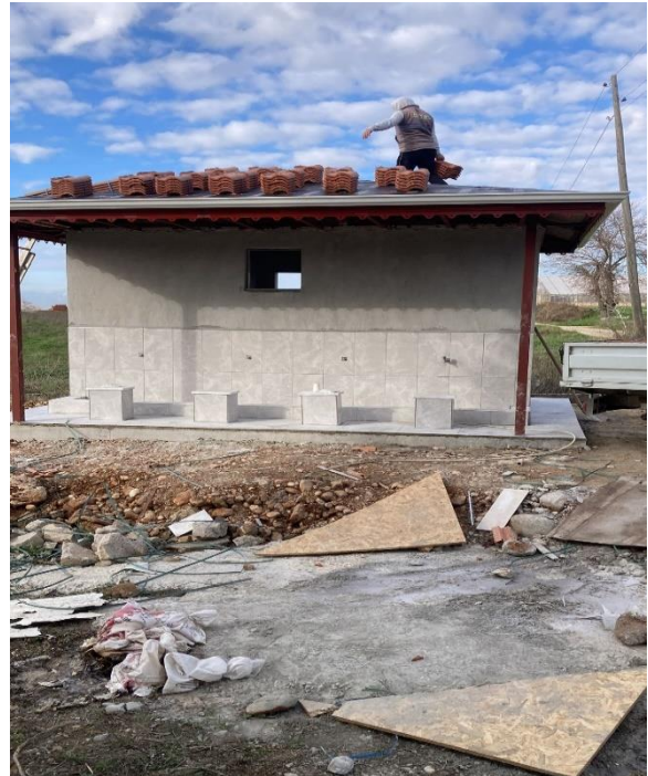
Aşağıçatma Mahallesi Mezarlığında tuvalet yapım çalışması gerçekleştirilmiştir.
