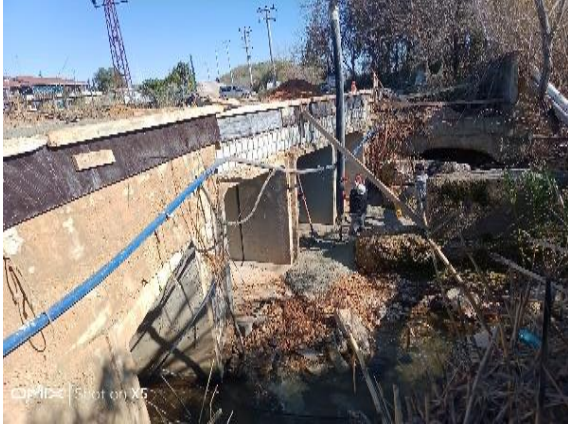
Eskiyörük Köprü Yapımı
