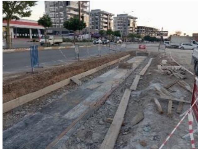
Orta Mah. Yağmur suyu box yapımı
