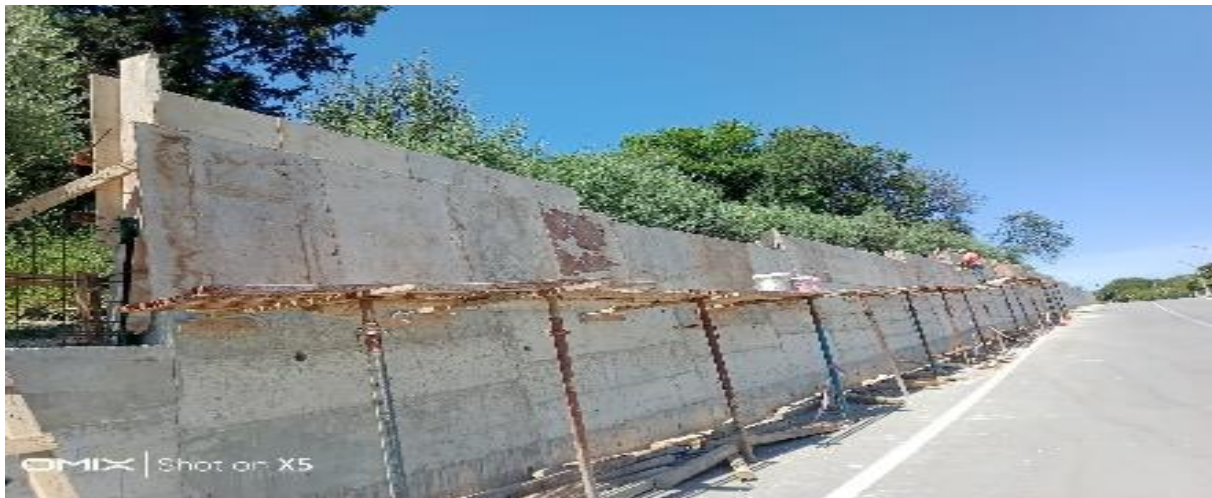
Orta m.2135 sok. İstinat duvarı yapımı
