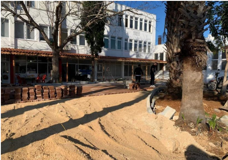
Belek Mahallesi Acısu Kenarında WC yapım çalışmaları gerçekleştirilmiştir.
