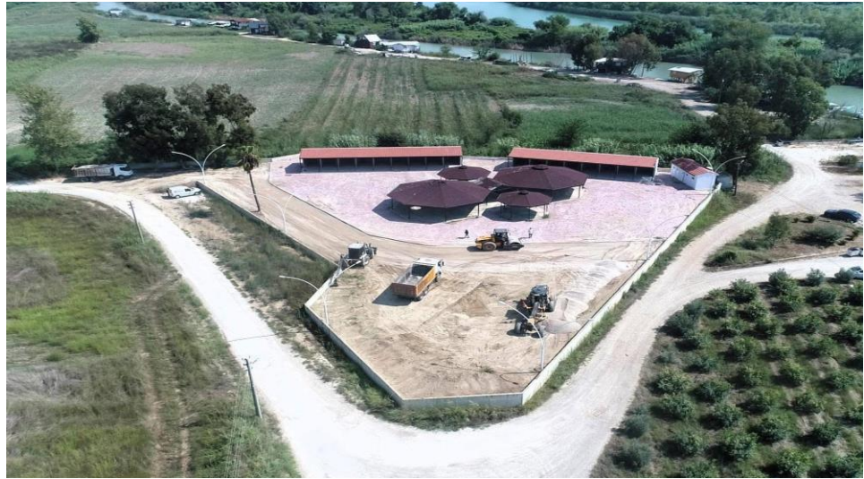
Boğazkent Balık Pazarı proje ve altyapı çalışmaları yapılmıştır.
