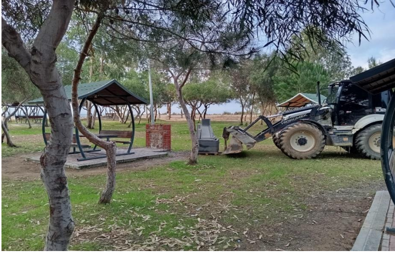
Boğazkent Beach Park barbekü yenileme çalışmaları yapılmıştır.
