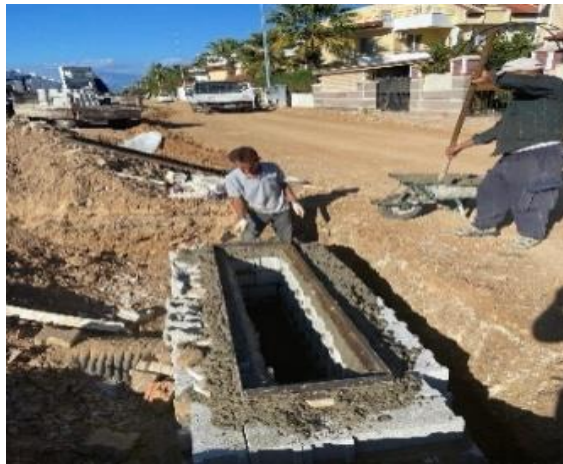
Kadriye Mahallesi Rögar Ve İzgara Yapımı
