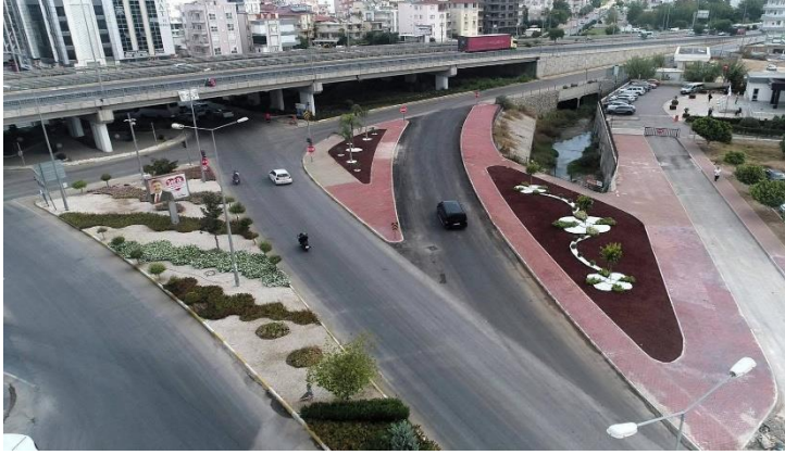
Yeni yapılan Adliye-D400 bağlantı kavşağı çevresinde peyzaj çalışması yapılmıştır.
