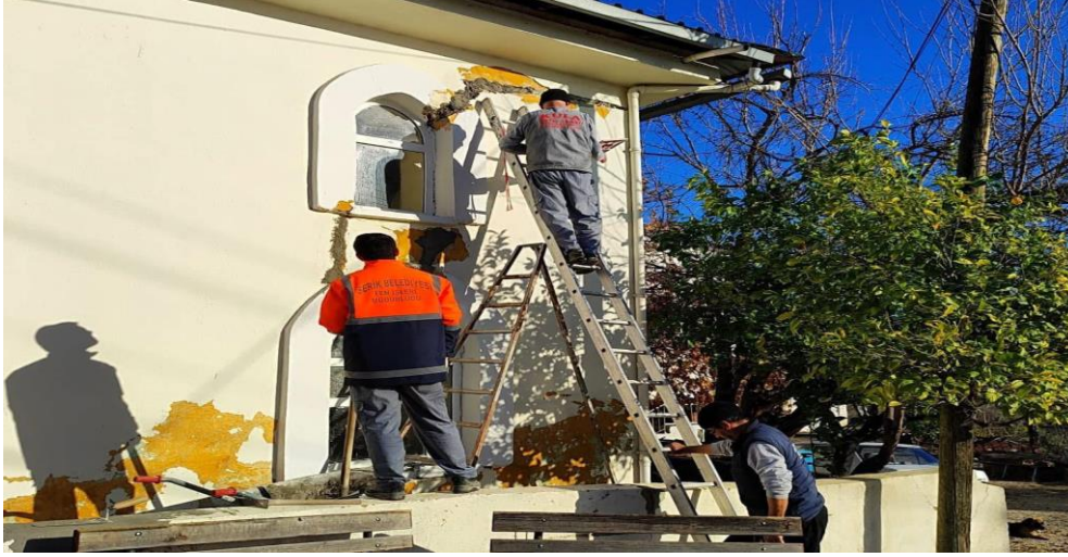
Kuşlar Camii dış cephe boyaması yapılmıştır.
