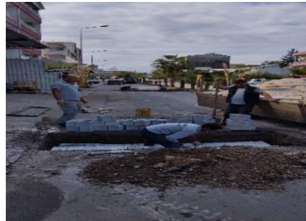
Yeni Mahalle Rögar Ve İzgara Yapımı
