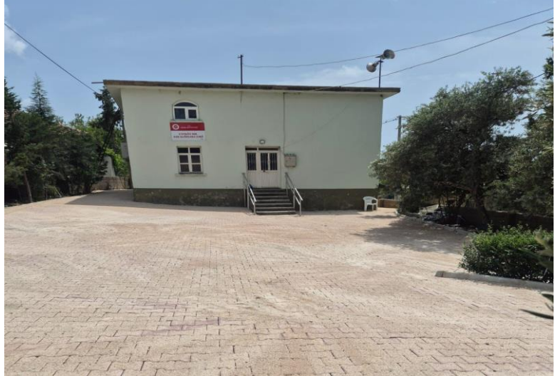
Yanköy Mahallesi Cami bahçesinde sert zemin çalışması yapılmıştır.
