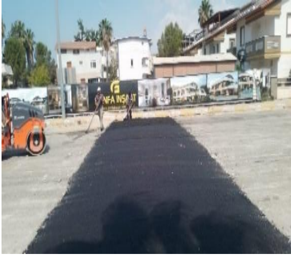
Belek Kasis Yapımı
