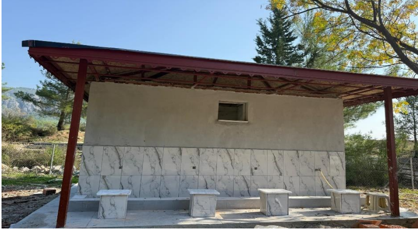
Karataş Mahallesi Mezarlığında tuvalet yapım çalışması gerçekleştirilmiştir.
