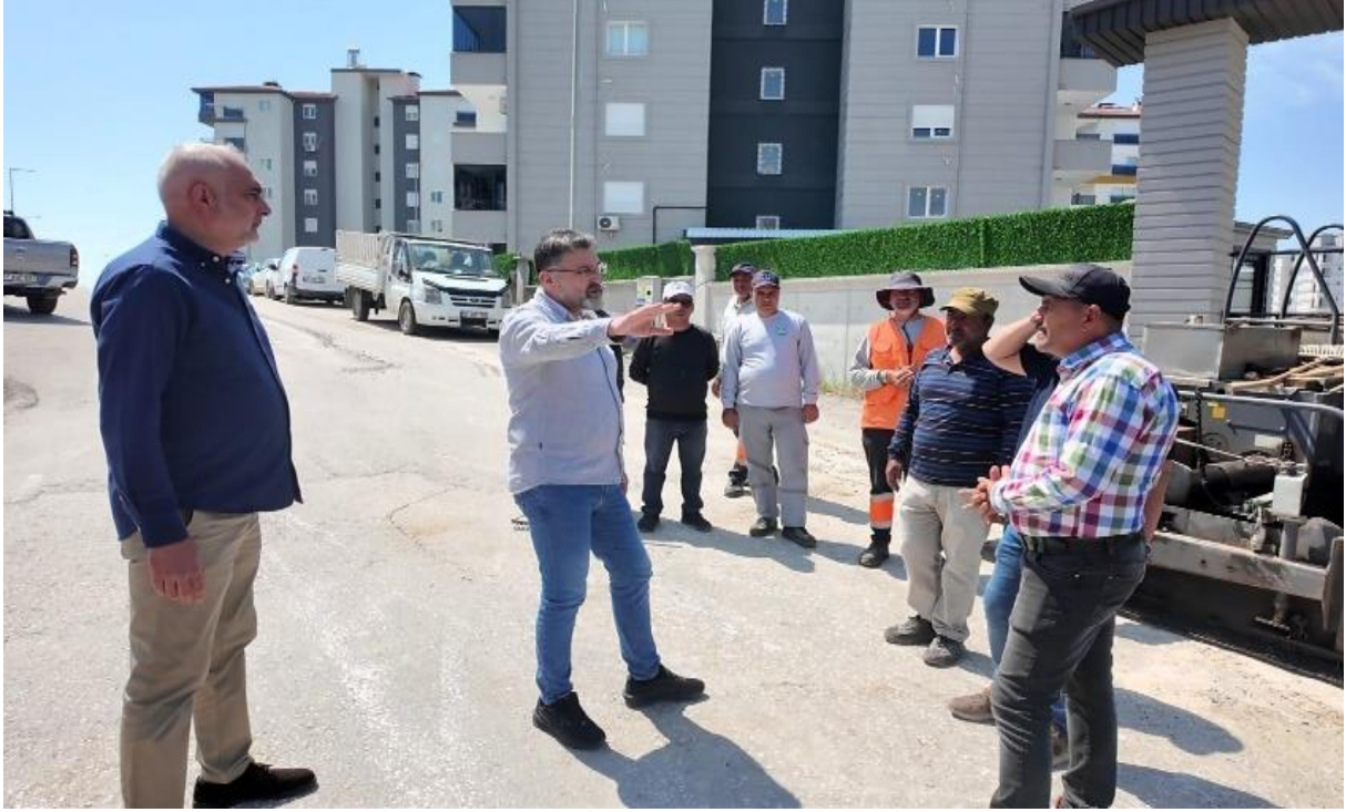
Orta Mahalle 1341. Sokak'ta sıcak asfalt serim çalışmalarını yerinde inceledik.
