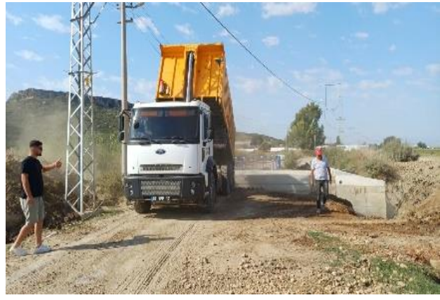
Yanköy 2.Köprü Yapımı
