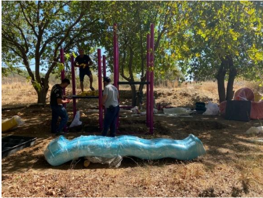
Aşağıoba Mesire Alanında Kilitli Parke Sert Zemin Yapım Çalışması İle Oyun Grubu Montaj Çalışması Yapılmıştır.
