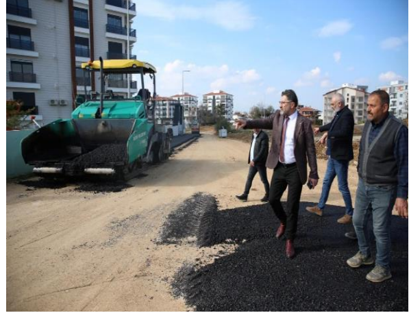
Orta Mahalle 1289. Sokak'ta devam eden asfalt serim çalışmalarını yerinde inceledik.(7 Ocak 2025)
