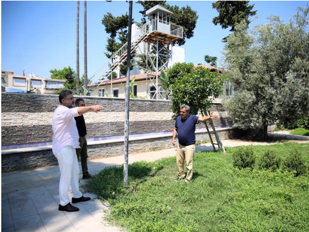
Orta Mahallemizde yapımı süren Kültür ve Sanat Merkezi inşaat çalışmalarını denetledik. (22 Temmuz 2025)
