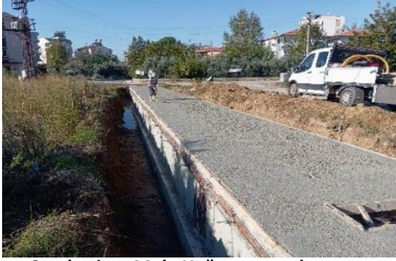
Cumhuriyet Mah. Yağmur suyu box yapımı
