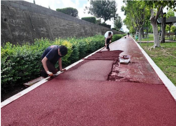
Şehit Asker Ramazan Yeşil, Abdülkadir Çelik Parkı yürüyüş yolu bakım ve onarım çalışmaları gerçekleştirilmiştir.
