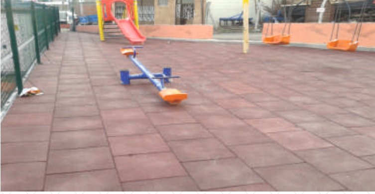
SÖLÖZ MAHALLESİ ÇOCUK PARKI ZEMİNİNE KAUÇUK KAPLAMA YAPILMASI
