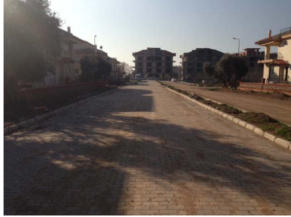
M. Sinan Mahallesi Balıkköy Bulvarı yol döşeme
