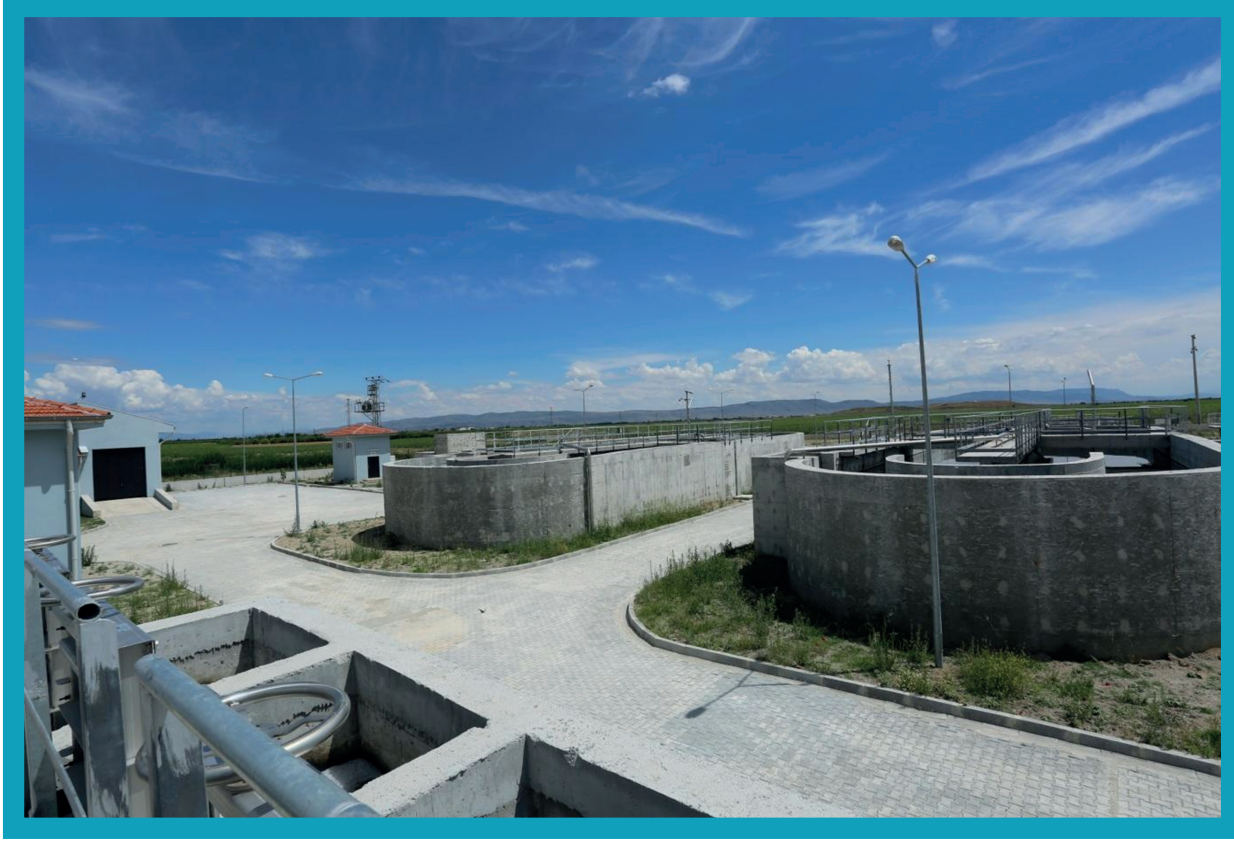
Çivril Atıksu Arıtma Tesisi
