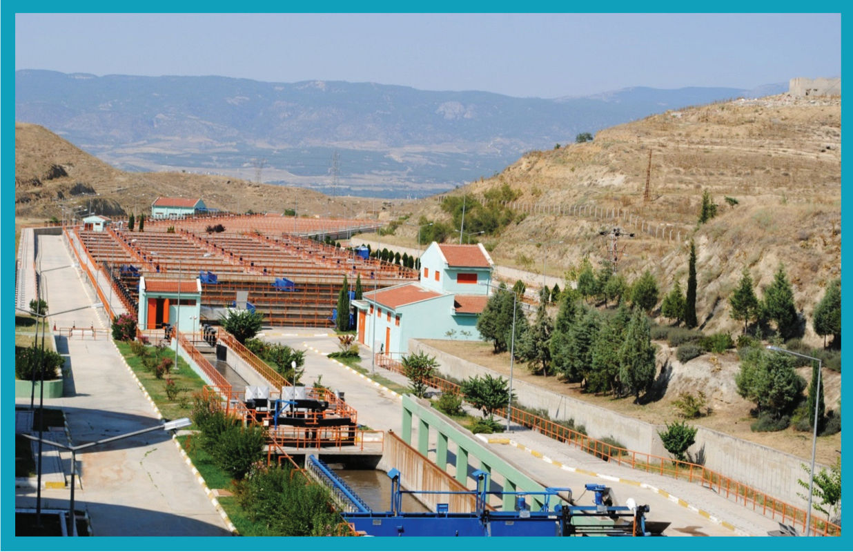
Merkez Atıksu Arıtma Tesisi
