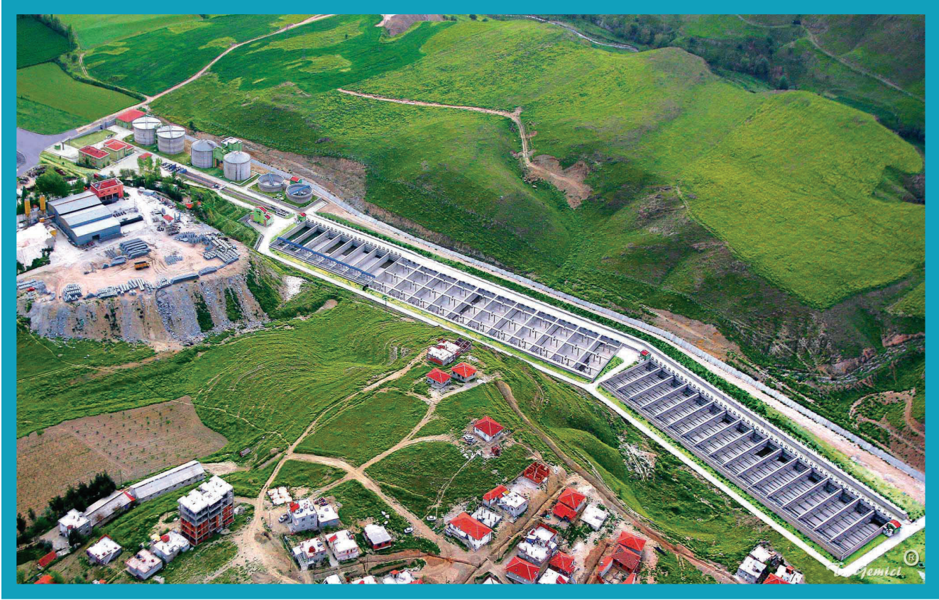
Merkez Atıksu Arıtma Tesisi
