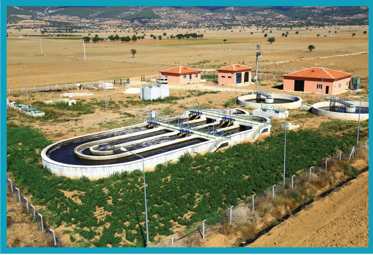
Serinhisar Atıksu Arıtma Tesisi
