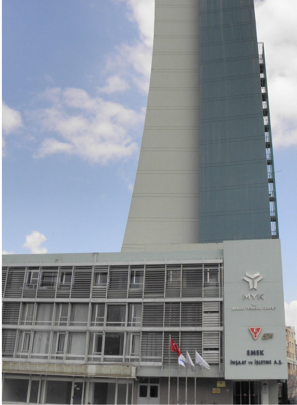
Resim 1- MYK Hizmet Binası
