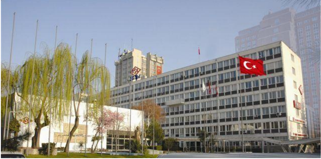
Şekil 1: TSE Merkez Binası
