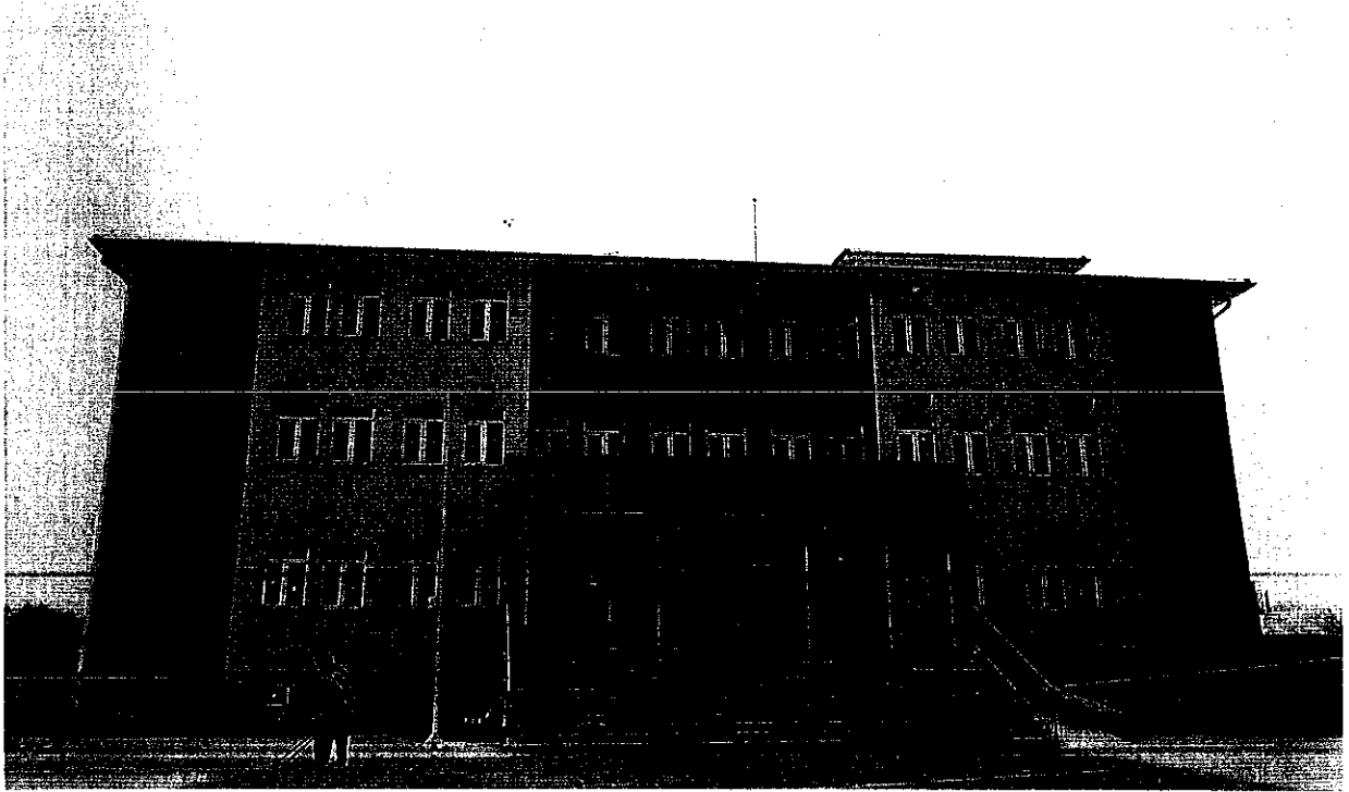
Çukurkuyu Bozyazı İ.Ö.O. Ek Bina İnşaatı
