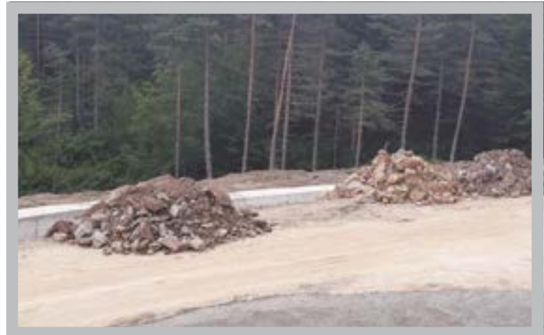
Kaynaşlı İlçesi Topuk Yaylası Yolu (Fore Kazık Sistemi)
