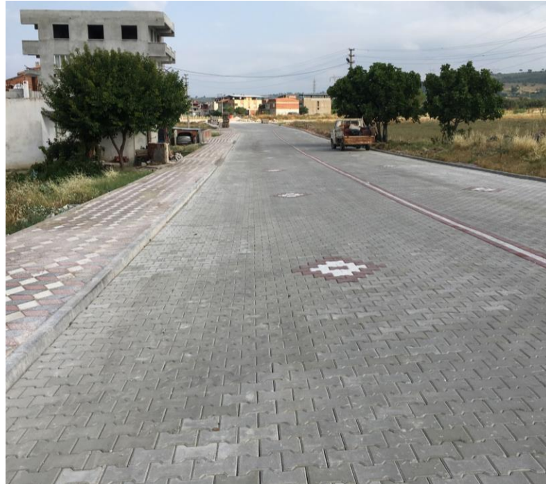
-Ahmet Akşin Caddesi Yol ve Kaldırım Çalışmaları-
