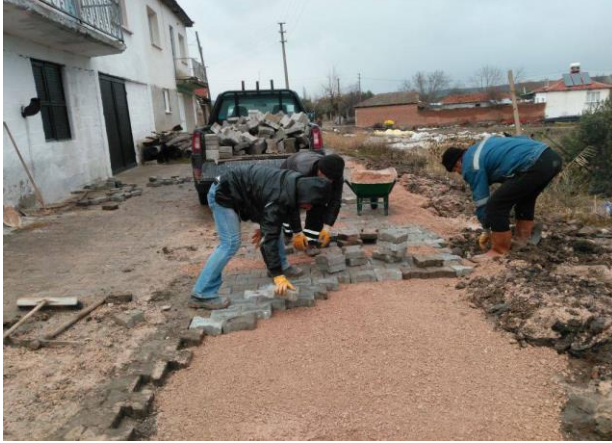
Çerkez Hamidiye Mahallesi Parke Taş Döşeme Çalışmaları
