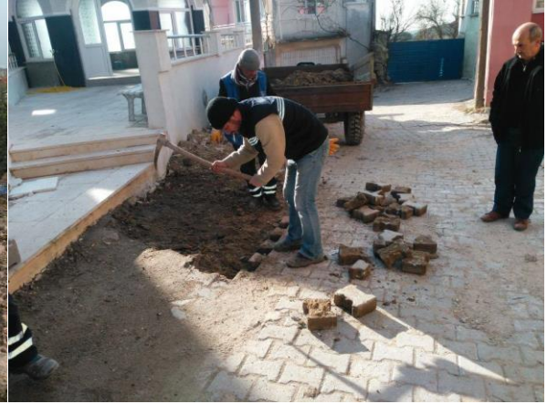
Bayat Mahallesi Parke Taş Döşeme Çalışmaları
