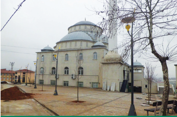
Mimar Sinan Camii meydanında sert zemin yapımı
