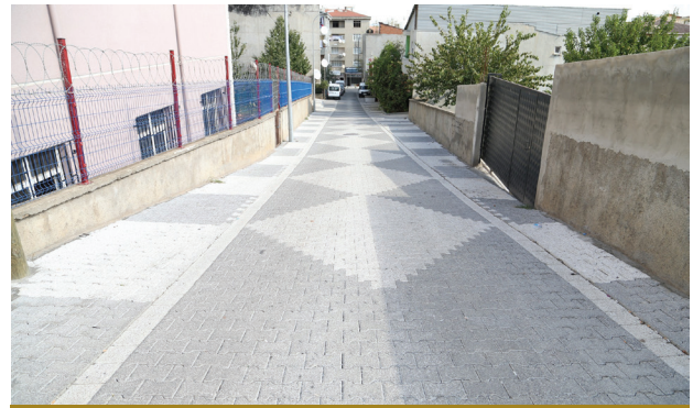
Prestij Yol kaplaması uygulaması
