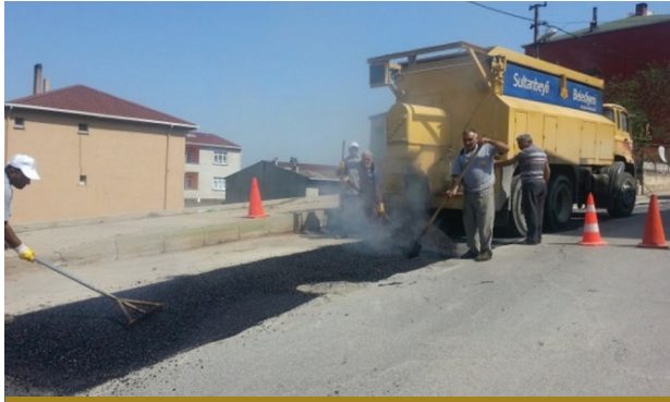
Kısmi deforme olmuş yerlerde asfalt yama çalışması
