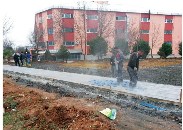
Muhsin Yazıcıoğlu parkında baskı beton uygulaması
