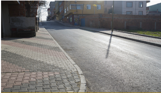
Akşemsettin Mahallesi Kaldırım Çalışması
