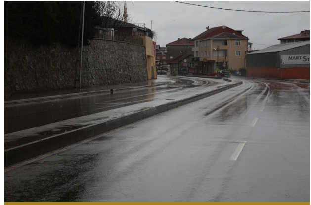
Kuran Kursu Caddesi Betonarme Kaldırım Uygulaması
