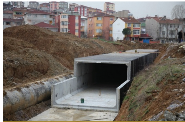
Yol geçişi için yapılan kapalı sistem dere ıslahı
