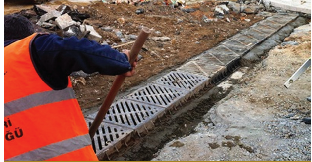
Döşenen Hatlar İle Birlikte Yapılan Bağlantılı Izgaraları
