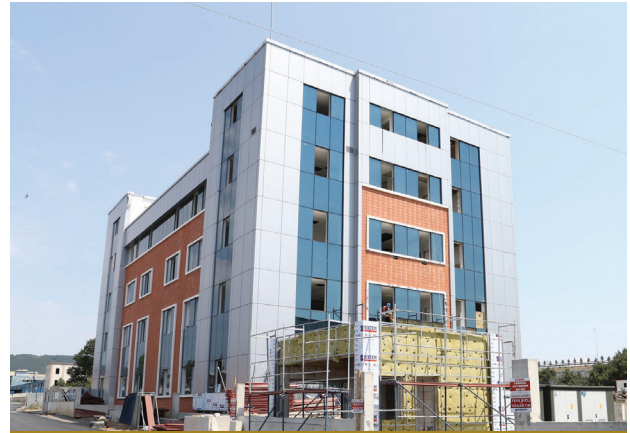
Yapımı Tamamlanan İSKİ Hizmet Binası
