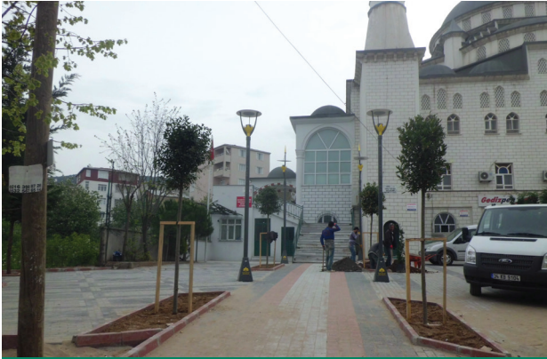
Bağlar Camii bahçesi aydınlatma çalışması
