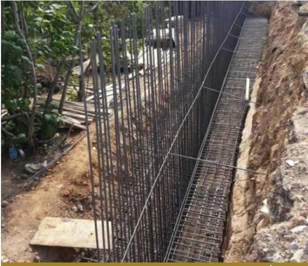
Yavuz Selim Mahallesi Kaptan sokakta betonarme İstinat Duvar Çalışması
