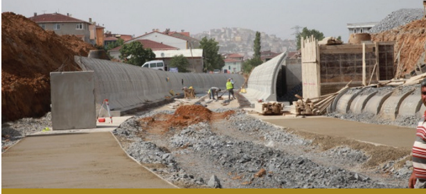
Açık kesit dere ıslahı
