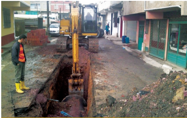
Atıksu Kanallının Döşenmesi
