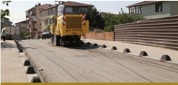
Deforme olan yollarda Trimer ile Kazıma
