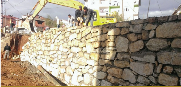
Yol kotu altında kalan yerlerde Taş duvarlar yapıldı
