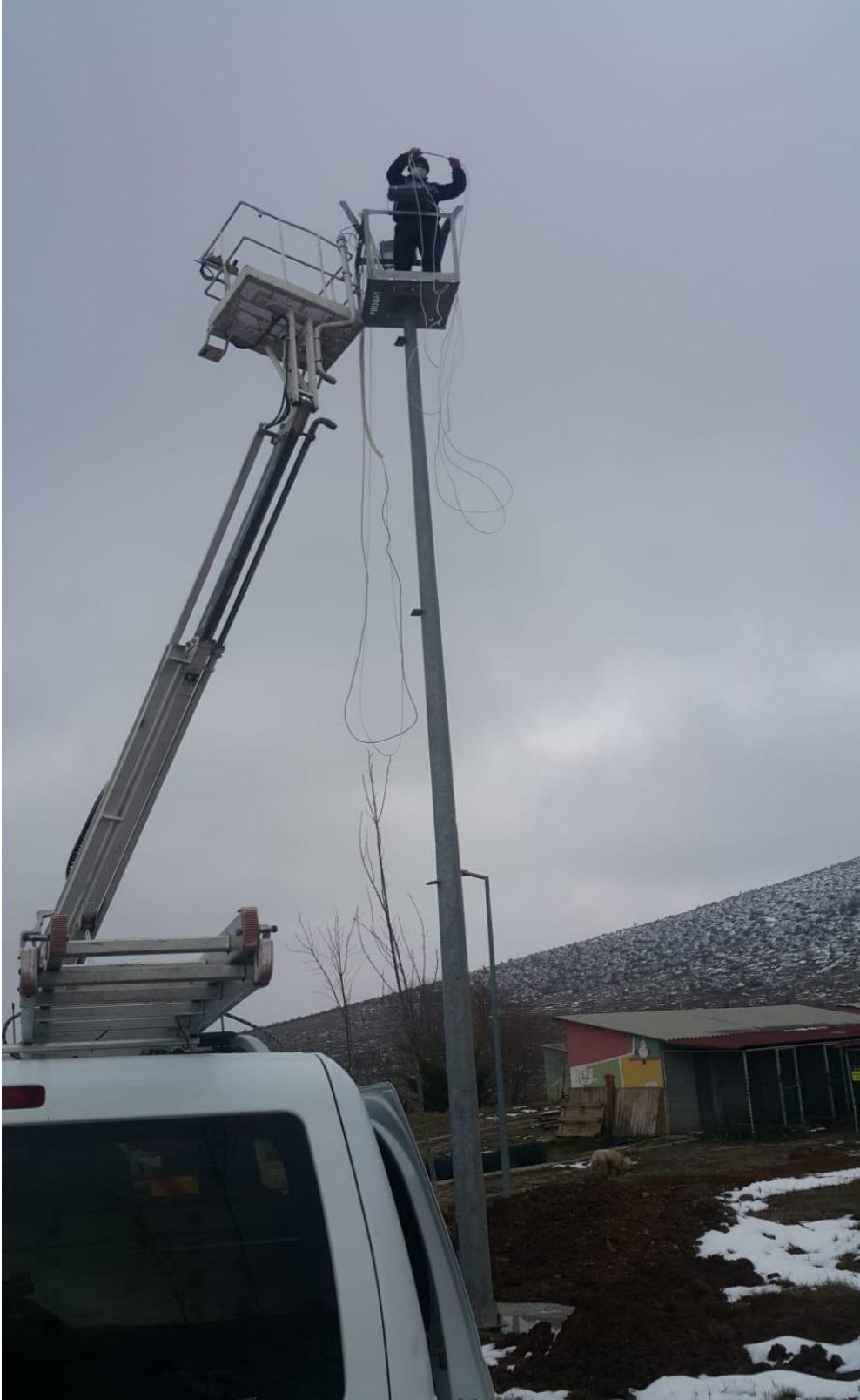
Barınak Çevre aydınlatma çalışmaları
