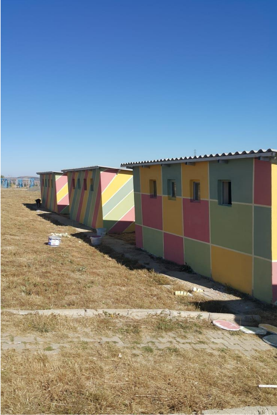
Barınakta bulunan kulübelerimize dış cephe boya çalışması
