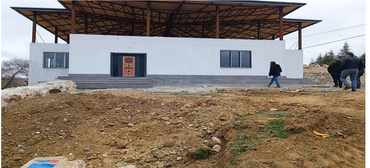
7-Tombak Mahallesi Sosyal Tesis Yapımı.
