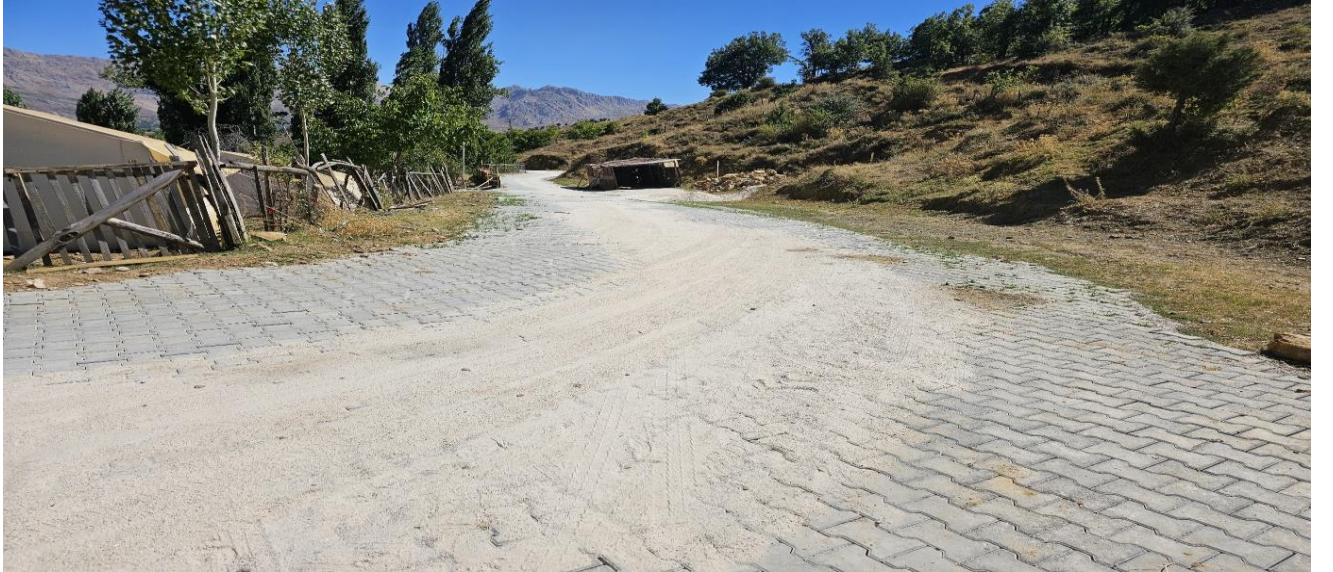
8-GÜLDAĞI MAHALLESİNE 7.390M2 PARKE YAPILDI.
