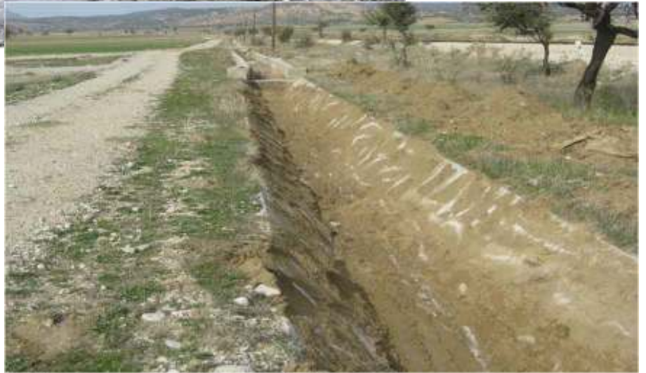
Sulama Kanallarının Temizlenmesi
