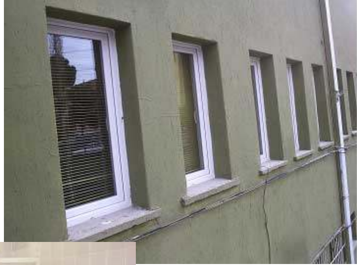
Atatürk Stadyumu Bakım-Onarımı Protokol Tribünü Pencerelerinin Yenilenmesi
