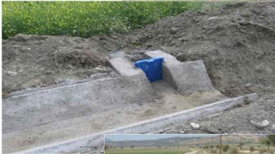
Yeni yapılmakta olan su alım tesisi
