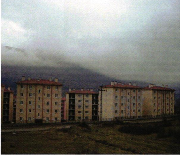
Afet Konutları (4 Adet Daire)
