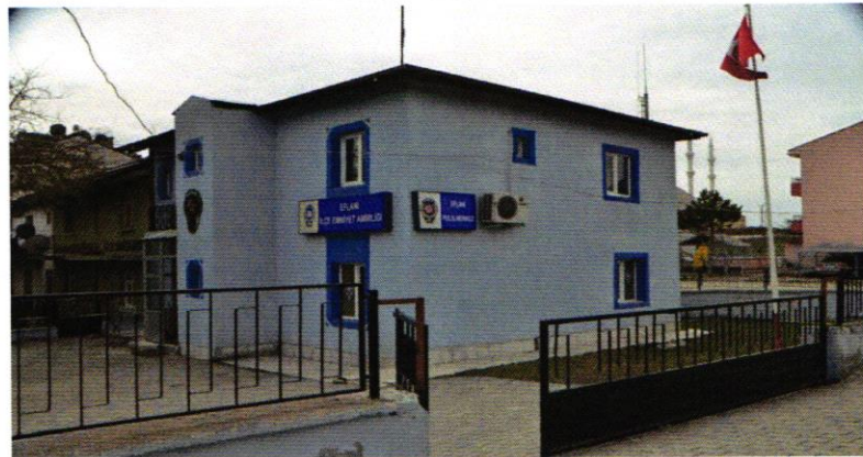
Eski Hizmet Binası
