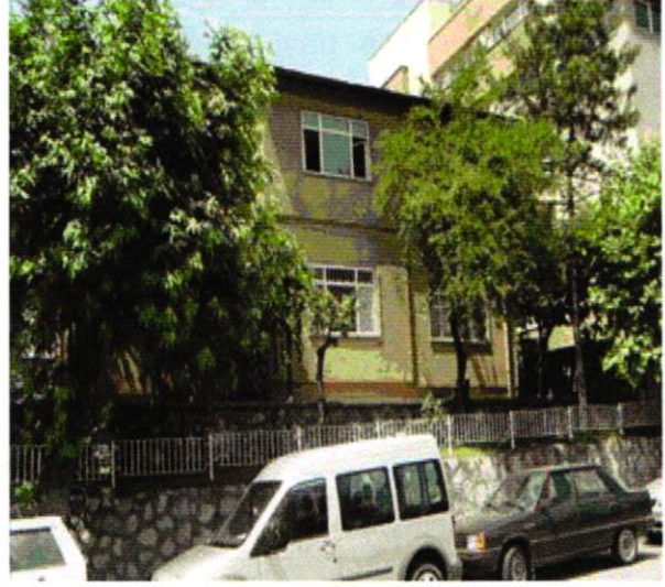
Eski Hizmet Binası
