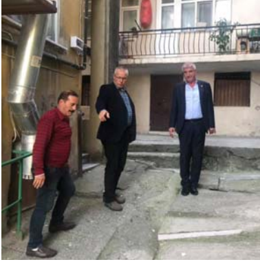
Bekirdere Mahallesi Bozulan,Kırılan ve Yıpranan Merdivenlerin İncelenmesi .
