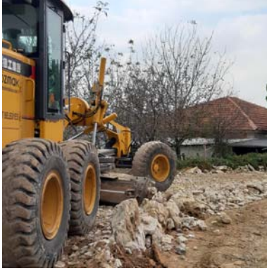
BALÖREN MAH. STABİLİZE MALZEME SERİMİ
