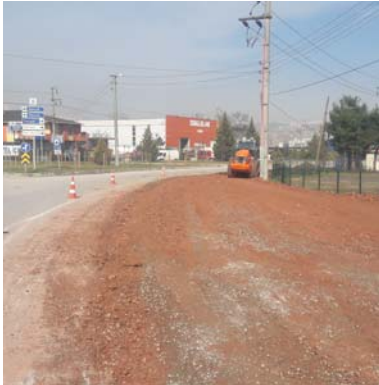
SANAYİ MAH. D130 KARAYOLU CAD. MEKANİK MALZEME SERİMİ
