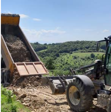
DÜĞMECİLER MAH. STABİLİZE MALZEME SERİMİ
