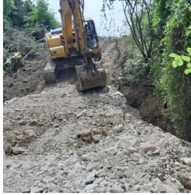
BAYRAKTAR MAH. STABİLİZE MALZEME SERİMİ
