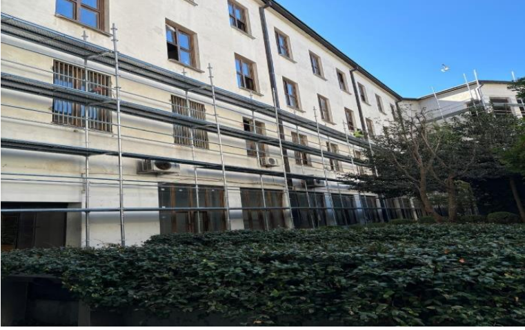
Cephede yapılacak imalat kapsamında uygulama için iskele kurulum aşaması
