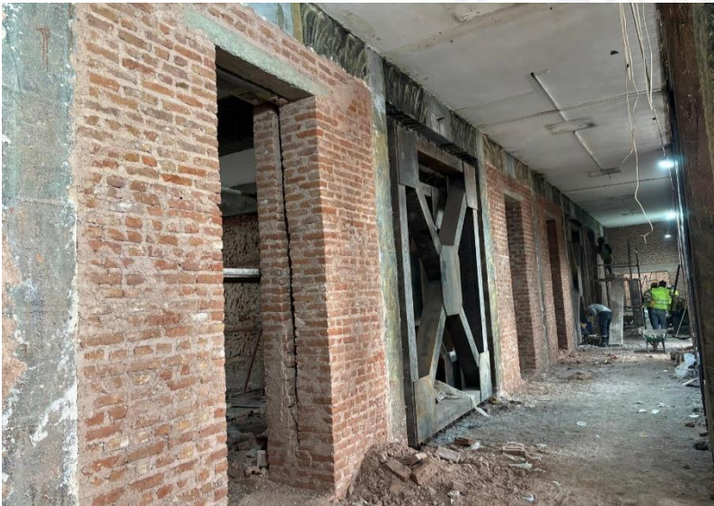
17-17B mimari projeye göre bölme duvar imalatı
