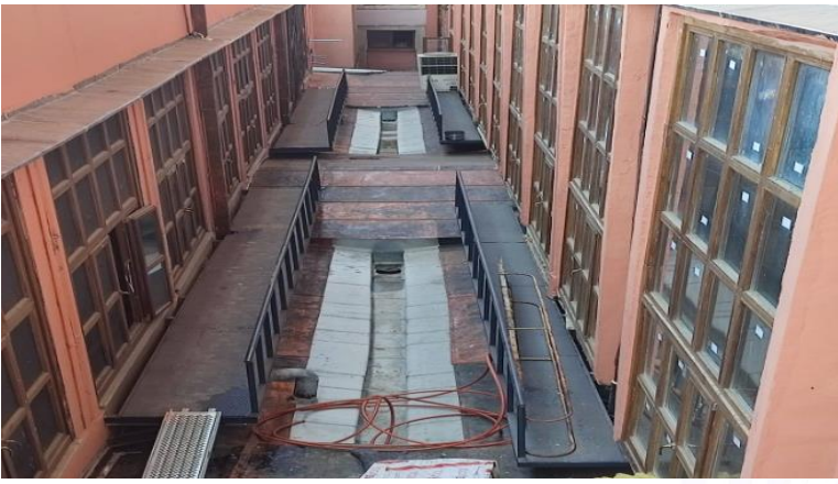
Çatı dere imalatı sonrası
