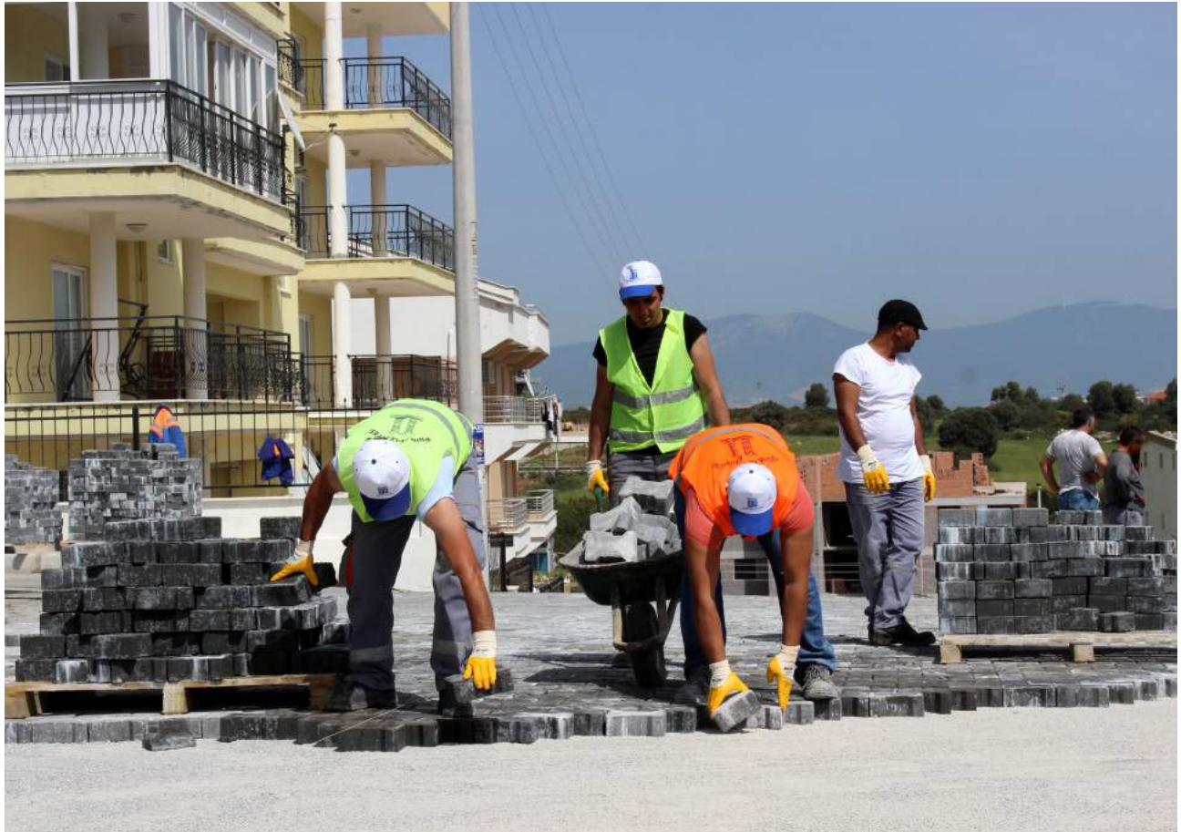
Yol Yapım ve Bakım Çalışmalarından Örnekler (Parke Döşeme)
