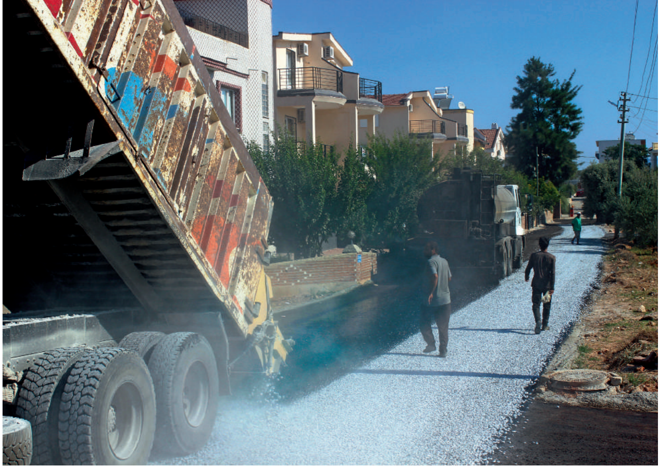
Yol Yapım ve Bakım Çalışmalarından Örnekler (Sathi Kaplama)
