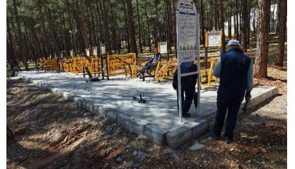
Arslanbey Mesire Alanı Spor Aletleri Montajı
