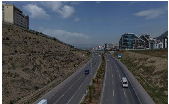
Önsen Yolu Refüj ve Kavşak Düzenleme Çalışması
