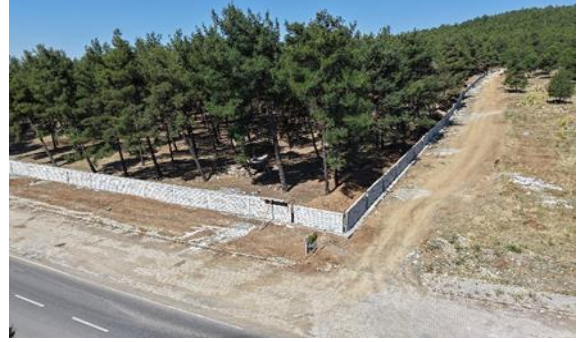
Hayvan Barınağı Duvar Çalışması
