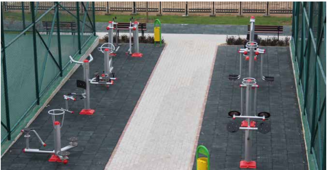
Uluslararası Murat Hüdavendigar Anadolu İmam Hatip Lisesi bahçe düzenlemesi ve spor parkı yapımı.
