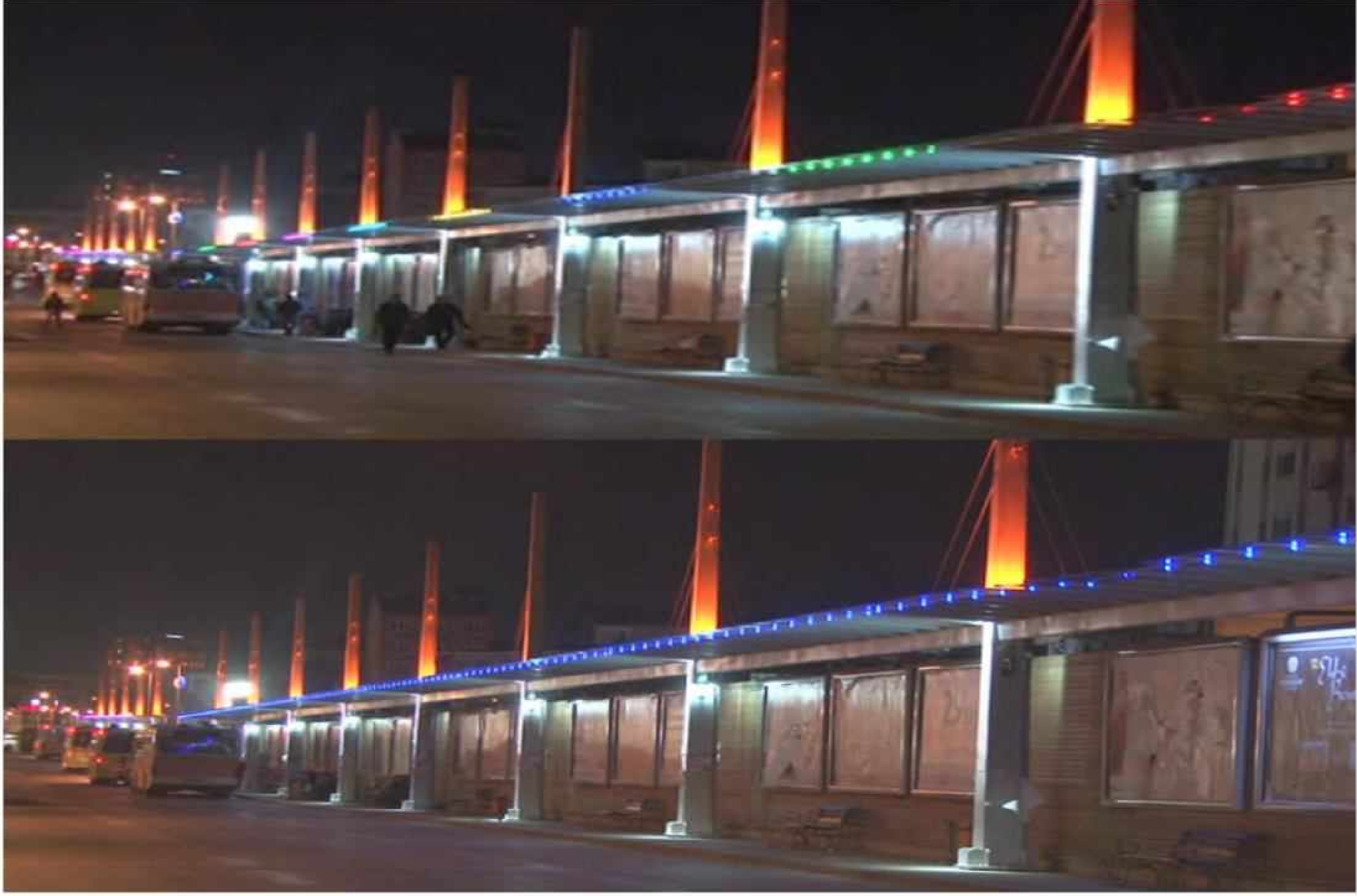
Adliye Durağı Dekoratif Aydınlatma Yapımı
