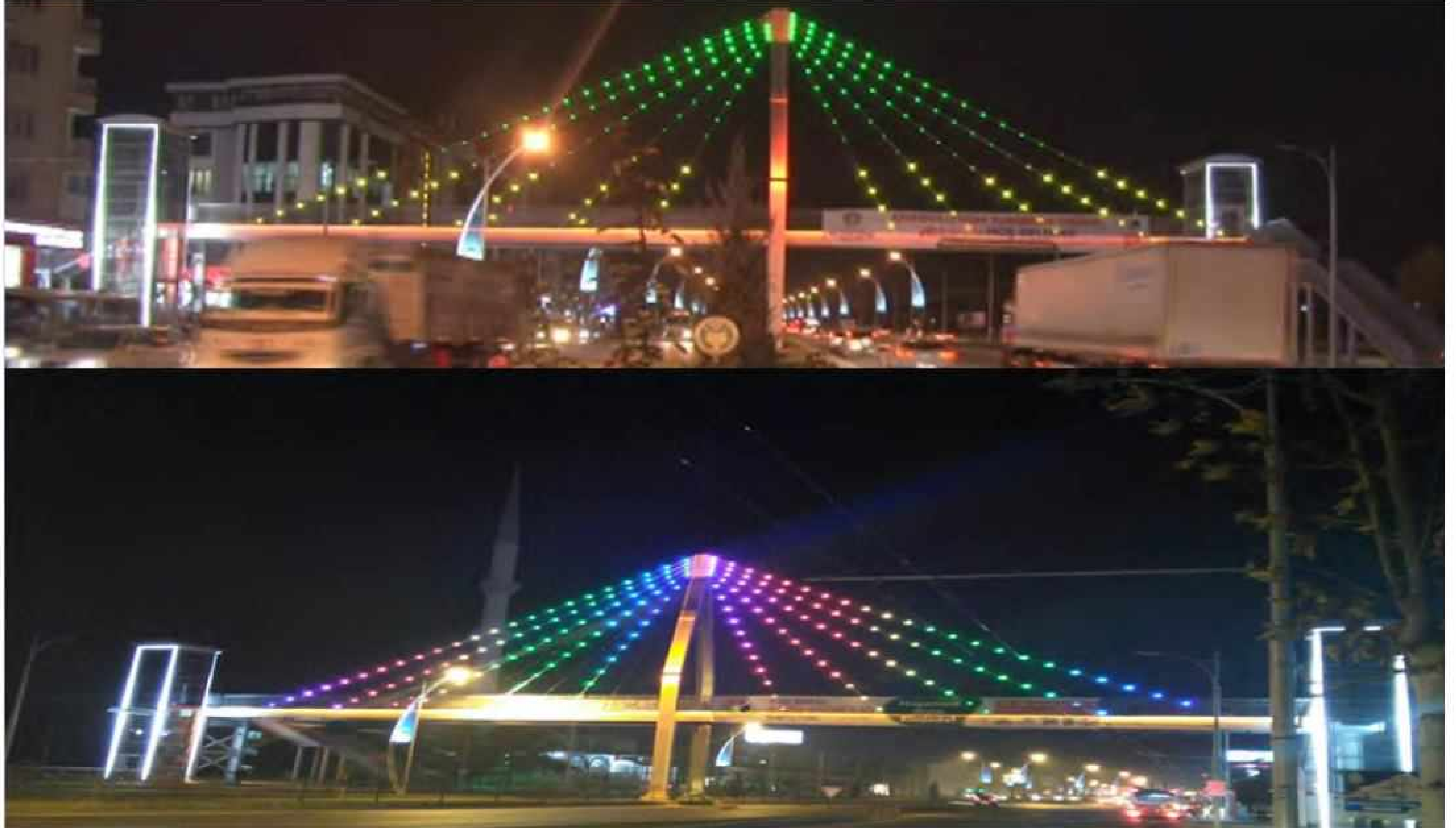
3 Adet Tata Üst Geçidine Dekoratif Aydınlatma Yapımı
