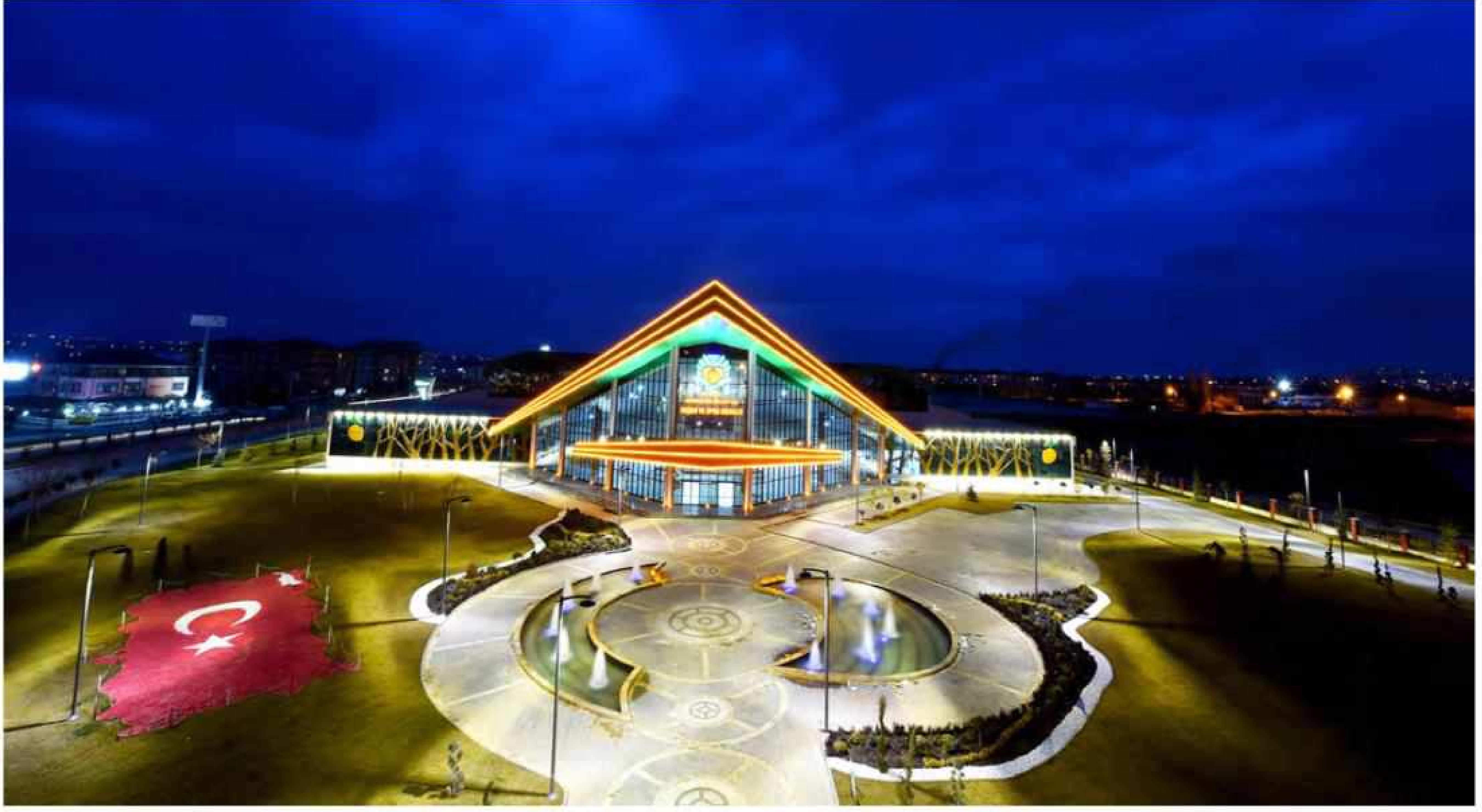
Yaşam ve Spor Merkezi Aydınlatma Yapımı
