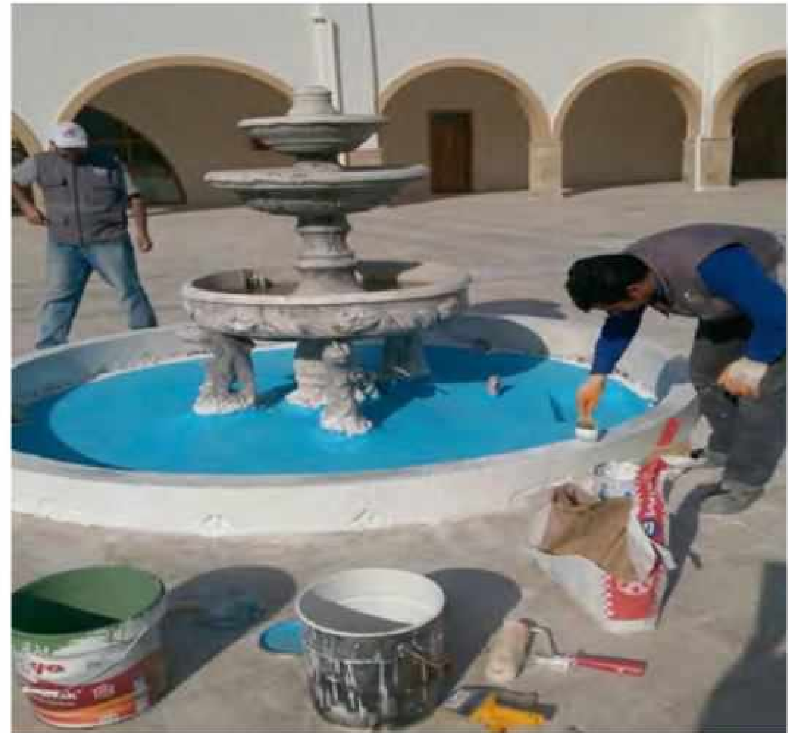
Havuzların su yalıtımının yapılması
