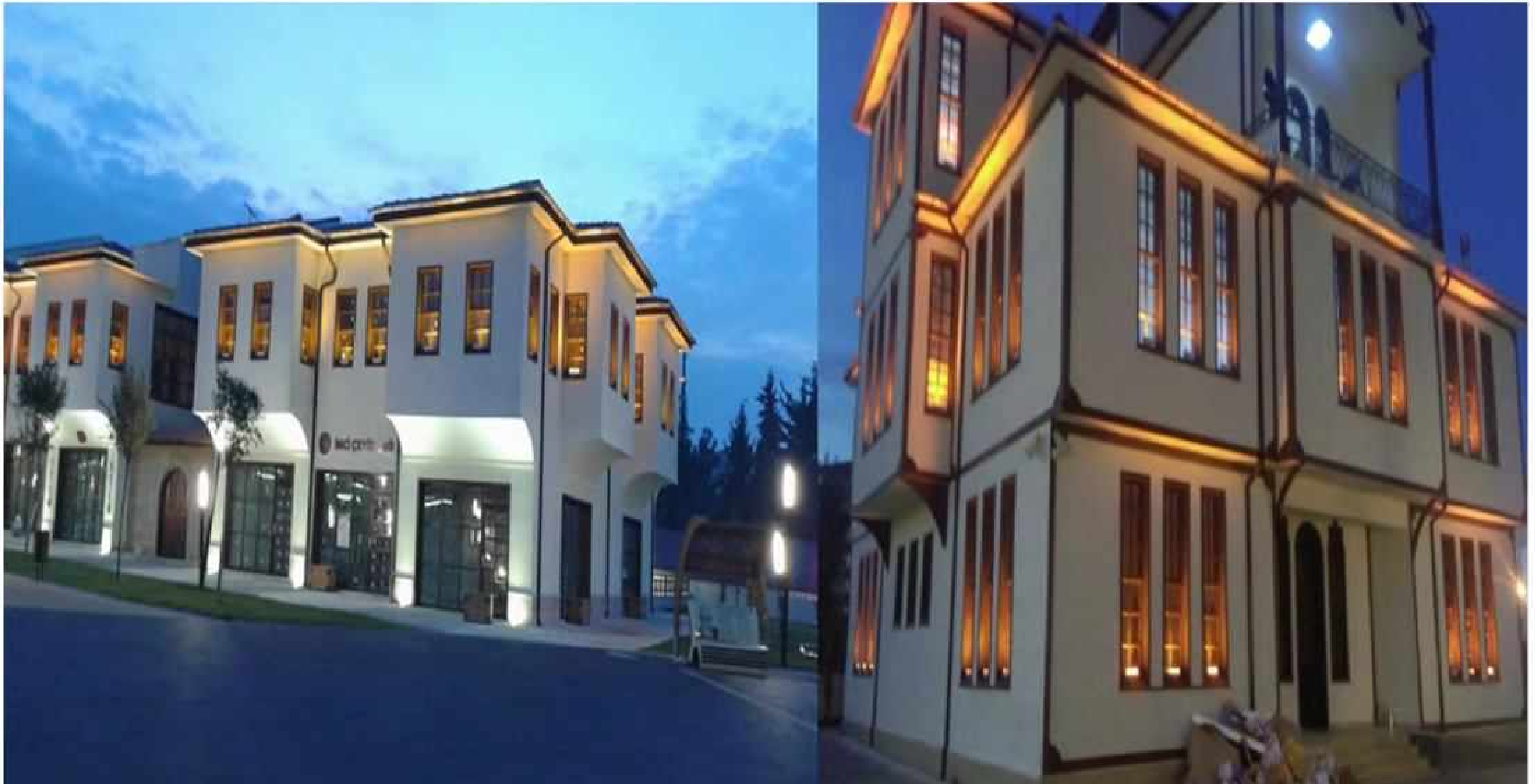
Sanat Sokağı Cephe Aydınlatma Yapımı
