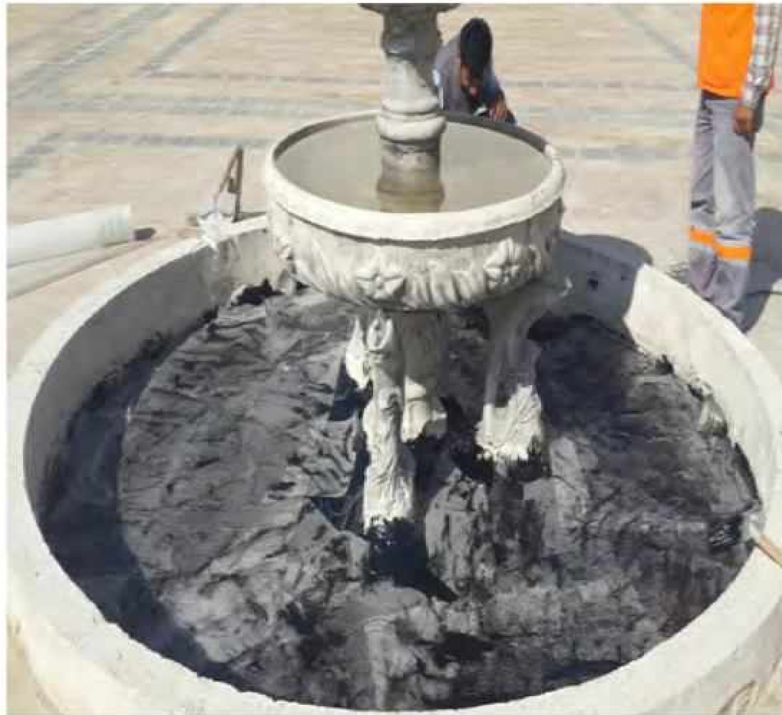
Havuzların su yalıtımının yapılması
