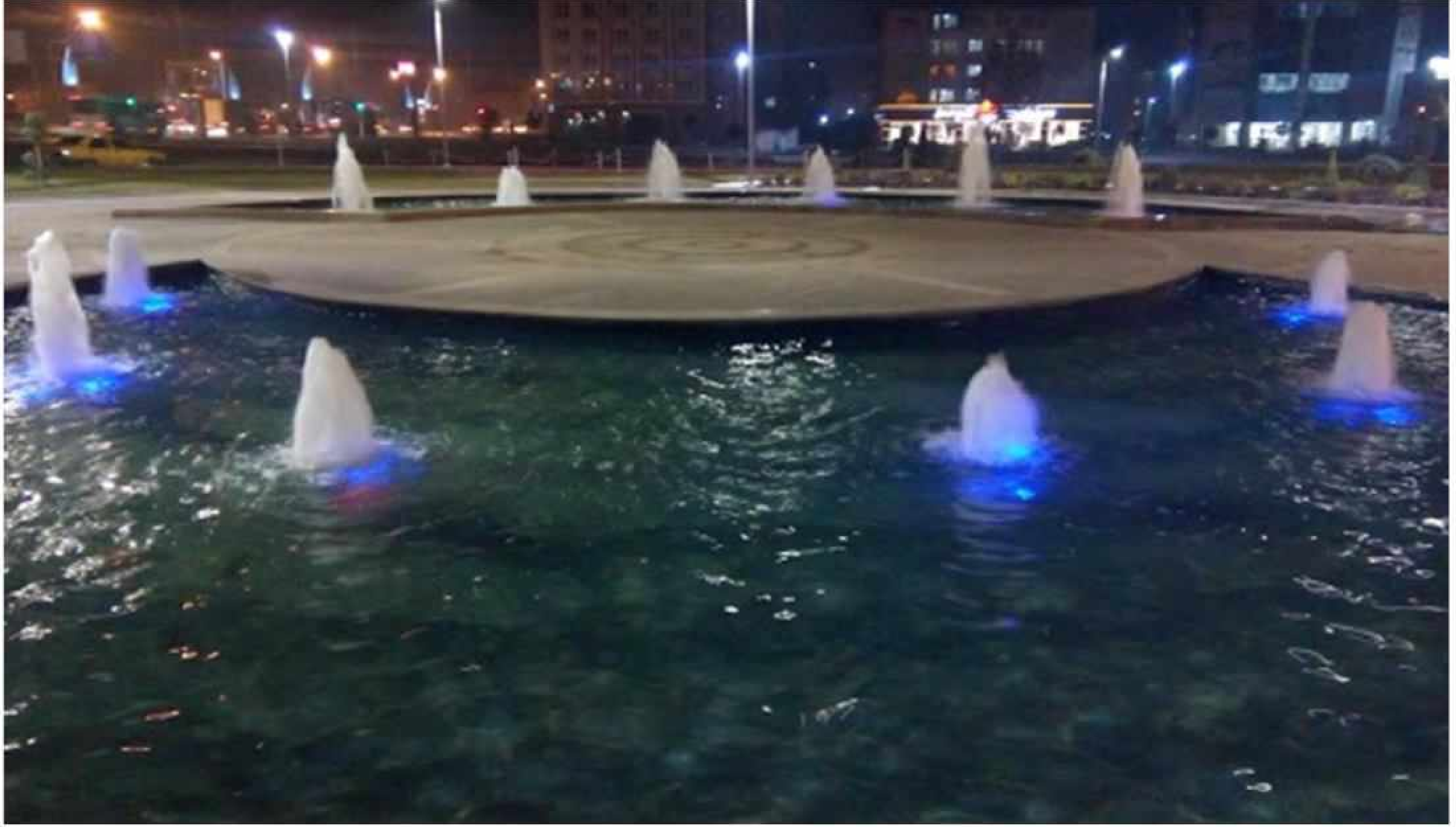
Yaşam ve Spor Merkezi Havuz Aydınlatma Yapımı
