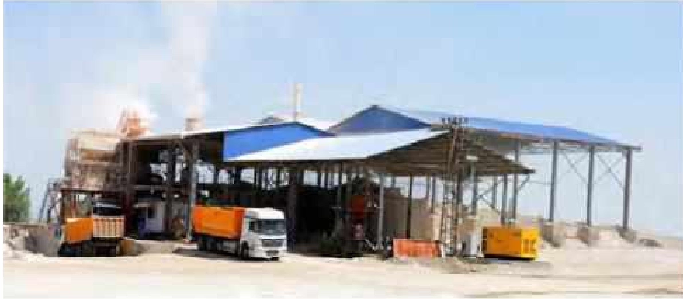
ASFALT ÜRETİM ŞANTİYESİ
