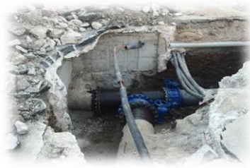
İçme suyu Hat Tamirati
