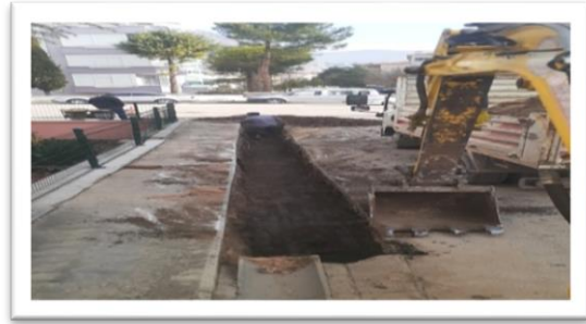
Akbilek Mah.Viyadük altı yağmur hattı yapımı
