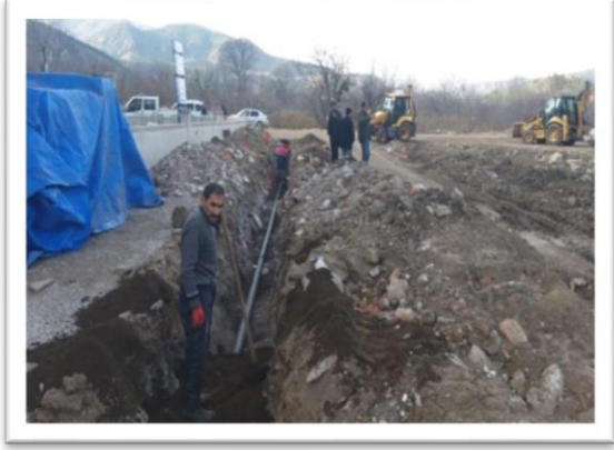
Göllü Bağları Mah. İçme suyu hat yapımı
