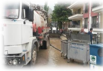
İçme suyu Arıza çalışması
