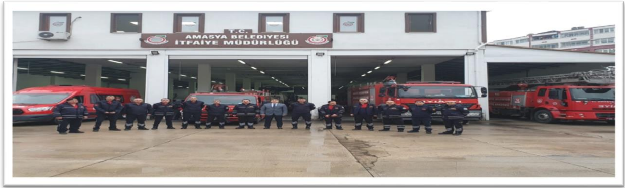
İtfaiye Hizmet Binası
