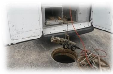
Kanalizasyon Hatlarının kamera ile Kontrolü
