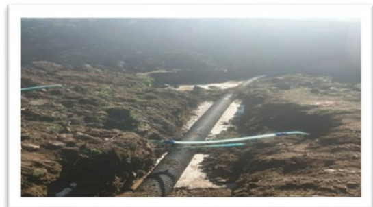
Boğazköy Mah. Okul Altı Kan. Hattı Yapımı
