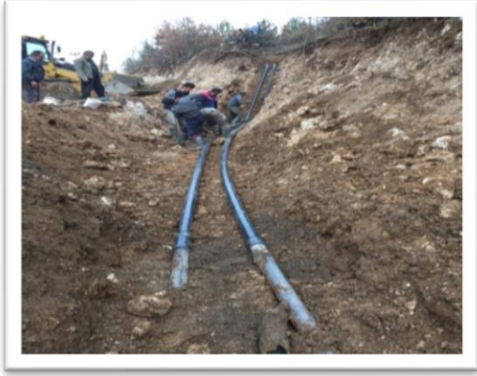
Çakalllar Mah. Su hattı yapımı
