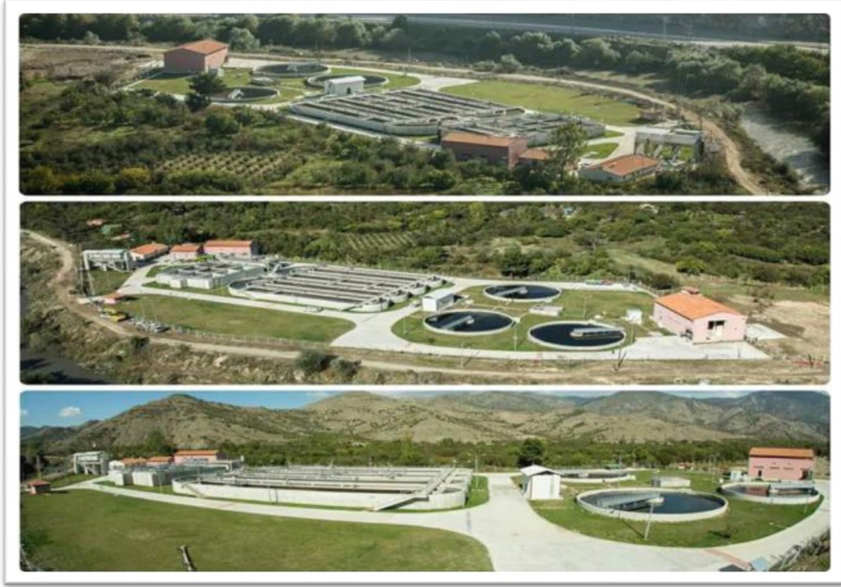
Amasya Atıksu Arıtma Tesisi
