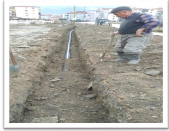
Şeyhcu Mah. İçme suyu hat yapımı
