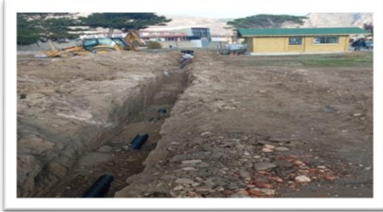
Hızırpaşa Mah. Stadyum Yanı Kan. Hattı Yapımı
