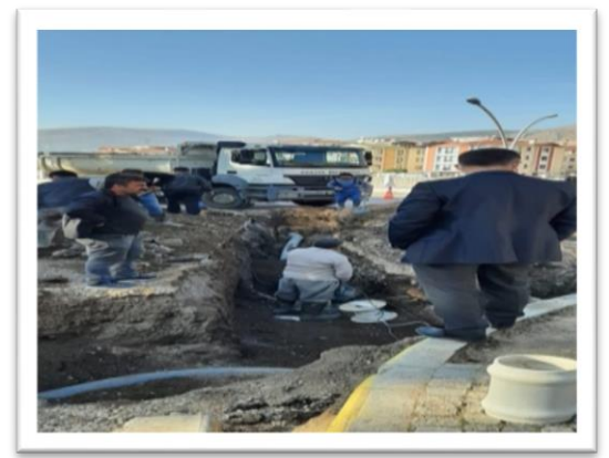
Hacılar Meydanı Nihal Atsız Cad. Su hattı yapımı
