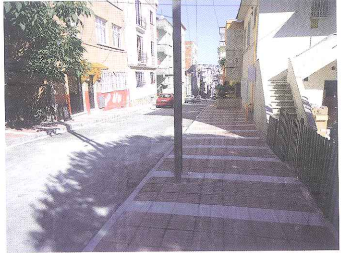
Yenidoğan mah.Kaldırım Çalışmaları
