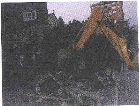
2. bulvar yolu üzerinde açılan kaçak temel inşaatı yıkımı.
