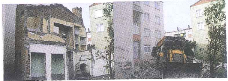
14/11/2011 tarihinde Selahiye Mah. Şen Sokak. No:6 adresindeki metruk binanın yıkımı.
