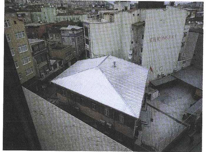
Subaşı İlköğretim Okulu çatısı yapılmıştır
