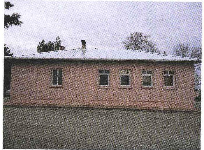
Uzgur İlköğretim Okulu Dış boya yapılmıştır
