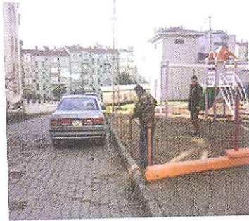
Kaynak işleri çalışmaları
