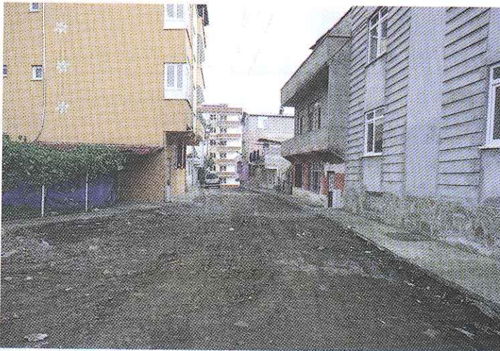
Kafes sokak ESKİ HALİ
