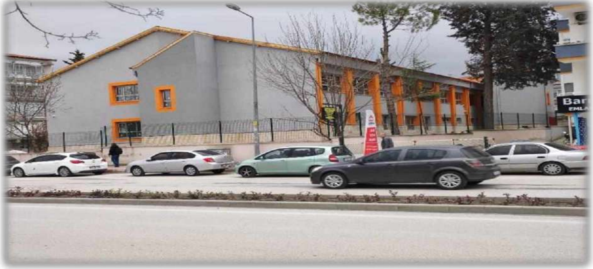
Rehberlik Araştırma Merkezi Deprem Güçlendirme Yapım İşi
