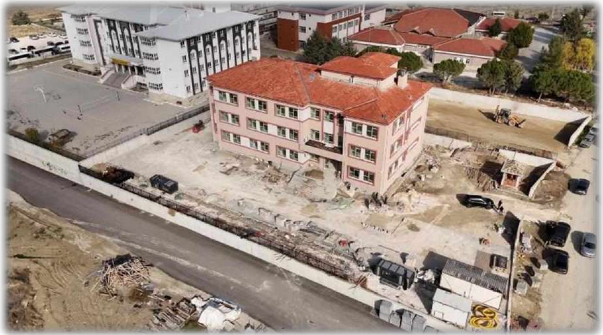
Merkez 16 Derslikli İbn-i Sina MTAL Yapım İşi
