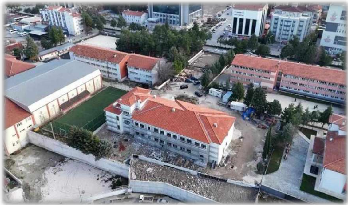
Merkez 8 Derslikli Spor Lisesi Yapım İşi
