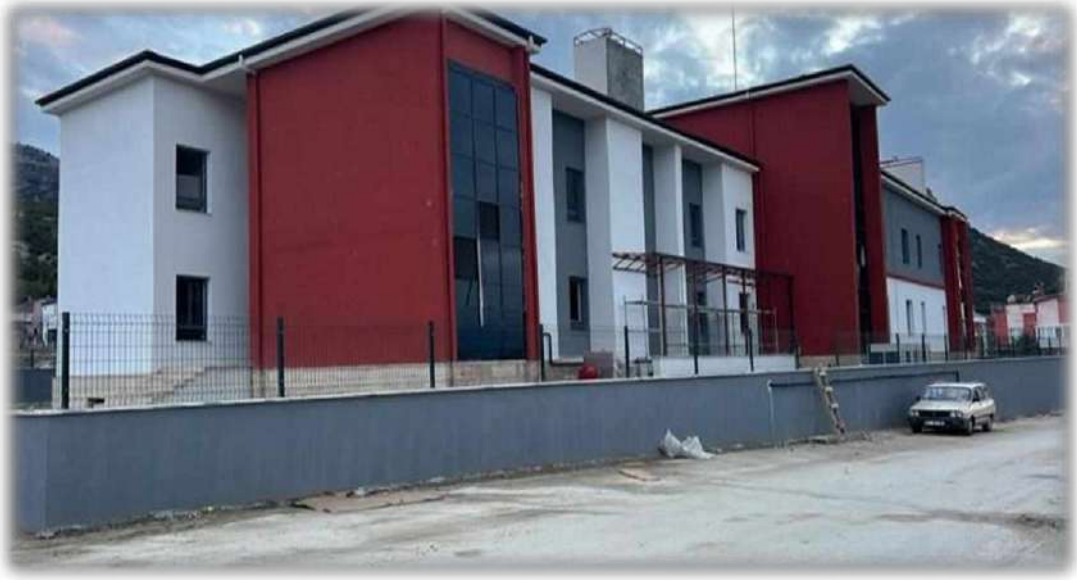
Rehberlik Araştırma Merkezi Yapım İşi
