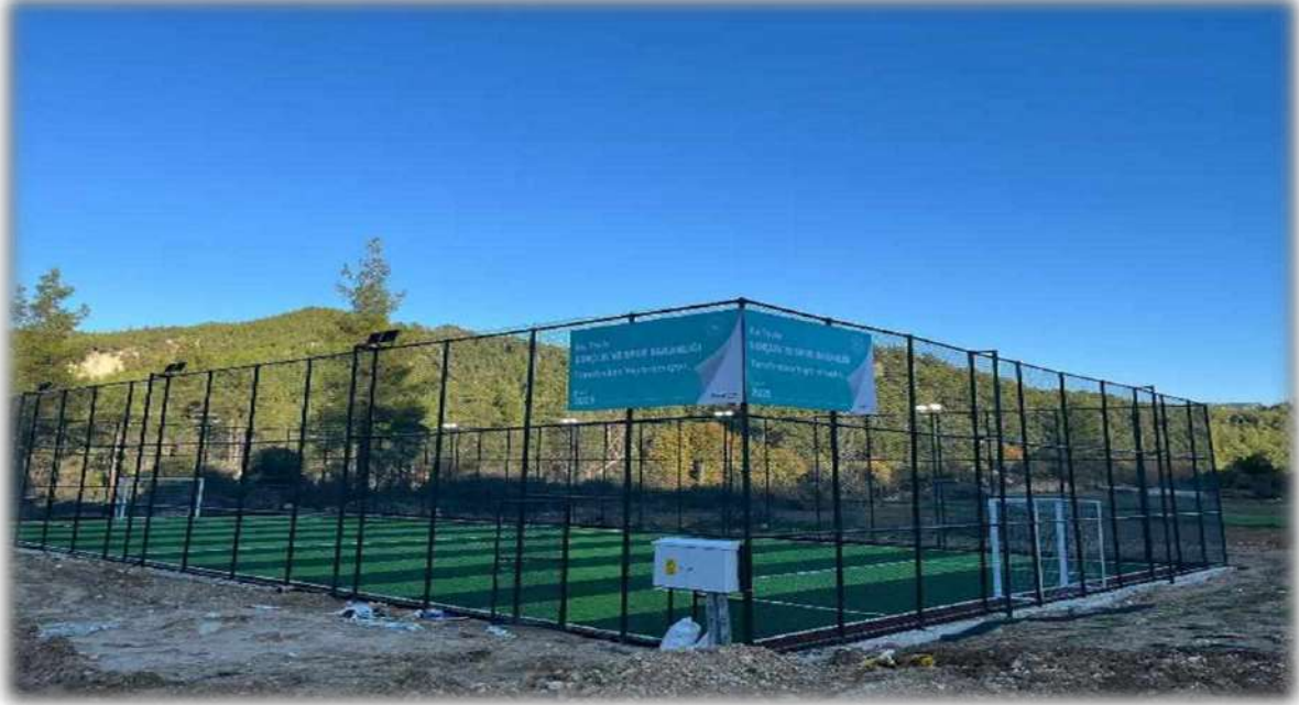
Bucak Çobanpınar Köyü Halı Saha Yapımı İşi
