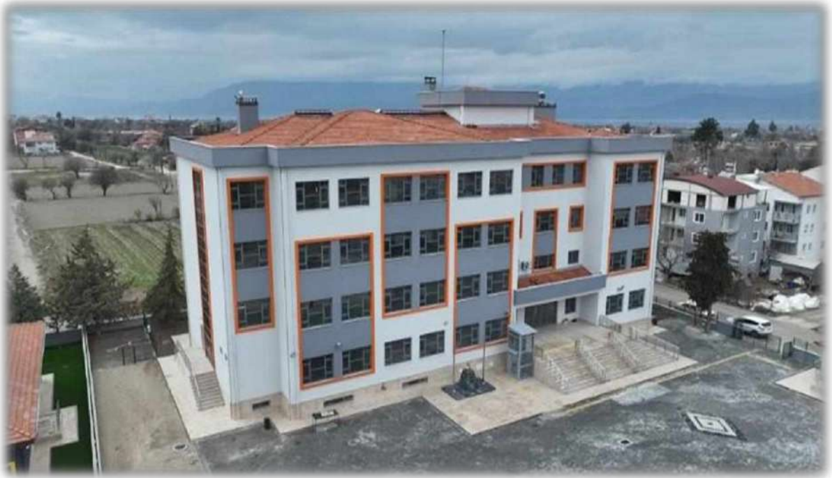
Merkez Vali Dr. Süleyman Oğuz 16 Derslikli İ.Ö.Okulu Yapım İşi
