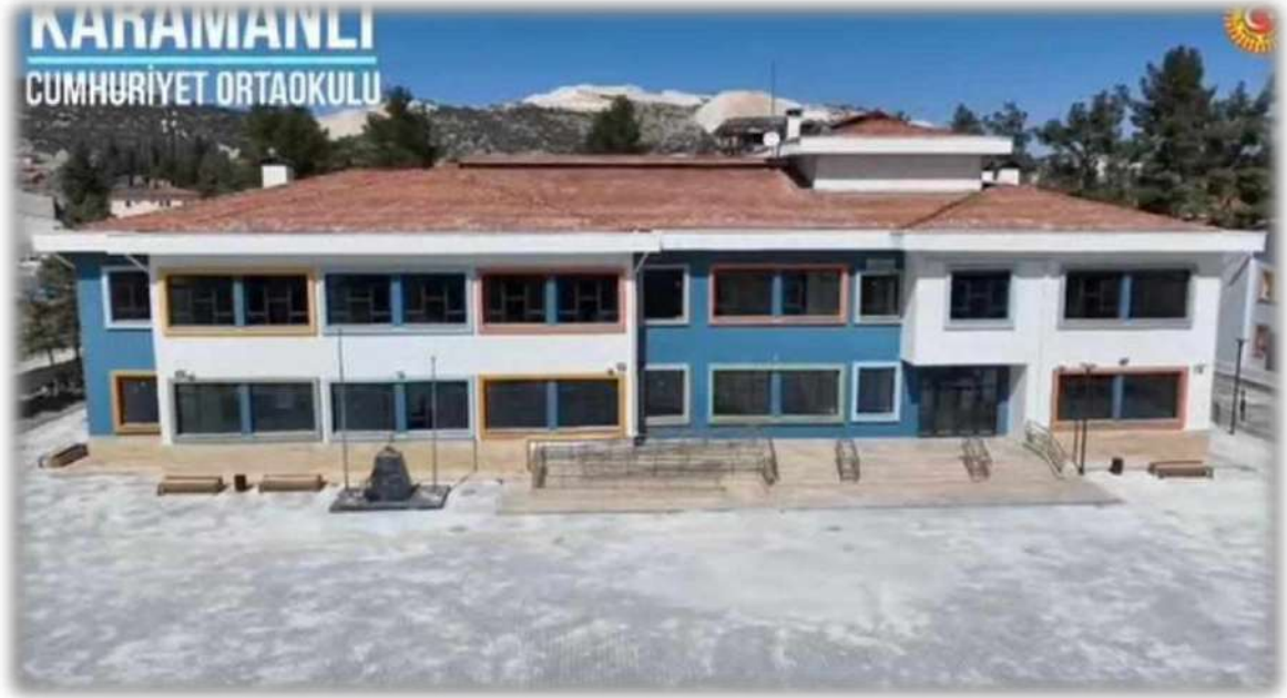
Karamanlı 8 Derslikli Cumhuriyet Ortaokulu Yapım İşi
