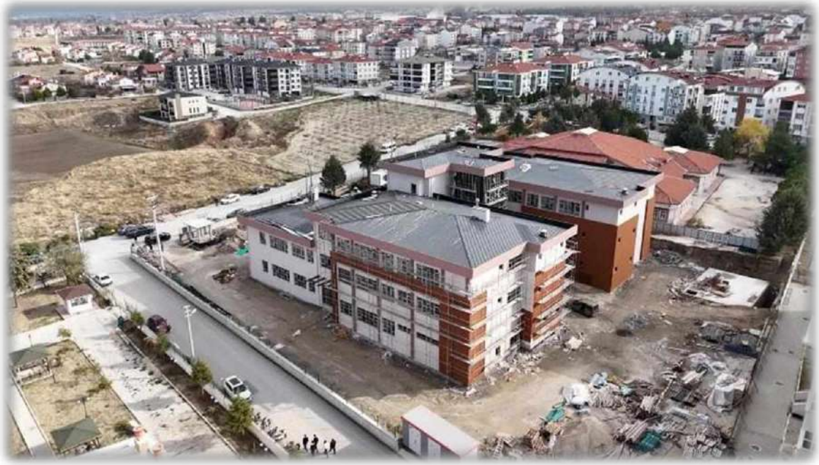
Merkez 16 Derslikli Özel Eğitim Uygulama Binası Yapım İşi
