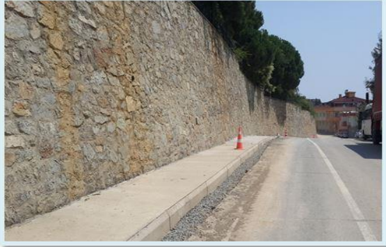
Betonarme Duvar Çalışması
