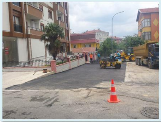
Asfalt Yama Çalışması
