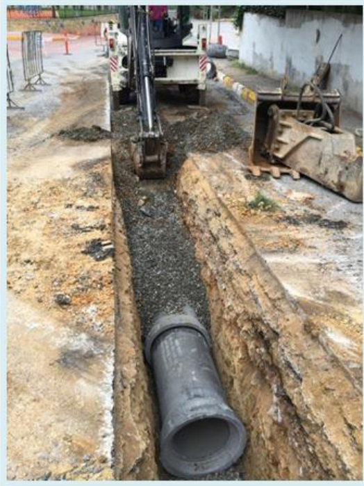
Yağmur Suyu Kanalı Çalışması
