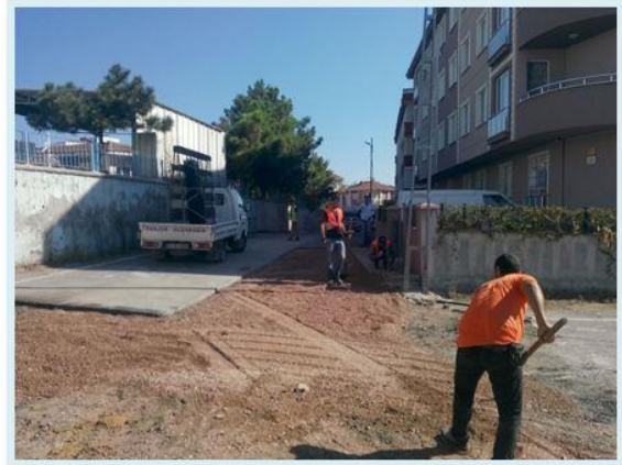
Yol Genişletme Çalışması
